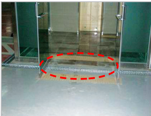
■ 동출입구 트렌치 오픈형 커버 설치
