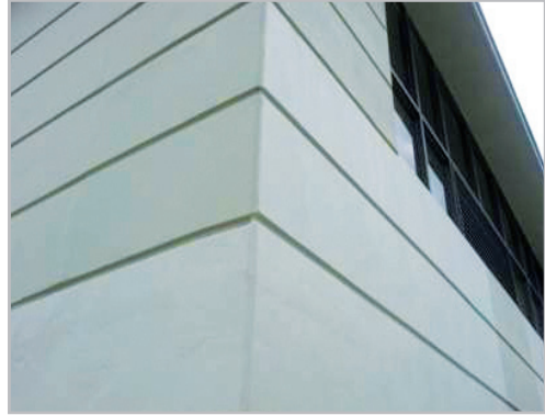
■ 옥탑 시공 줄눈 바탕면 면처리 보완
