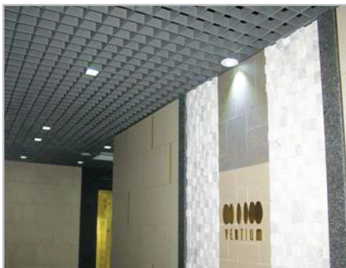
■ 지하층 및 1층 E/L홀 벽면 및 천장 특화
