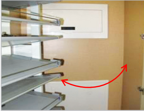
■ 현관 신발장 내부 시스템 선반 설치로 분전반 및 통신단자함 유지 관리 개선
