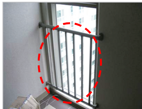
■ 계단참 창호 안전난간 및 오물방지턱 설치
