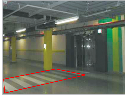
■ 동출입구 바닥 안전 표시 설치 (횡단보도 등)
