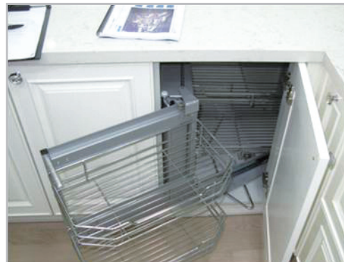
■ 주방 싱크대 코너 시스템 선반 설치
