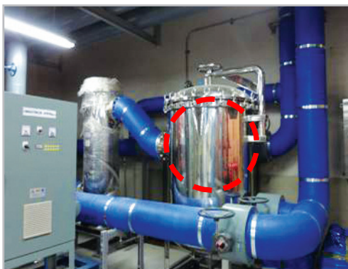
■ 정수시스템 사양 및 운전요령서 미부착
