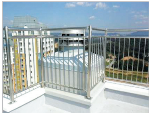
■ 옥상 무동력흡출기 주변 안전 난간 설치
