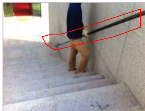
■ 보행로(램프, 계단 등) 핸드레일 설치
