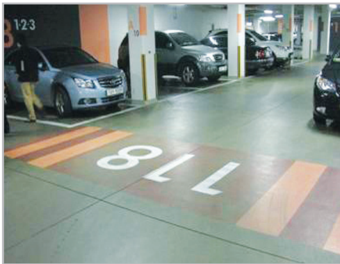
■ 지하주차장~동출입구 바닥 그래픽 도장
