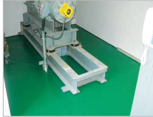
■ E/L기계실 바닥 에폭시(우레탄)도장
