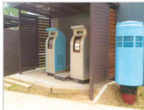
■ 쓰레기 이송 설비 지붕 설치
