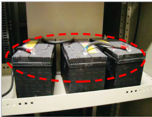
■ 배터리반 배터리 고정 미흡
