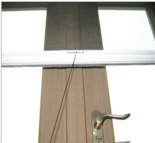
■ 대피공간 출입문 방충망 설치 및 고정 클립바 사용 고려(높이 과다로 사용 불편)
