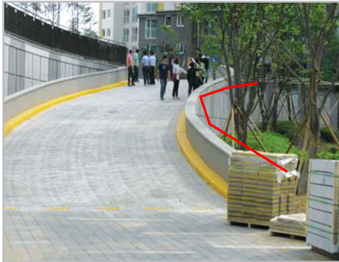
■ 옹벽형 보행로(경사로, 계단 등) 안전 난간 미설치
