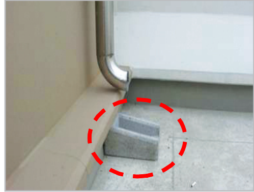
■ 옥탑 선홍통 하부 물받이돌 설치
