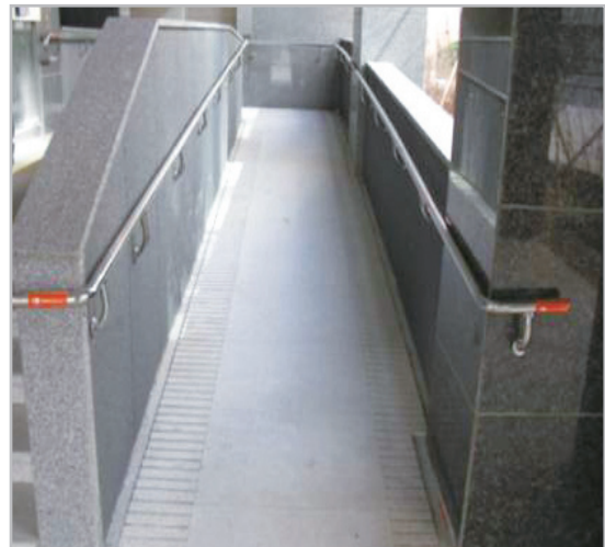
■ 주출입구 경사로 핸드레일 설치 및 바닥면 미끄럼 방지 처리
