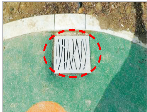
■ 어린이놀이터 트렌치 폐쇄형 커버 설치
