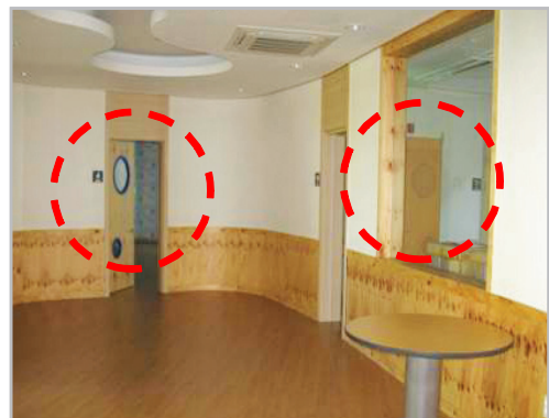
■ 복도 및 출입문 등은 감시형 구조로 설치
