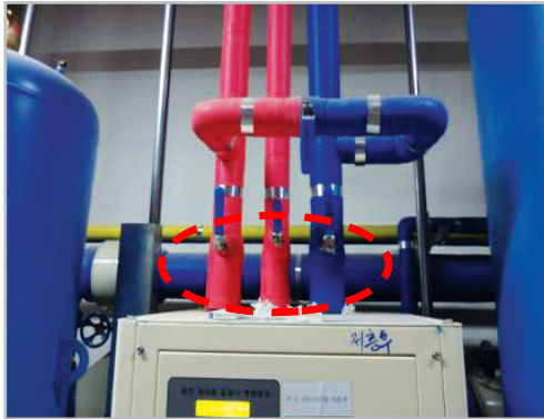
■ 팽창탱크 볼밸브 자루 설치
