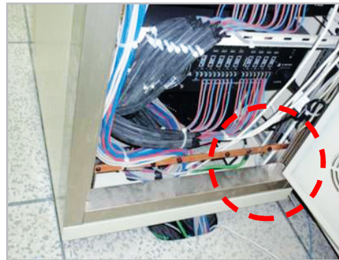
■ 각종 수신반 외함 접지 시공
