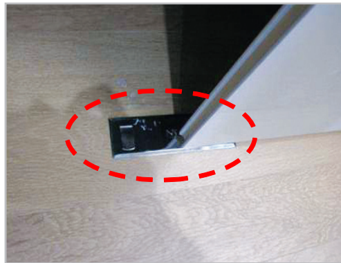
■ 부부침실 드레스룸 하부 자석매입형 스토퍼 설치
