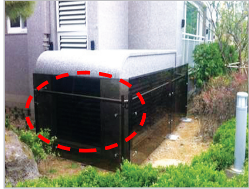
■ D.A.(배기) 유도 패널 설치
