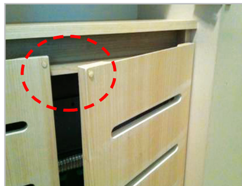
■ 접촉 부위 완충구(눈물) 설치
