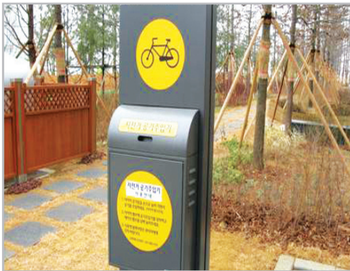
■ 태양열 이용 자동공기 주입기 설치
