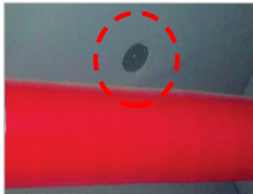
■ 전기풀박스 망커버 설치
