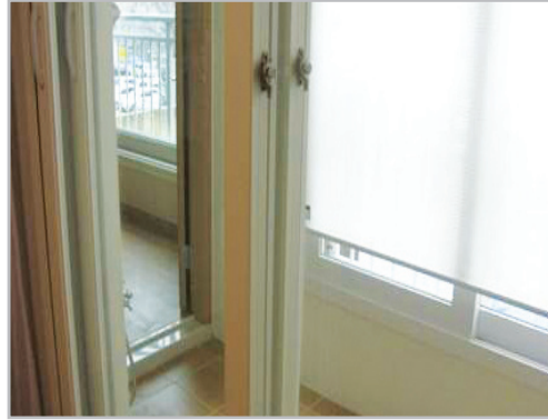
■ 부부침실 발코니 분합문 2중 창호 설치
