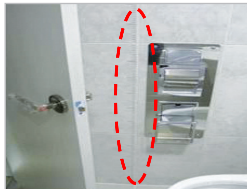
■ 욕실 벽면 키높이 눈금자 타일 설치
