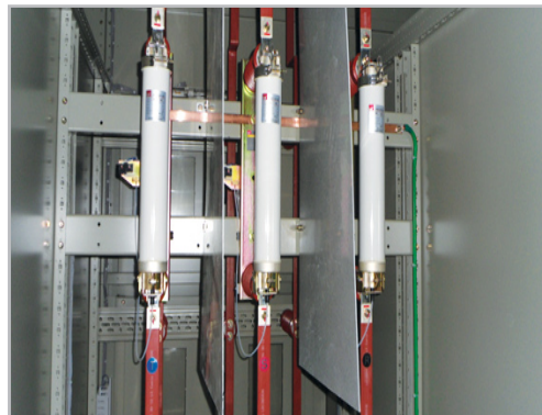
■ 파워휴즈 상간 격벽 설치
