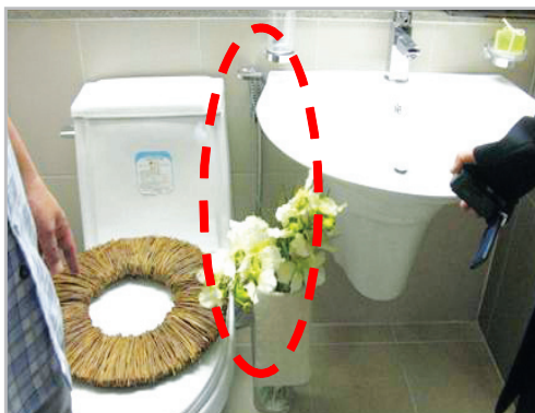
■ 욕실 청소용 수전(건타입) 설치
