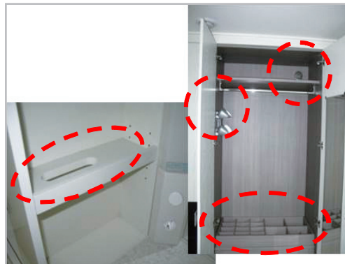
■ 드레스룸 화장대 휴지걸이 설치 ■ 침실 붙박이장 내부 액세서리(선반, 거울, 타이걸이 등) 설치
