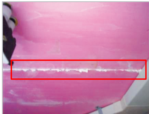
■ 천장 단열 결손 부위 우레아폼 충전
