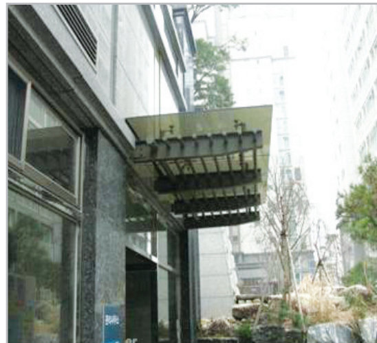
■ 필로티(주동선) 낙하방지물 캐노피 설치 사례
