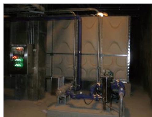
■ 중수도 시스템 사용으로 조경용수 및 생태 연못 등에 활용
