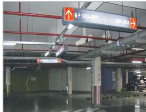
■ 사각지대 안전시설(반사경, 행거형 싸인물, 바닥 그래픽 도장 등) 설치
