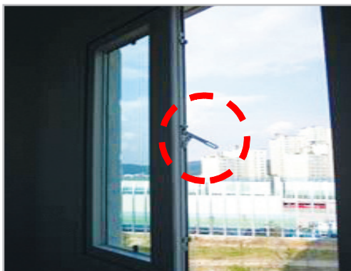
■ 대피공간 창호 개폐 레버 (상하부 꺾임쇠 동시 작동) 설치
