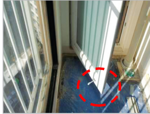
■ 출입문 하부 충격완충장치 설치
