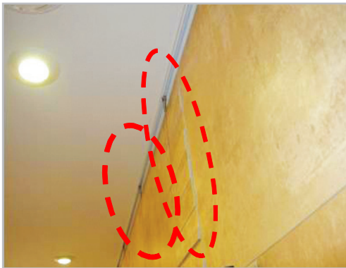
■ 세대 벽면 상부 그림걸이 레일 설치
