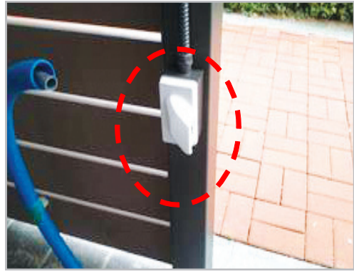
■ 쓰레기분리수거장 콘센트 방우형으로 설치
