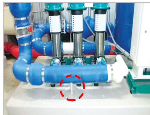
■ 부스터 펌프 토출 배관 지지 가대 설치
