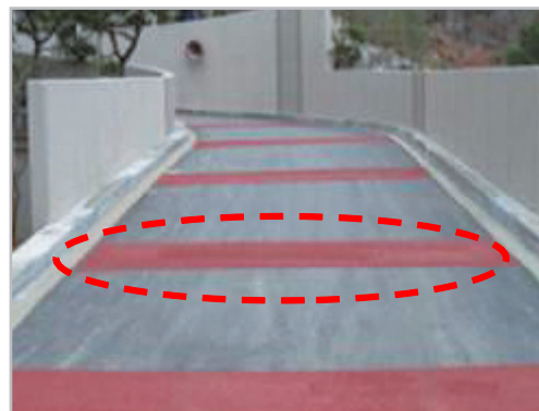
■ 급경사로 표면 미끄럼 방지 포장 시공(또는 바닥 내부 열선 시공)
