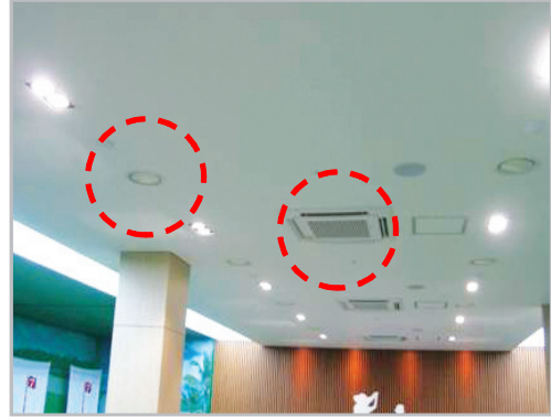
■ 골프연습장 강제환기설비 및 시스템 에어컨 설치(권장)
