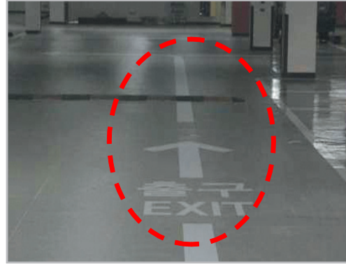
■ 지하주차장 출구 안내 바닥 싸인물 설치
