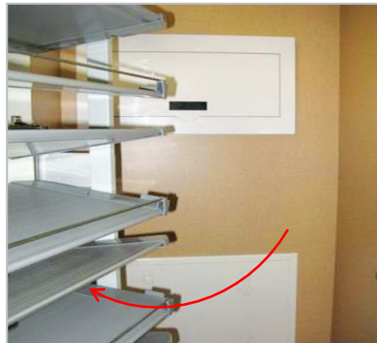
■ 현관 신발장 내부 시스템 선반 설치로 세대분전반(통신단자함) 유지 관리 편의 도모
