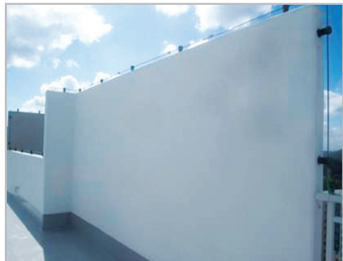
■ 옥상 피뢰설비 접지 본딩 시공
