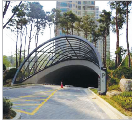
■ 지하주차장 출입로(램프) 우수 유입 차단, 동절기 미끄럼 방지 대책으로 지붕(자연돔) 설치 사례
