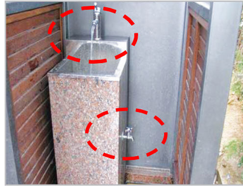
■ 쓰레기분리수거장 개수대(청소용 및 세수용) 및 배수(오수관 연결) 설치
