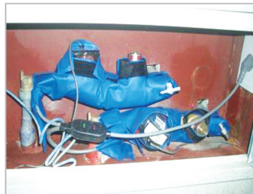
■ 동파 방지 열선 설치
