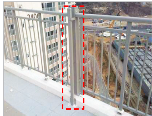
■ 옥상 난간대 추가 지지대 설치
