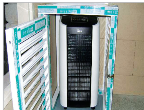
■ 지하E/L홀 제습기 설치
