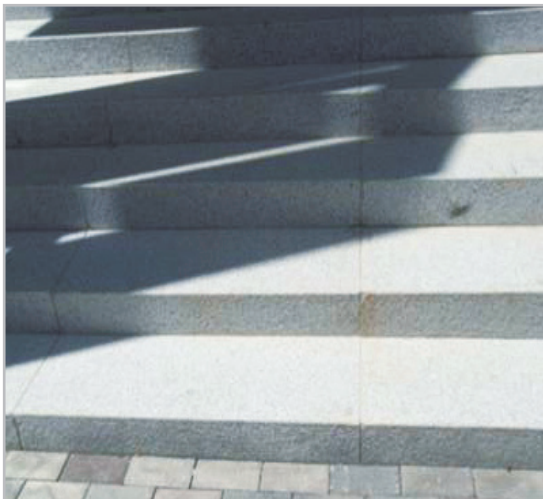
■ 주출입구 계단 통석 (50T) 시공으로 이삿짐 등으로 인한 하자 발생 방지
