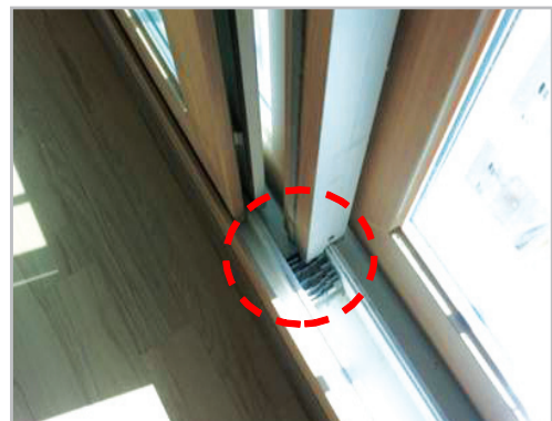
■ 기밀유지구(풍지판) 적정 위치 설치
