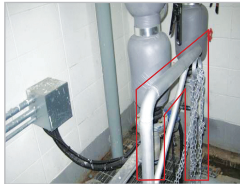
■ 인양용 가대 및 후크 고리 설치 (인양용 체인은 스테인레스 재질)
