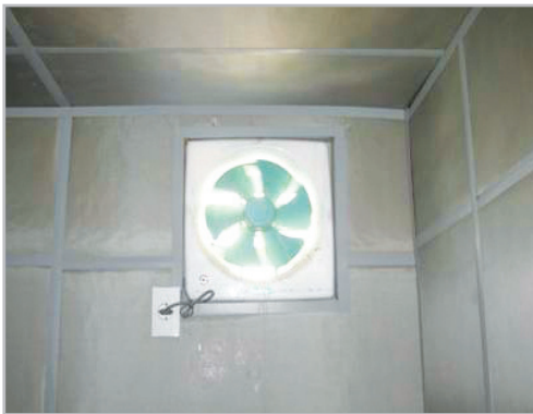
■ E/L기계실 강제환 온도 상승 자동 센서 미설치
