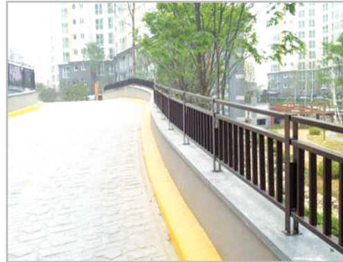
■ 보행로 안전 난간 설치
