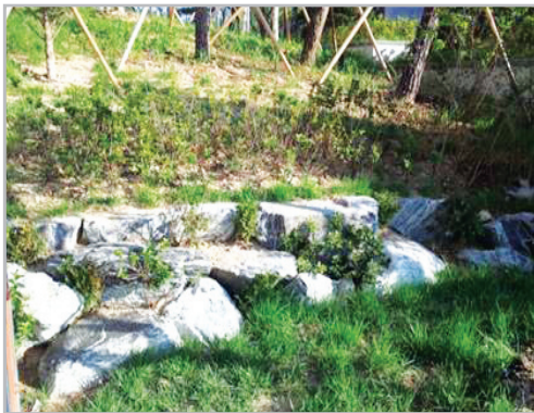
■ 옥외 특별고압인입관로 선로 위치 표기 미흡
