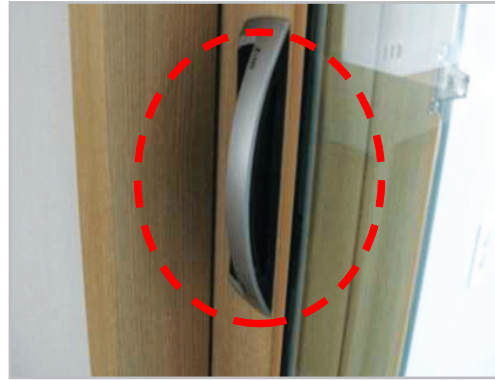
■ 발코니 분합문 손잡이 설치
