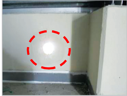
■ 옥상 경사지붕 내부 환기구 시공으로 결로 발생 차단
