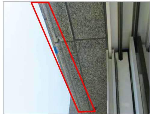
■ 저층세대(석재 특화 부위) 창호 외부 창대석 물끊기홈 시공
