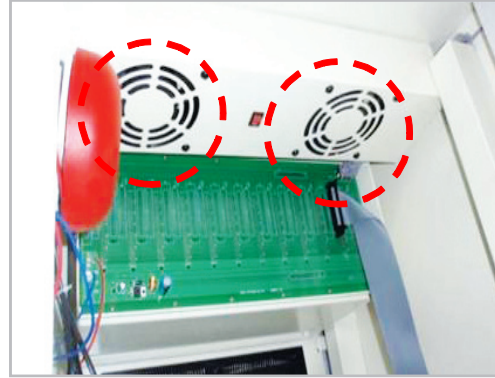
■ R형 수신반 환기팬 설치
