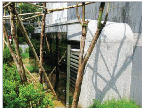
■ DA 배기구 보행자 동선 고려 유도 패널 설치
