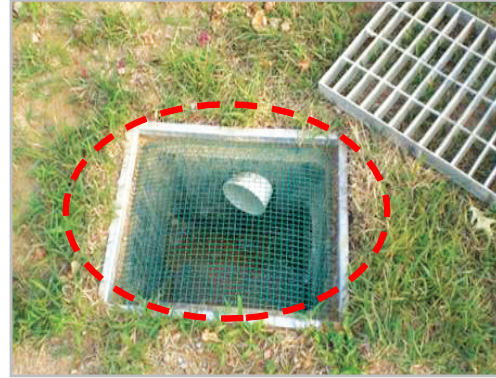
■ 집수정 내부 오물거름망 설치
