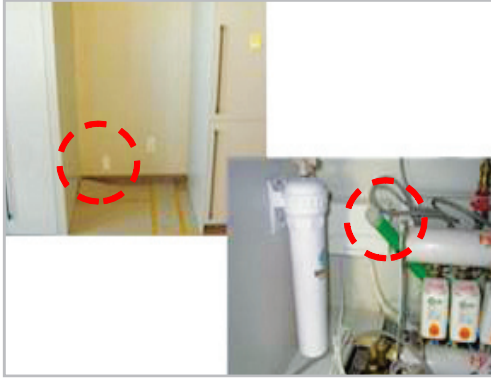
■ 주방 냉장고장 음용수용 배관 슬리브 설치(싱크대 하부 수전 공급)
