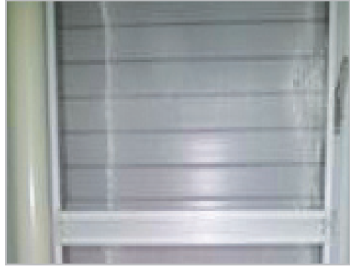
■ 갤러리 창호 방충망 설치
