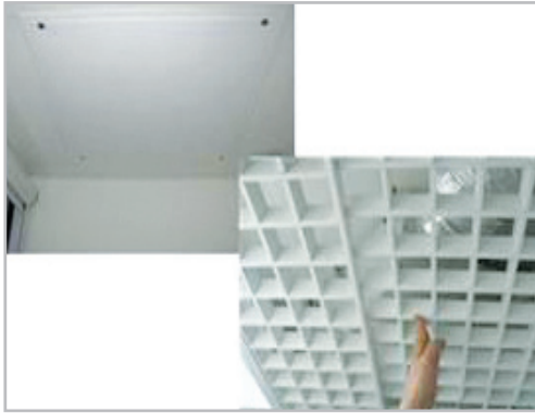
■ 발코니 상부 전열교환기 점검구 설치
