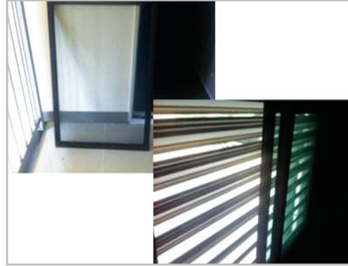
■ E/L기계실 창호 방충망 설치 - 외부 해충 침입 방지
