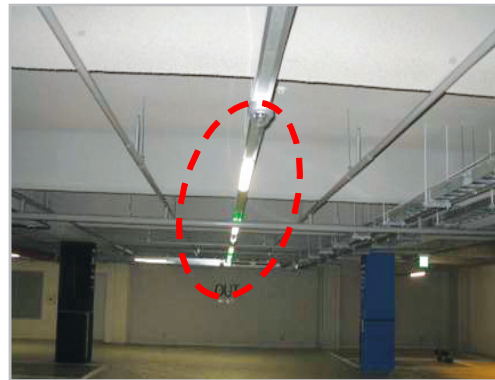
■ 지하주차장 동작감지형 LED조명 설치 및 360도 CCTV 카메라 설치
