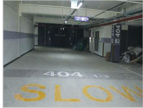
■ 지하주차장~동출입구 바닥 그래픽 도장
