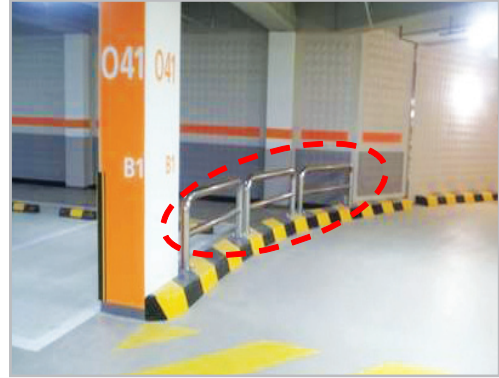
■ 상호 간섭 부위 안전시설(난간, 블라드 등) 설치
