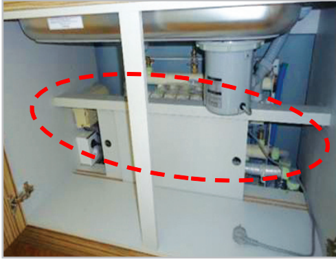
■ 주방 싱크장 온수분배기 주변 패널(문짝) 설치로 미관 개선
