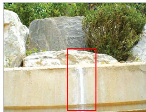
■ 옹벽 수직 균열 발생 부위 보완
