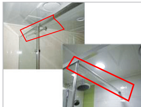
■ 욕실 샤워부스 흔들림 방지 브라켓 시공
