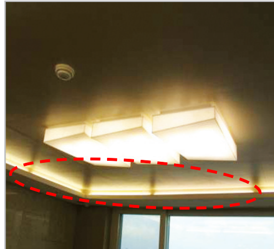
■ 거실 우물천장 내부 간접조명등 노출 여부 확인 (우물천장 몰딩 폭 확인)
