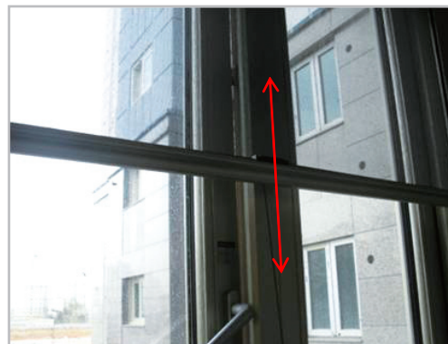
■ 대피공간 창호 블라인드형 방충망 설치
