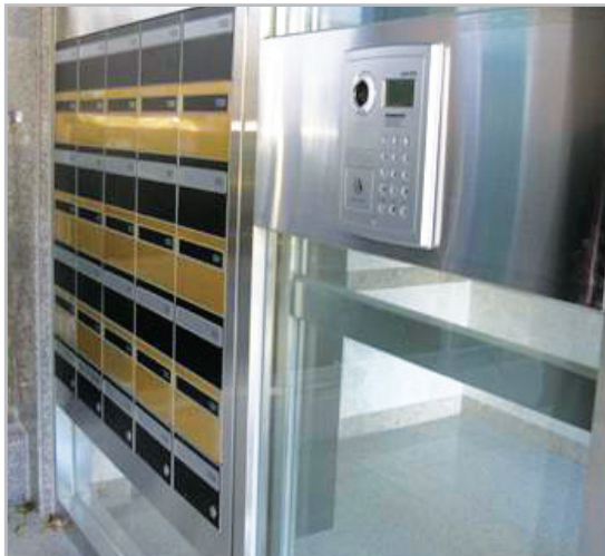
■ [외부] 양방향 우편물 수취함 매립 시공
