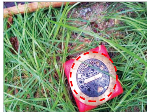
■ 옥외특별고압인입관로 선로 위치 표시기 설치
