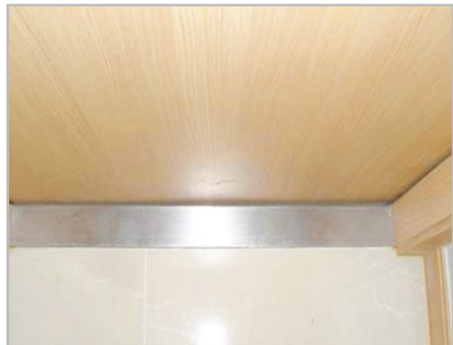
■ 대피공간 출입문 가스켓 잔손보기
