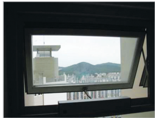
■ E/L홀 제연개폐창 설치로 환기 개선
