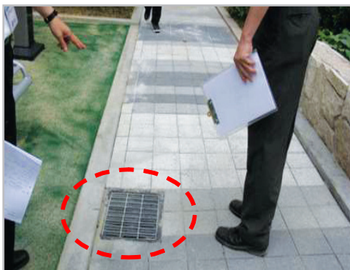
■ 보행자 동선 주위 오픈형 집수정 커버 설치
