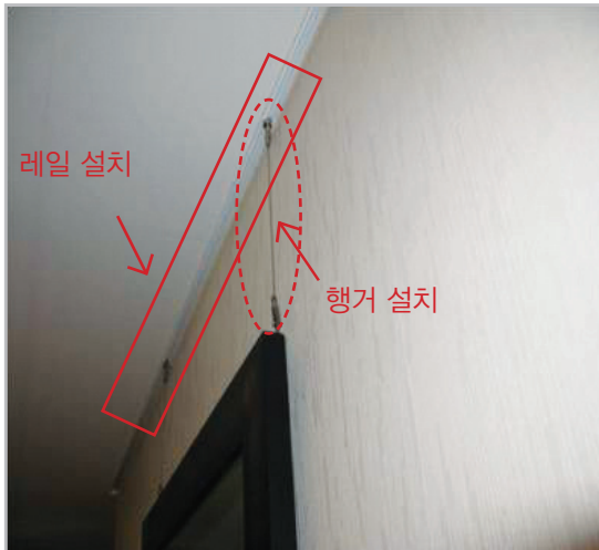
■ 거실 아트월 상부 그림걸이 레일 설치
