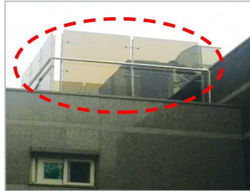
■ 실외기 미관 고려 차폐 패널 설치
