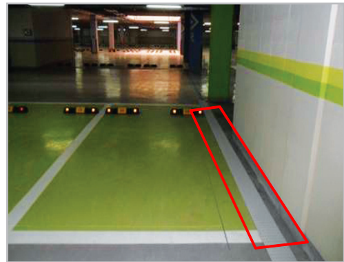
■ 주차구획 내부 폐쇄형 트렌치 커버 설치
