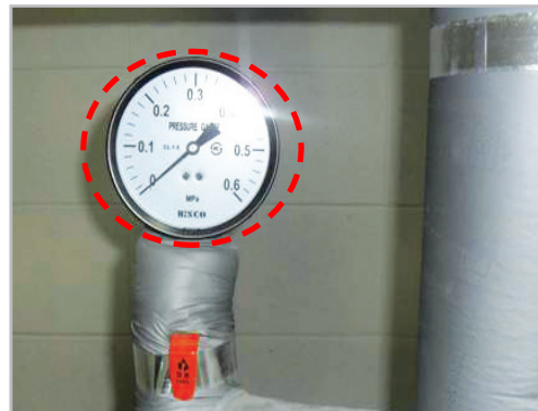
■ 배수펌프 압력계 교체 (실제 양정에 2~3배 고려)
