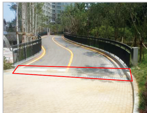
■ 도로 우수 처리 대책(트렌치 추가 설치)
