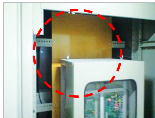
■ 배터리반~정류기반 사이 칸막이 시공
