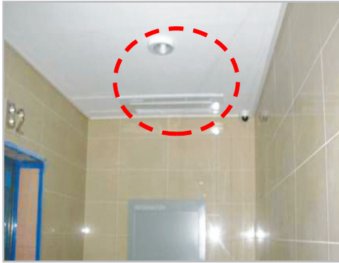
■ 지하E/L홀 결로 방지 시설 설치 (천장 매입 에어컨, 바닥 배수판 설치 등)
