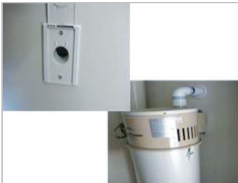
■ 세대 중앙집진식 진공 청소 시스템 설치
