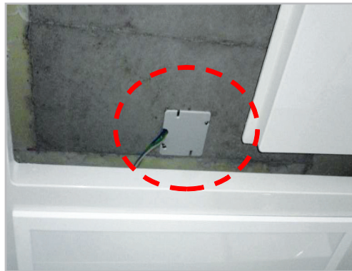
■ 천장 전기 박스 커버 설치
