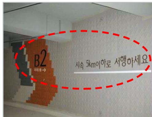
■ 지하주차장 벽면 그래픽 배수판 설치
