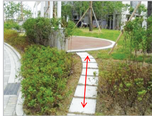
■ 임시동선 발생 부위 징검돌 설치
