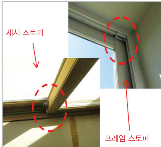
■ PL창호 충격완충구 설치 사례 (제품 사양서 확인)
