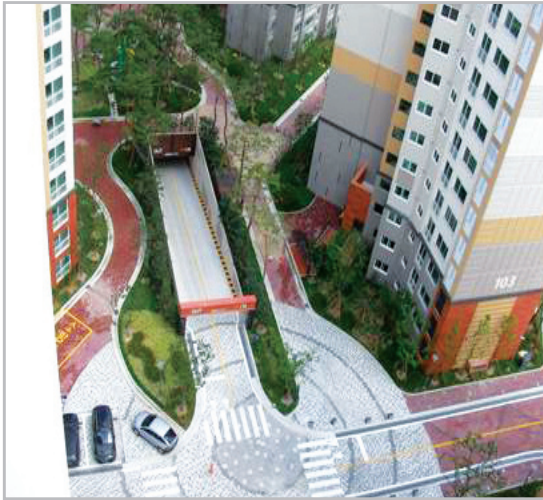
■ 지하주차장 출입구 램프 상부 지붕 미설치
