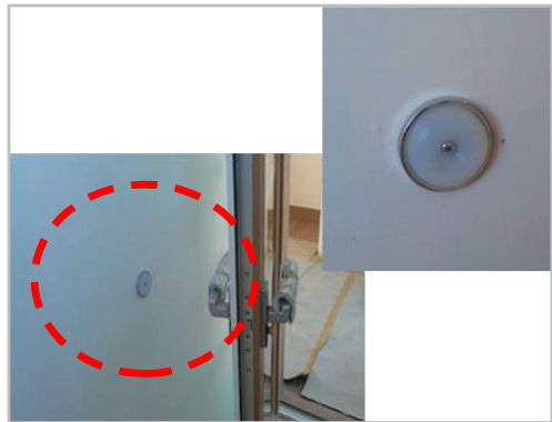
■ 출입문 충격완충구(칼블록형) 설치
