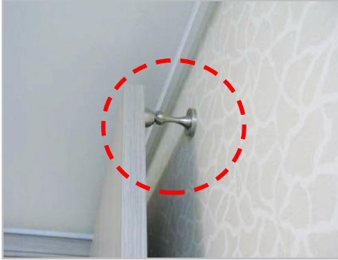
■ 침실 출입문 자석형 스토퍼 설치
