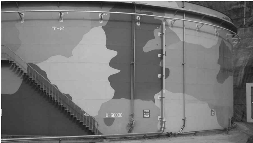
[그림 55] 물분부설비의 설치 예
