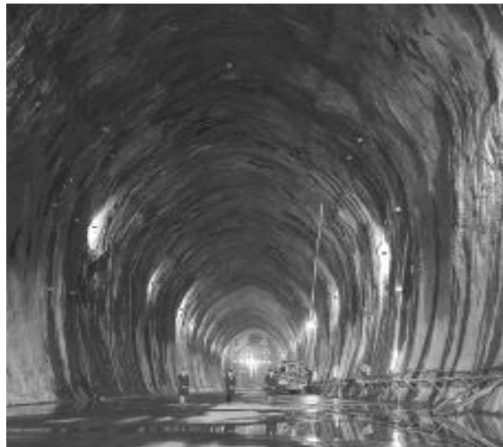
[그림 126] 암반탱크의 내부 구조
