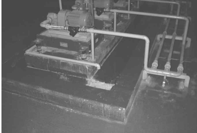
[그림 85] 불연재료로 된 턱을 설치한 예
