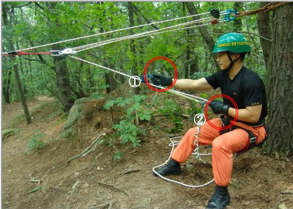
[그림 4-129] 로프당김 (등장기와 띠고리를 이용한 당김)
