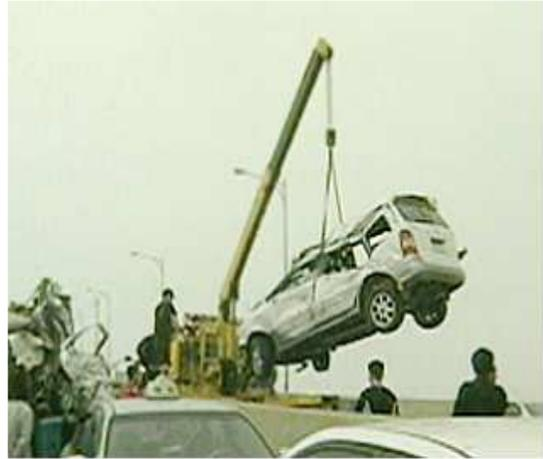
[그림 4-165] 크레인을 이용한 차량 인양
