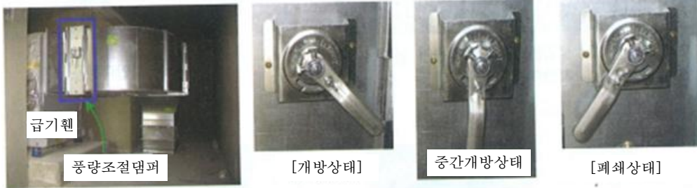
풍량조절댐퍼 설치외형 및 댐퍼조작 전·중·후 모습
