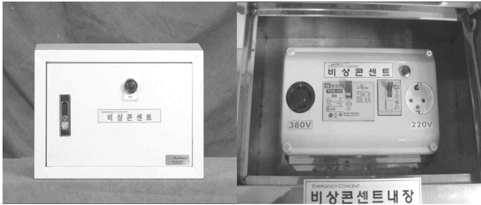
[그림 3-17] 비상콘센트설비함 및 소화전함 내장형
