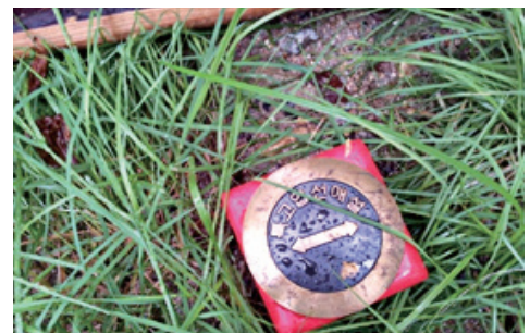
● 옥외 특별고압인입관로 선로 위치표시기 설치
