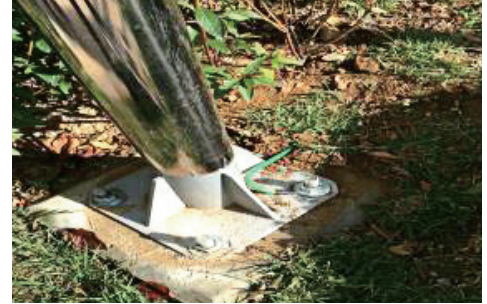
● 옥외 CCTV 카메라 접지 시공
