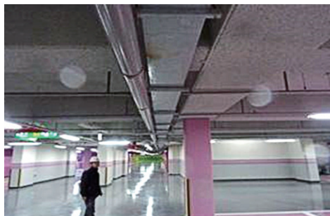
● 지하주차장 상부 특고압 인입덕트 위험 표지판 설치 필요
