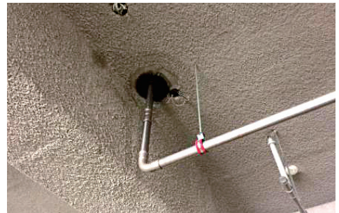
● 지하주차장 배관 주변 방수 및 보완시공
