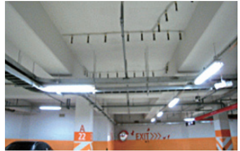
● 슬래브 균열부위 보수
