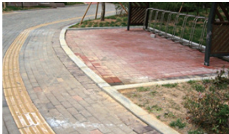
● 자전거 보관대 경계석 단차 발생으로 사용자 이용상 불편 우려
