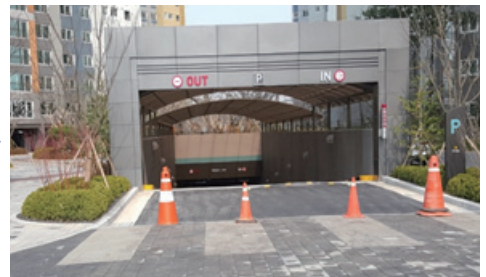
● 램프 진출 차량과 보행자 동선 간섭부위 안전 조치(화단 설치 등)
