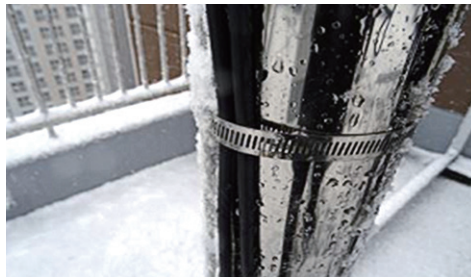
● 옥상 TV안테나 동축케이블 고정부위 케이블 보호조치 필요
