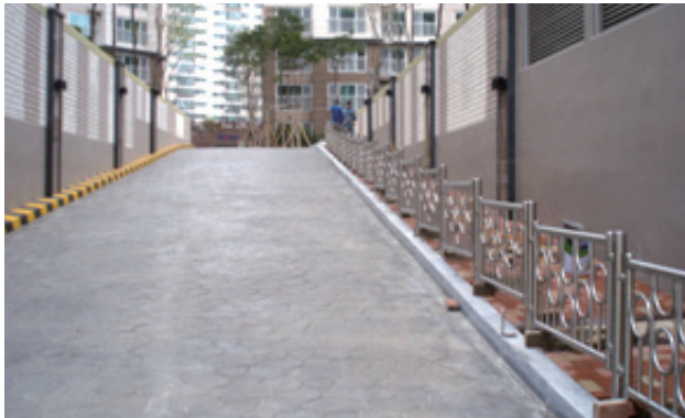
● 보행자-차량 동선 구분을 위한 안전난간 설치
