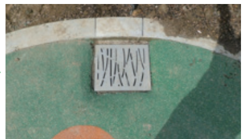
● 어린이놀이터 트렌치 폐쇄형(디자인 강판) 커버 설치
