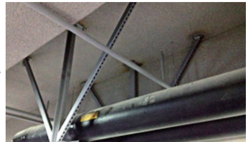
● 지하주차장 중온수인입관 앵커 고정 및 위험표지판 부착
