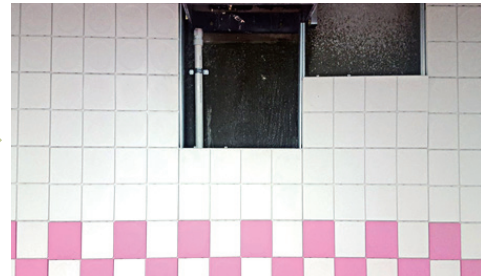
● 배수판 및 누수방지용 드레인 설치
