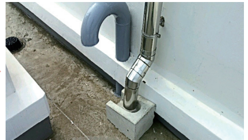
● 선흡통 하부 물받이돌 설치
