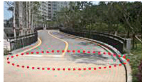
● 도로 우수처리를 위한 트렌치 시공
