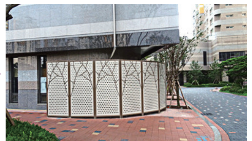
● 보행동선 구간에 설치된 에어컨실외기 외부 가림막 설치
