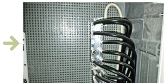
● TV분배기 종단기(Dummy) 설치
