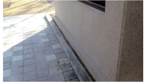
● 환기구 하부 이음부분 마감재 밀실 사춤
