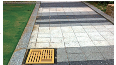
● 보행구간 집수정 커버는 폐쇄형(힐 끼임 방지)으로 설치
