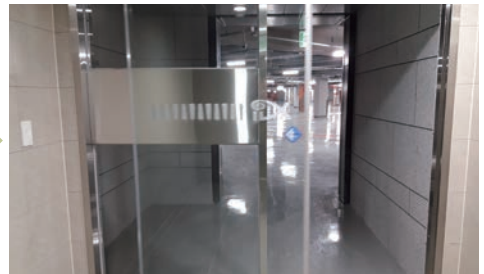
● 지하주차장, 공동현관 등 각종 유리문에 무릎과 가슴높이 안전 무늬띠 설치 또는 선팅지 부착
