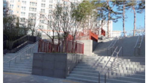
● 옥외 계단 중앙부에 난간 설치 및 플랜터에 난간대 추가 설치
