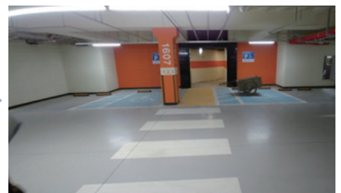
● 동 진출로 횡단보도 설치
