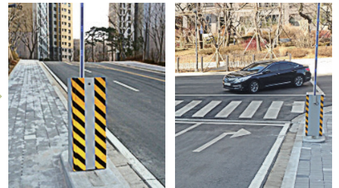
● 인도 및 차도 주차차단기 안전시설 (안전 울타리, SUS안전봉, 탄력봉) 설치
