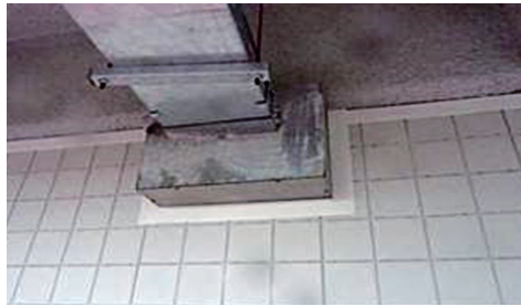
● 지하주차장 전력인입플박스 부분 배수판 설치 검토
