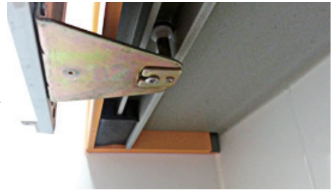
● 욕실 수납장 슬라이딩 도어 스톱퍼 설치
