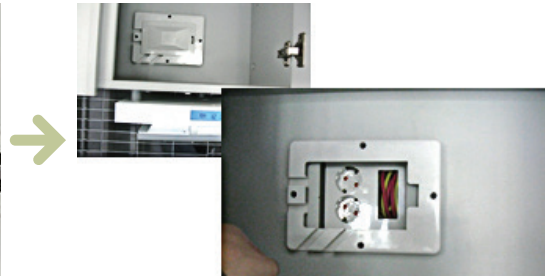
● 안전사고 예방을 위해 점검구 커버 시공
