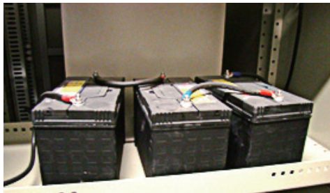
● 배터리반 배터리 고정 미흡
