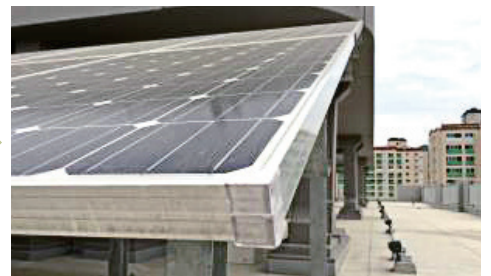
● 모서리 부분 보호덮개(완충재) 조치
