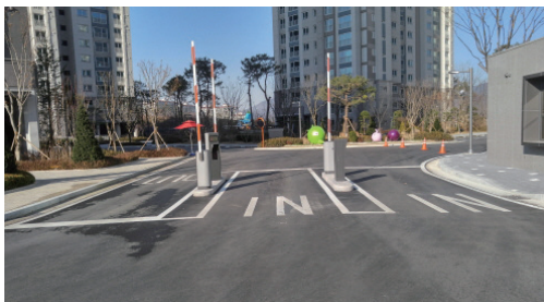
<잘못 설치된 예시>
