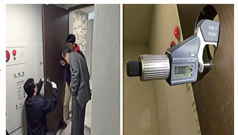
● 현장 시공상태 및 시험성적서 적정성 확인
