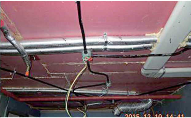
● 최상층 천장 전기 노출배관 시공 우수
