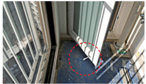
● 출입문 하부 충격완충장치 설치
