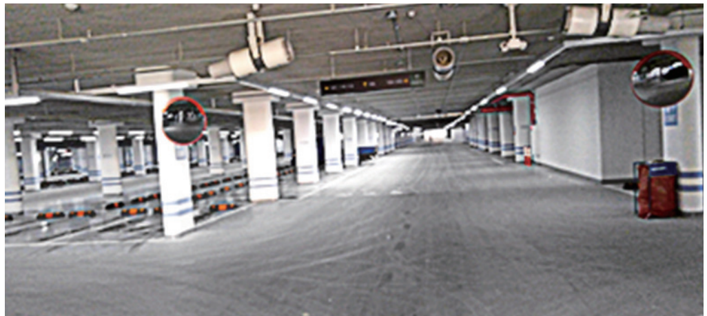
〈교차지점 도로반사경 설치 예시〉
