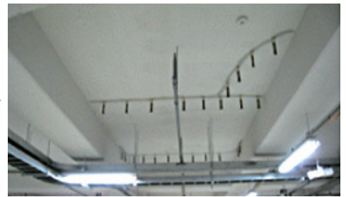
● 슬래브 균열부위 보수
