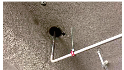
● 지하주차장 배관 주변 방수 및 보완시공
