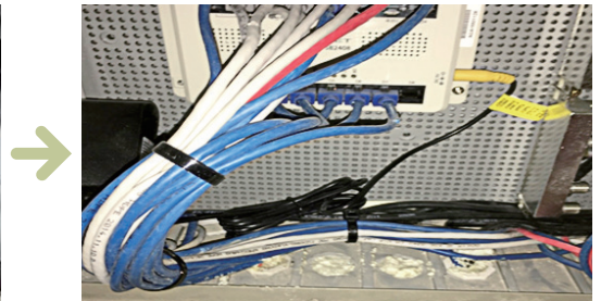
● 외부 인입 관로 결로방지용 코킹 시공
