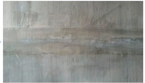
● 조인트 부분 방수시공 및 백화제거
