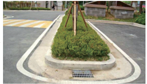
● 집수정 설치 및 구배 조정하여 배수 유도
