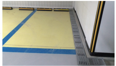
● 보행동선에 설치된 트렌치에 폐쇄형 커버 설치
