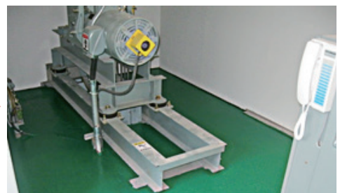
● 승강기 기계실 바닥 에폭시(우레탄) 도장 마감
