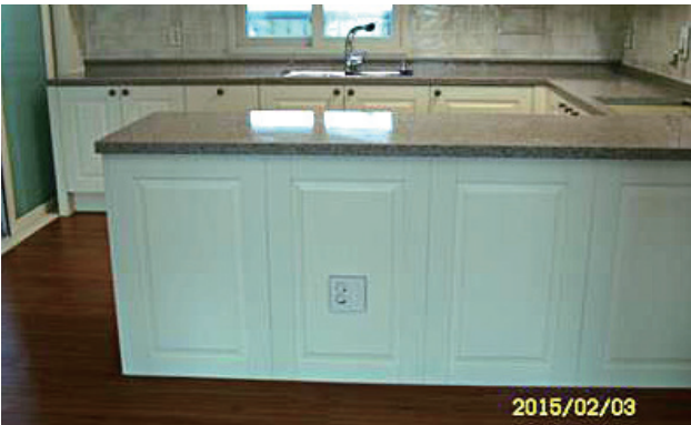
● 아일랜드 식탁 콘센트 설치로 입주자 편의 증진
