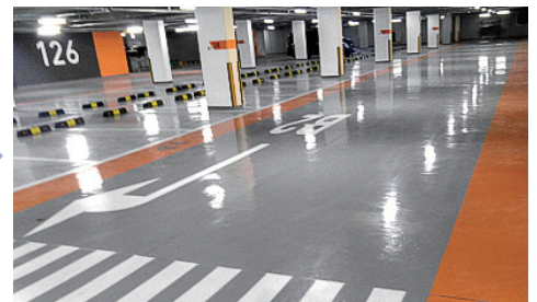
● 출구, 동, 지하 등 안내 노면표시 설치
