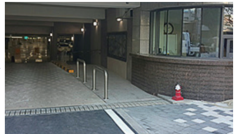
● 보행동선과 차량동선 사이 방호난간 설치
