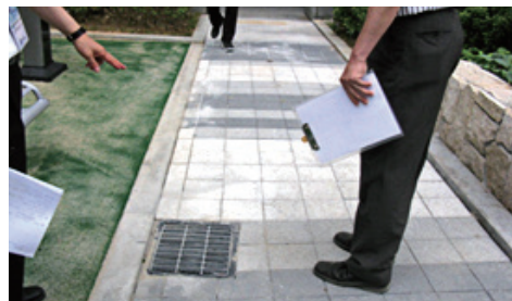
● 보행자 동선구간의 스틸그레이팅 집수정 덮개 설치
