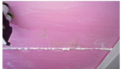
● 천장 단열재 결손부위 우레탄폼 충전
