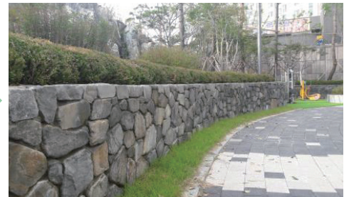
● 조경석 쌓기 마감(단차/수직, 수평)
