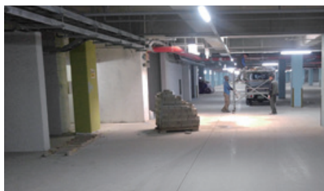
● 통행로에 동 진출입로가 직접 연결되어 시거제약에 의한 사고 위험
