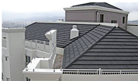
● 옥상 경사지붕 내부 점검구 및 점검용 전등 설치 필요
