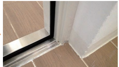
● 방화문 개스킷 밀실하게 고정 설치
