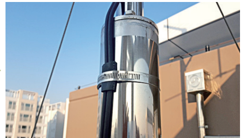
● 케이블보호용 고무보호대 설치
