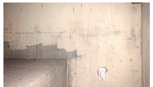
● 경사지붕 내부 전열콘센트 시공하여 휴대용 전등 사용 가능
