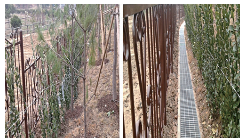
● U형측구 덮개 설치 완료
