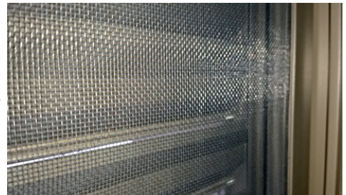
● 승강기 기계실 창문 방충망 설치
