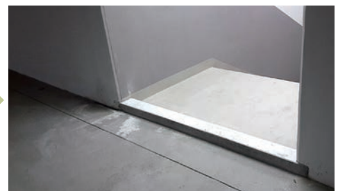
● 전기실 입구 물막이 턱 설치
