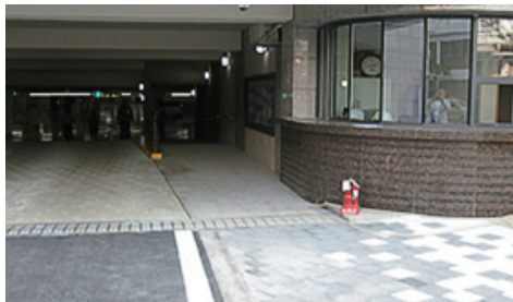
● 지하주차장 주출입구 보행자 동선과 차량동선 구분 필요
