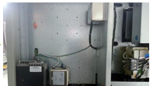
● 서지보호장치(SPD) 설치(제어반 뒷면)
