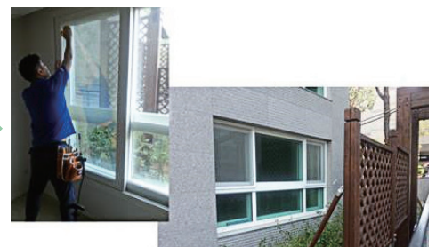
● 사생활 보호를 위한 목재 트렐리스 시공 및 생울타리 식재
