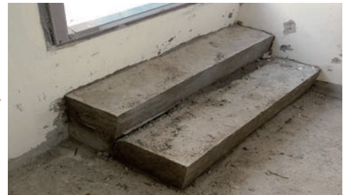
● 옥상출입문 계단 적정높이 확보를 위해 1단 추가 설치
