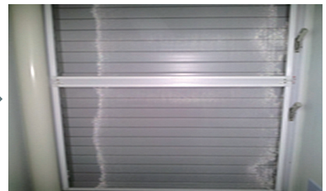
● 실외기실 갤러리 창호 방충망 설치
