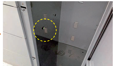
● 대형보관함에 비상탈출버튼 설치
