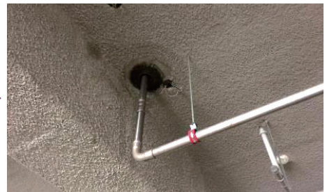
● 지하주차장 배관 주변 방수 및 보완시공
