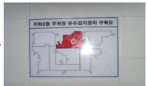
● 지하주차장 스프링클러 프리액션 밸브 방호 구역 표지 설치
