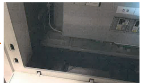
● 전기분전반과 통신단자함 사이에 격벽 설치
