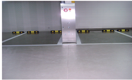
● 차량으로 인한 소화전 파손 방지대책 미흡
