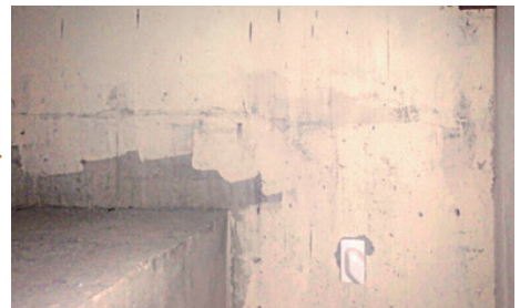
● 경사지붕 내부 전열콘센트 시공하여 휴대용 전등 사용 가능
