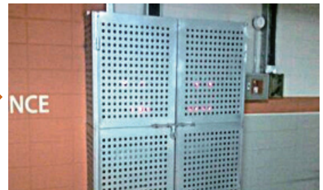
● 전기패널 안전 커버 시공
