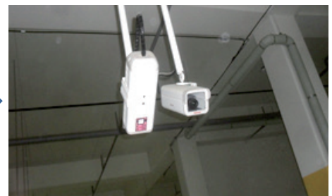
● 사각지대 CCTV 설치
