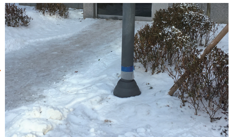
● 하부 안전커버 설치
