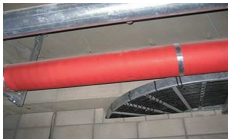
● 지하주차장 유수검지장치실 점검용 전등 필요
