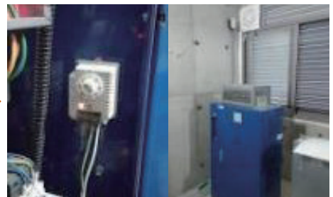
● 환기용 팬에 온도감지형 센서 설치로 일정 온도 상승시 자동작동(유지관리 용이)
