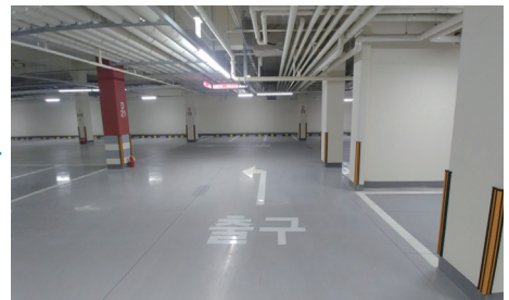
● 출구, 동, 지하 등 안내 노면표시 설치
