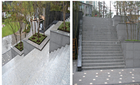
● 옥외 계단 난간 시공 및 플랜터에 대한 안전조치 필요
