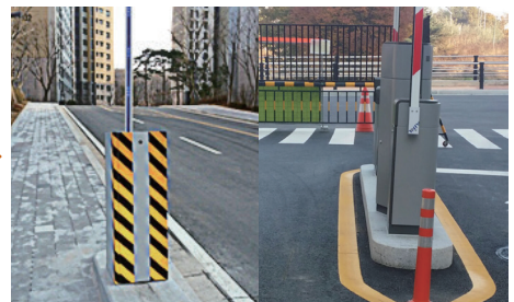
● 인도 및 차도 주차차단기 안전시설 (안전울타리, SUS안전봉, 탄력봉) 설치
