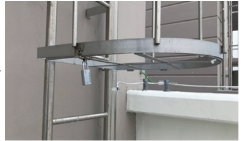
● 옥탑 점검사다리 시건장치 설치
