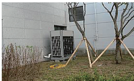
● 실외기 주변의 바닥 침하로 인해 실외기가 기울어지지 않도록 기초위에 견고히 설치 바람
