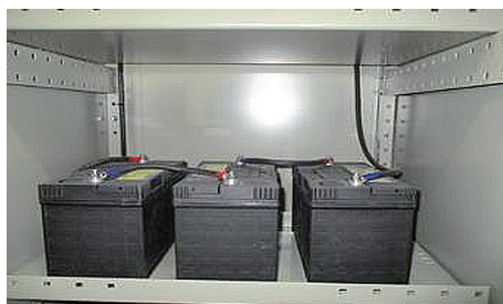
● 배터리반 배터리 고정 미흡
