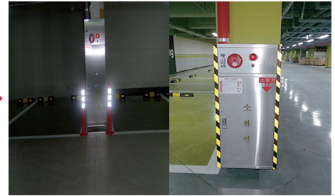
● 소화전 파손 방지를 위한 볼라드 및 반사 테이프 시공
