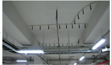
● 슬래브 균열부위 보수
