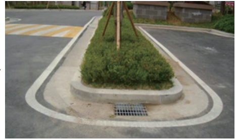
● 집수정 설치 및 구배 조정하여 배수 유도
