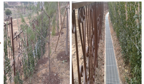
● U형측구 덮개 설치 완료
