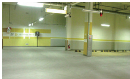
● 지하주차장 사각지대 발생
