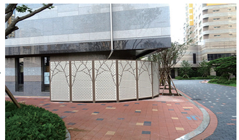
● 보행동선 구간에 설치된 에어컨실외기 외부 가림막 설치
