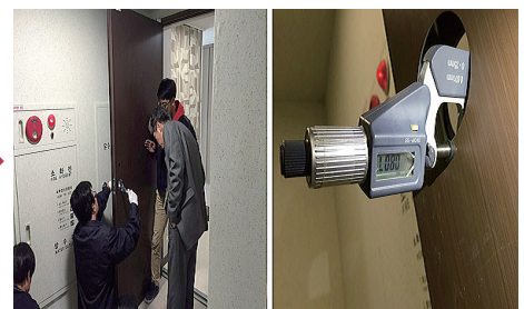
● 현장 시공상태 및 시험성적서 적정성 확인
