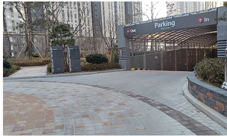
● 종단경사로 인한 지하주차장 중앙선 시거 제약
