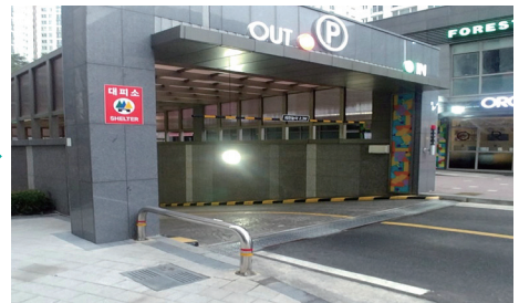
● 펜스 설치로 램프 인근 보행자 진입 예방
