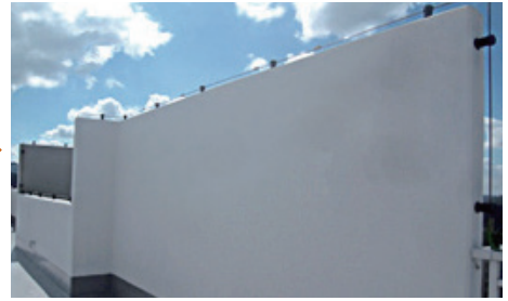
● 옥상 피뢰설비 접지 시공
