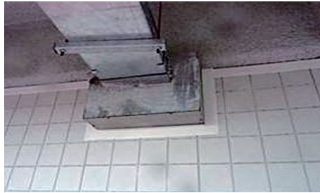
● 지하주차장 전력인입플박스 부분 배수판 설치 검토
