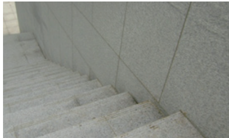
● 단지 내 중앙계단의 핸드레일 미설치
