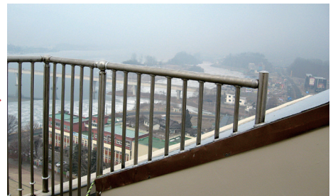
● 옥상 난간 연장 설치로 안전 확보
