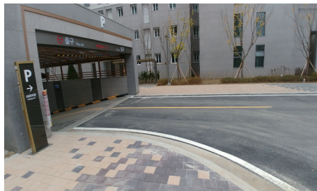
● 보도에서 램프구간으로 진입이 가능하여 오르막 차량과 시거제약에 의한 보행자 사고 우려
