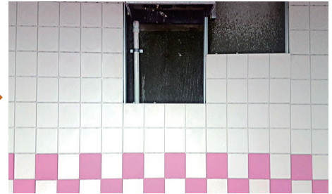
● 배수판 및 누수방지용 드레인 설치
