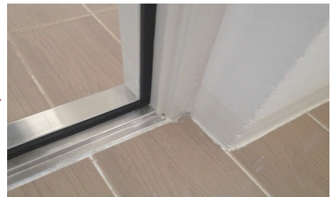
● 방화문 개스킷 밀실하게 고정 설치
