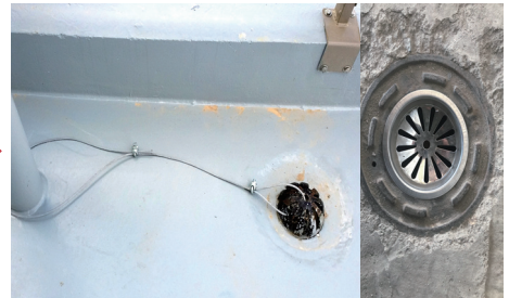
● 옥상 우수드레인 고정용 고리 설치 및 내부 거름망 설치, 방청도장
