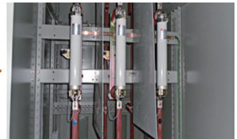
● 파워퓨즈 사이 격벽 설치
