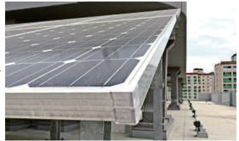
● 모서리 부분 보호덮개(완충재) 조치
