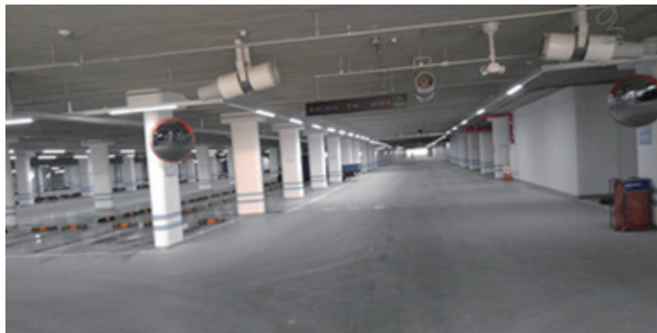
〈교차지점 도로반사경 설치 예시〉
