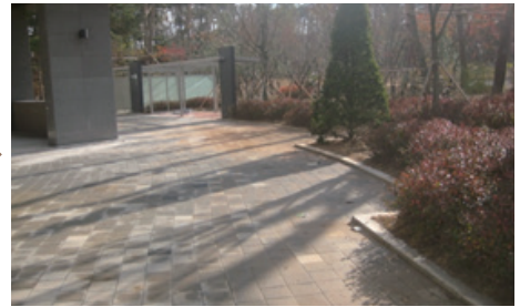
● 보도블록 구배조정 및 집수정 신설로 물고임 제거
