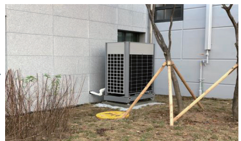
● 실외기 하부 기초 보강 완료
