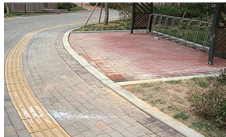
● 자전거 보관대 경계석 단차 발생으로 사용자 이용상 불편 우려
