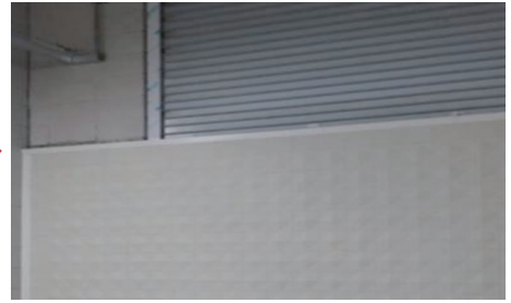
● 발전기실 장비반입구 배수판 시공
