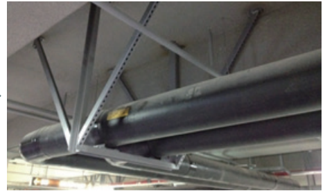
● 지하주차장 중온수인입관 앵커 고정 및 위험 표지판 부착
