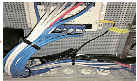
● 외부 인입 관료 결로방지용 코킹 시공
