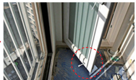
● 출입문 하부 도어스토퍼 설치
