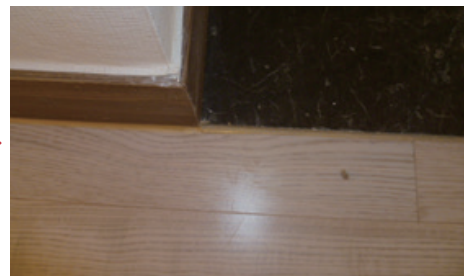
● 현관 디딤석과 바닥재 단차 최소화하여 시공 또는 재료분리대 시공
