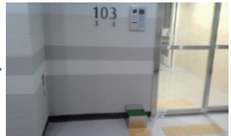
● 어린이용 발판 설치
