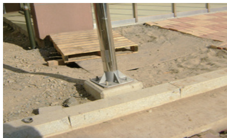
● 옥외보안등 볼트 체결부위 보호를 위한 하부 안전커버 미설치
