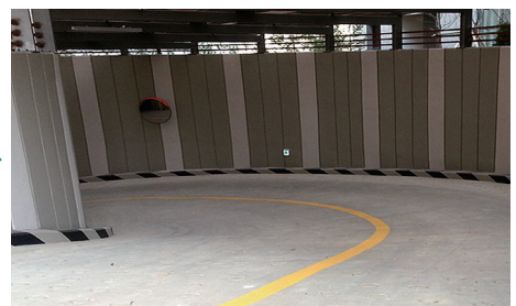
● 램프 곡선구간에 중앙선 및 반사경 설치
