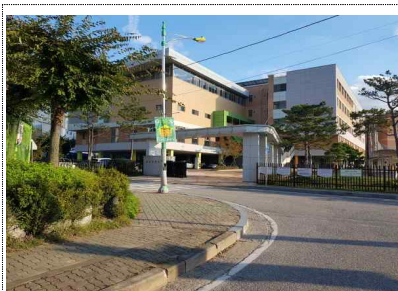
《통학로 CCTV 설치》
