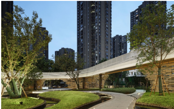
건축물 개발 컨셉을 고려한 진출입부 조명 연출 /Jiujiang 레지던시 단지 개발, 중국
