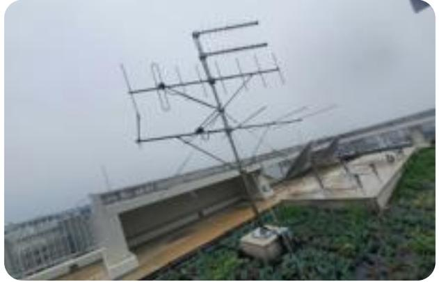
SMATV 안테나 설비 시공 상태 양호 및 유지관리 용이도록 피뢰 방지 개선에 수신점 설치
