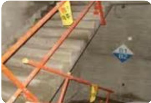
계단 타일 작업 시 난간대 간섭으로 인한 품질 저하 및 임의 해체로 추락위험
