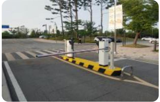
IoT 센서를 이용한 차량출입 통제장치 시공 시 바닥에 루프코일 없이 적용하여 유지 관리성 제고
