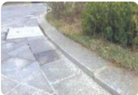
경계석 설치 불량으로 단차 발생
