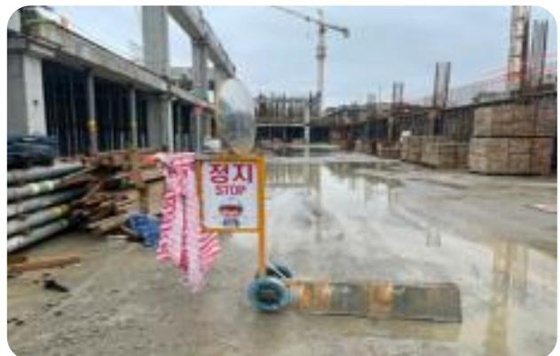
콘크리트 타설 시 레미콘 트럭 근로자 충돌 및 협착 방지를 위한 이동식 카스토퍼 및 반사경 설치
