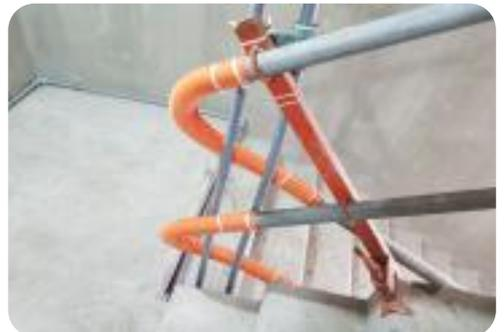
계단 단부 보호캡(PE 주름관 등 사용) 설치
