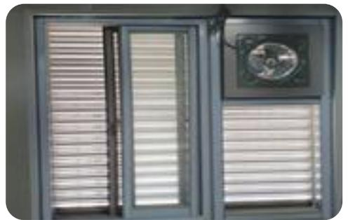
승강기 기계실에 환기창에 배기팬 설치 및 온도에 따른 On/Off 스위치 설치
