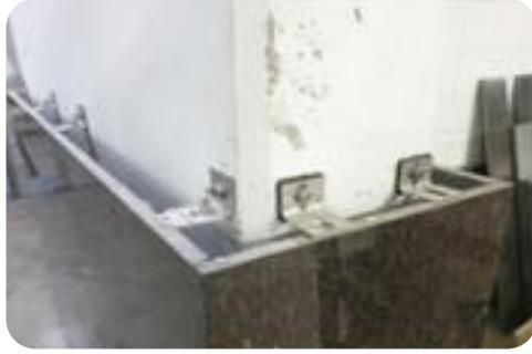
건식 석재 붙이기 파스너(Fastener)의 고정핀 미시공으로 수평응력 발생 시 석재 탈락 우려
