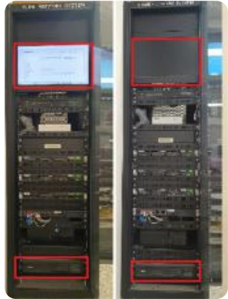
방재실에 설치된 홈네트워크 장비용 랙에 UPS 설치 확인 및 상전 차단시험 결과 UPS에 수용된 장비는 정상동작하고 있으나, 감시용 모니터는 상전에 수용되어 있어 OFF되었음
