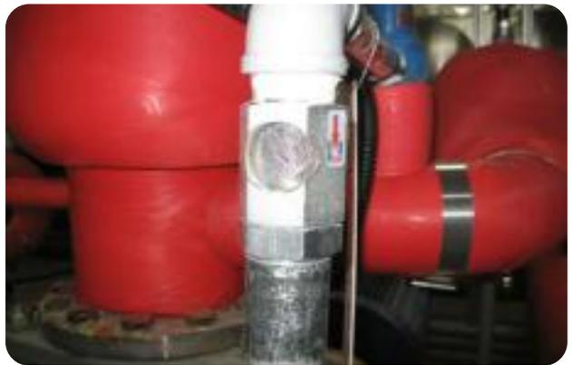
소화펌프 순환배관 테스트 시 물의 흐름을 육안으로 확인 가능한 배관 시공
