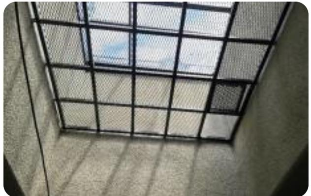
지하주차장 채광창 하부 추락방지 시설(메쉬형 그물망 등) 설치 및 유지관리를 점검구 설치
