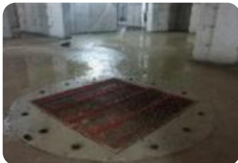
개구부 추락 방지를 위해 난간대 설치 및 주의 표식 부착 필요
