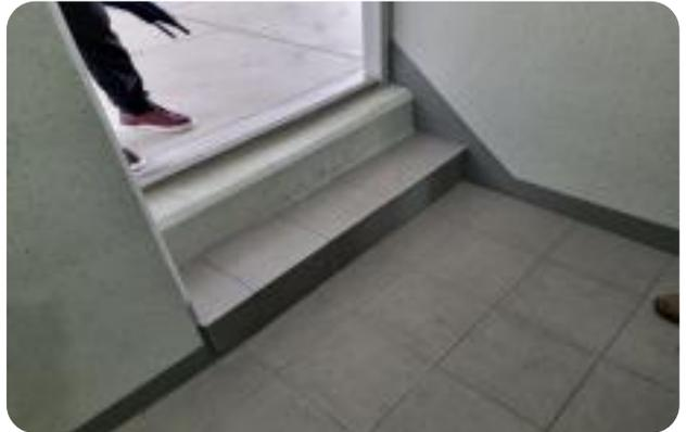
옥상 출입구 단차이로 인한 계단 설치 시 계단 폭을 골조 끝단과 일치시켜 미관 향상
