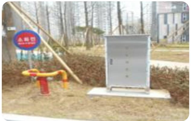
옥외 상수도 소화전 입형표지판 설치 및 외부 충격으로부터 소화전 보호를 위한 가대 설치
