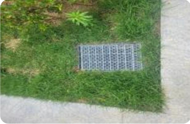
집수정 그레이팅 커버에 고정형 이중 거름망 설치
