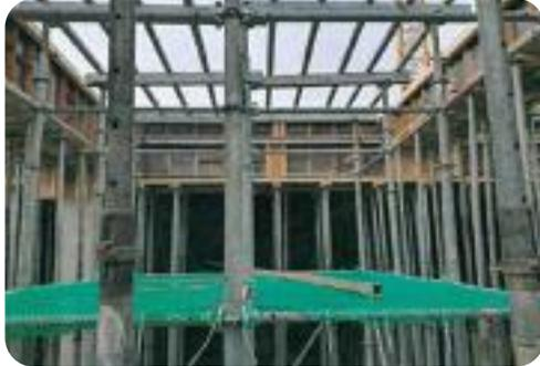
시스템 동바리 붕괴 방지를 위해 가새 및 수평 연결재 보완 설치 필요
