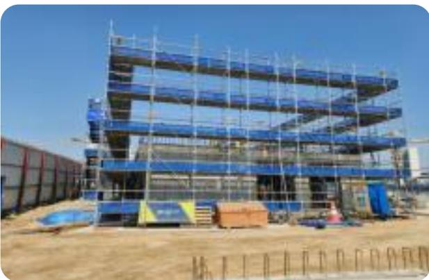
낙하물 및 추락사고 방지를 위해 시스템 비계에 전용 판넬 설치
