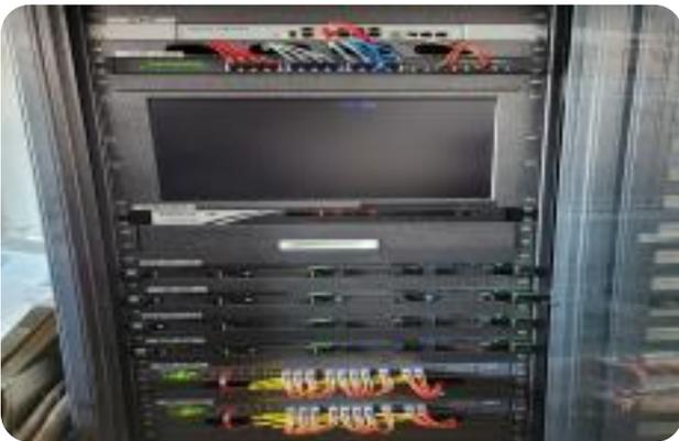
MDF실 내 홈네트워크용 서버랙의 설치 및 라벨링 상태 양호
