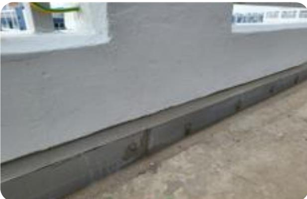
옥상 방수(파라펫 들어 시공, 방수 감아 올림 부위 커버 설치 및 고정, 코킹 처리 등) 우수
