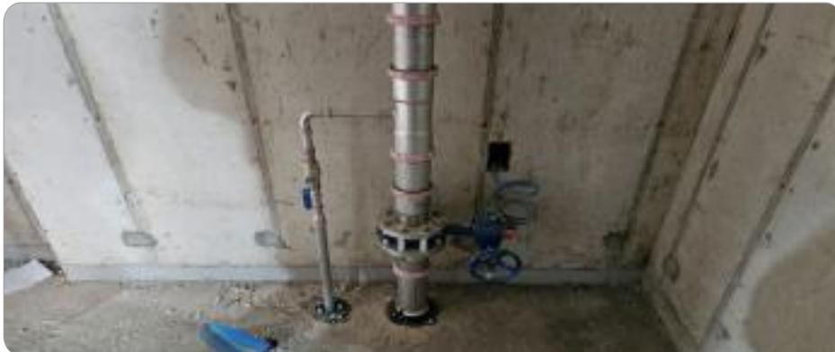
입상배관의 개폐밸브 및 드레인밸브를 피트층 상부보다는 PD내부(지하1층 또는 지상1층 등)에 설치(유지관리 원활 및 안전 고려)
