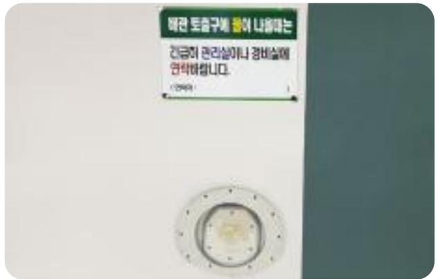
저수조 넘침관 지하주차장으로 유도 및 넘침관으로의 자동차 배기가스 유입방지용 역류방지장치 시공, 넘침 시 비상연락 안내 표지 설치
