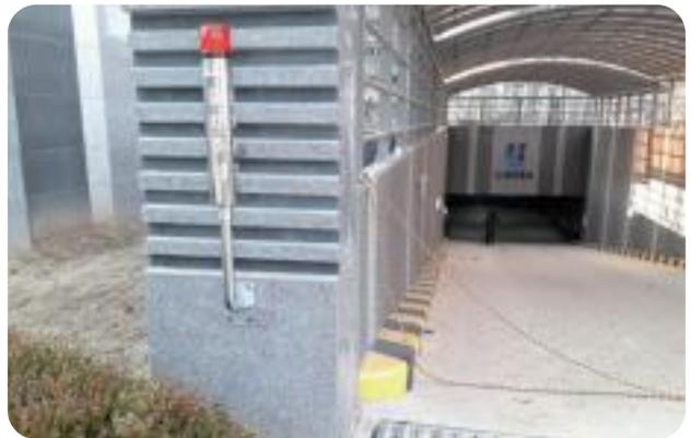
출차 주의 경광등으로 인한 야간 소음민원 대비 타이머 및 소음 조절장치 설치
