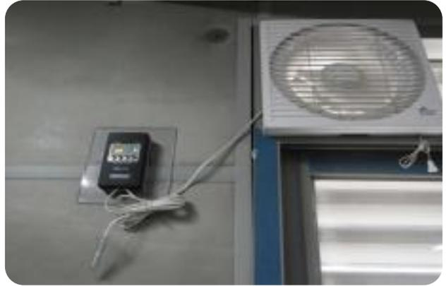
승강기 기계실 단열/흡음을 위한 마감 및 온도상승 자동 센서 부착 강제 배기팬 설치
