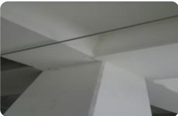
지하주차장 PC 기둥(COLUMN), PC 보(GIRDER, BEAM) 등이 만나는 부분 밀실 코킹 처리
