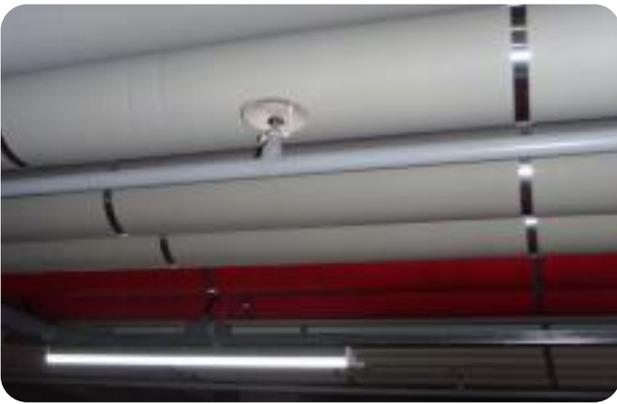
지하주차장 낮은 위치의 S/P 헤드에 차폐판 설치
