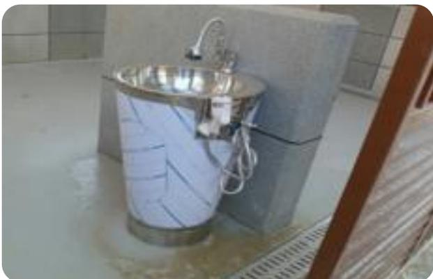
재활용 분리수거장 개수대(세수용 및 청소용) 설치 및 동파방지 열선 시공
