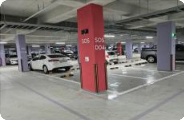
지하주차장 비상벨을 설치한 기둥 전체 적색 도장 및 4면 SOS 표기하여 시인성 확보
