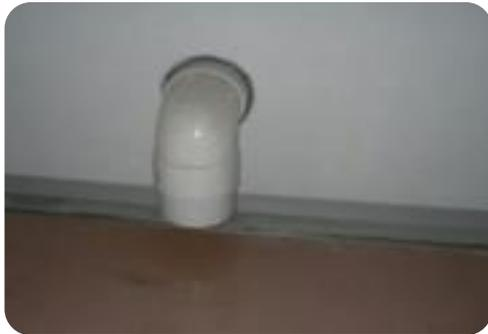
지하주차장으로 유도한 넘침관은 말단에 해충 침입 방지망 미설치 및 주차공간과 접한 오버플로우관의 경우, 배기가스 유입 방지 어려움
