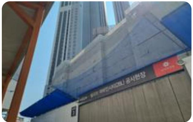
현장 외부 보행자 안전 확보를 위해 낙하물 방지망 및 안전통로 설치
