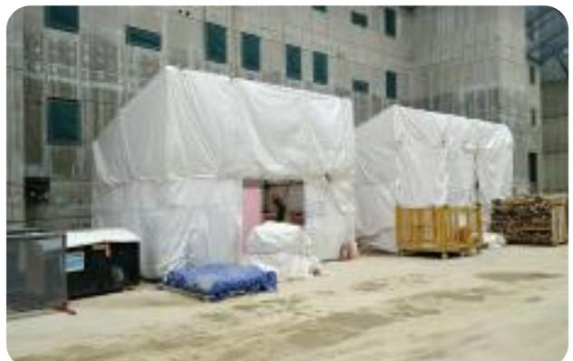
우수, 직사광선에 의한 급격한 열화와 성능 저하방지 및 용접불꽃 등 화재예방, 자기수축을 고려하여 단열재 전용 보관장소 설치
