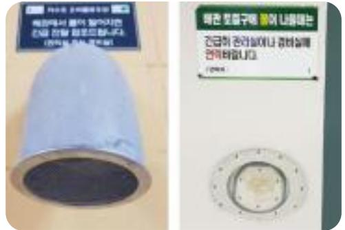
(좌)넘침관에 해충 침입방지망 설치 및 (우)주차공간과 접한 넘침관의 배기가스 유입 방지를 위한 역류방지 조치
