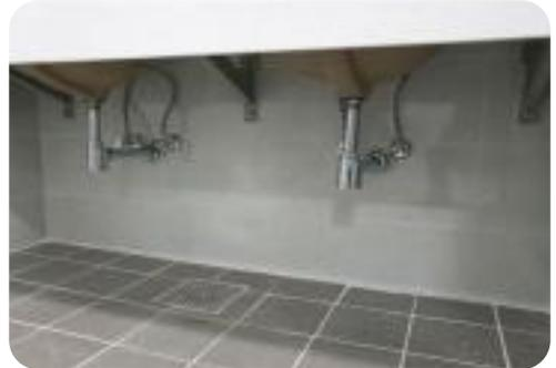
세면대 트랩을 CAP형 트랜치 설치, 벽체형으로 시공하여 누수방지 및 유지관리 용이
