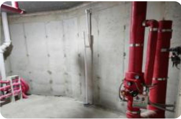
공용복도 P/D 알람밸브 설치공간이 충분히 확보되어 유지보수 및 조작 용이
