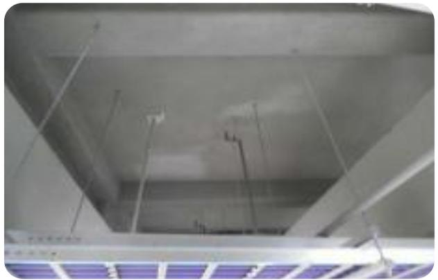
지하주차장 상부 길게 설치되는 S/P 헤드 배관 시공상태 우수(꺾어서 시공 후 변곡 부분에 가대 설치)
