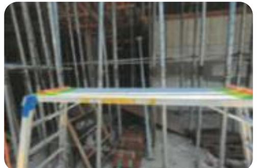
작업발판 단부 낙상 경보기 설치 및 벌어짐 방지 조치 완료
