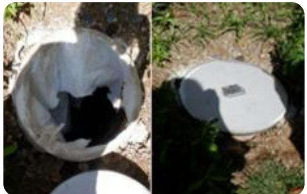
인공지반 배수 점검 맨홀 설치 및 녹 발생 방지를 고려한 스테인리스 커버 사용
