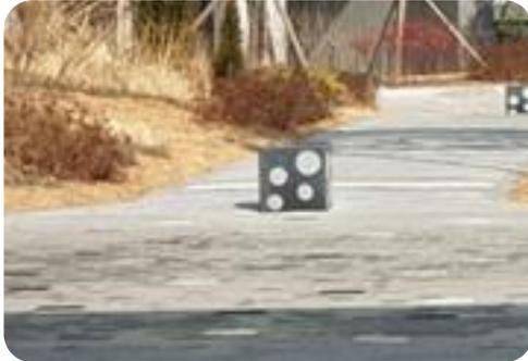
단지내 설치된 볼라드 높이가 낮아 보행자 및 시각장애인 넘어짐 사고 위험
