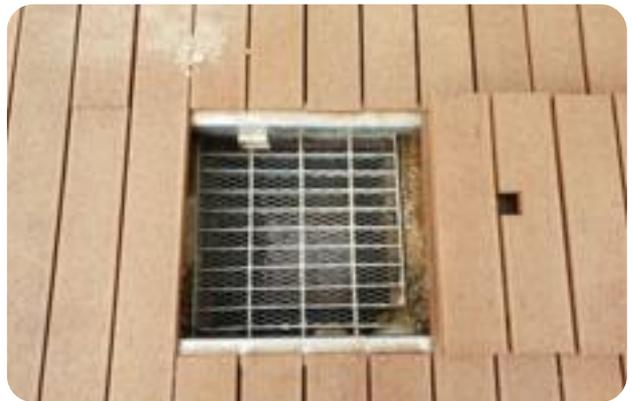
목재데크 하부 우수집수정 그레이팅 및 이중거름망 설치
