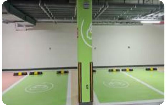
지하주차장 전기차 충전기 설치 위치 특화 도장으로 시인성 확보
