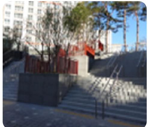
옥외 계단 중앙부에 난간 설치 및 플랜터에 난간대 추가 설치
