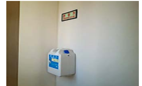
▲ 대피공간 완강기 고정식(이사 시 분실 대비)으로 설치
