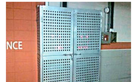
▲ 전기패널 안전 커버 시공
