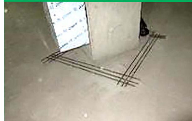
▲ 지하주차장 바닥 기둥 주위 균열방지용 철근 보강
