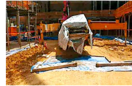
▲ 콘크리트 펌프카 전도방지를 위해 아웃트리거 확장 등을 고려하여 위치 선정
