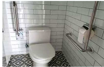
▲ 장애인용 손잡이 설치
