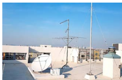
▲ 안테나용 피뢰설비 추가 설치하여 안전성 확보
