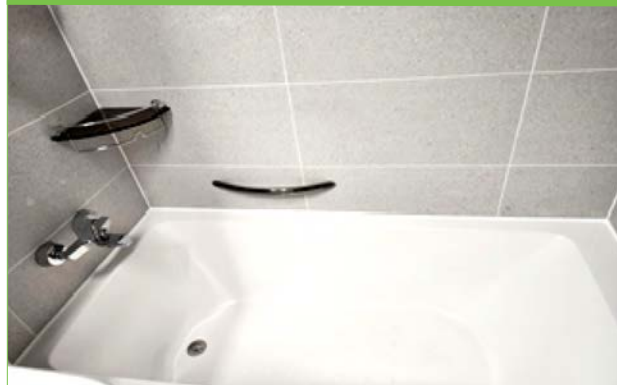
▲ 욕실 욕조 측면 손잡이 설치
