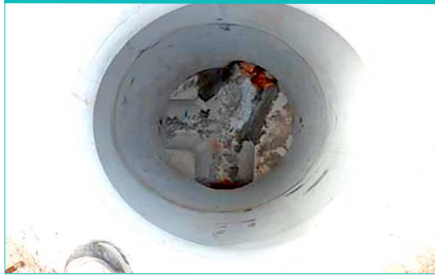
▲ 오수 맨홀 인버터 일체형(공장 제품) 사용
