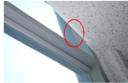
▲ 창틀 상부 코킹 누락부분 보완
