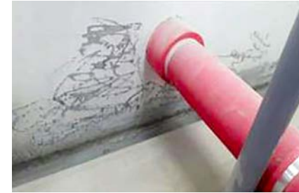
▲ 기계실 방화구획 배관관통부 내화채움(성능인정) 구조로 시공
