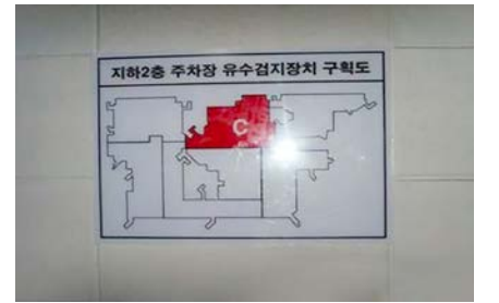
▲ 지하주차장 S/P 프리액션밸브 방호구역 표지 설치
