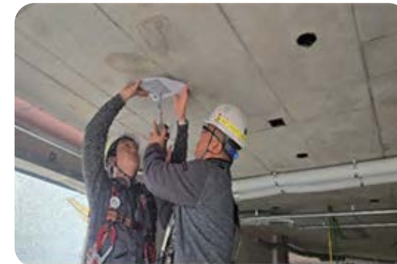
주요 구조부 콘크리트 반발경도 측정
