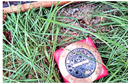
▲ 옥외 특별고압 인입관로 선로 위치 표시기 설치
