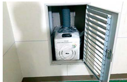
▲ 지하 승강기홀 제습기 설치
