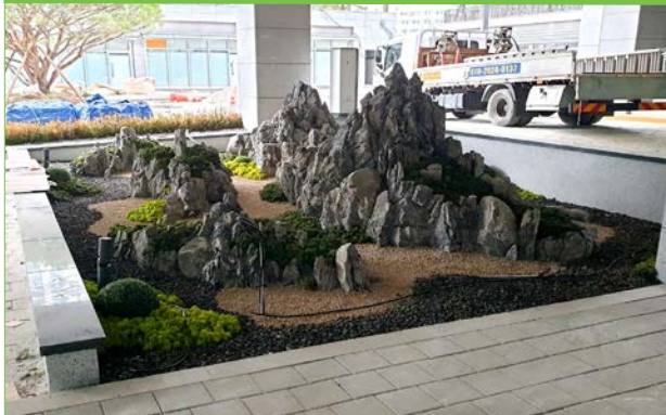
지하주차장 입구 장식물 설치
