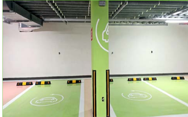
지하주차장 전기차 충전 기둥
