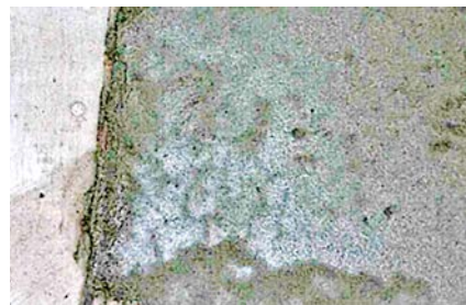
▲ 콘크리트 재료분리 발생 부위 모르타르로 보수
