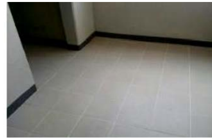
▲ 승강기홀 및 계단실 바닥 타일줄눈 처리 및 청소 실시
