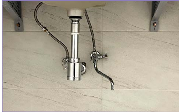
세면기 하부 서비스 수전 설치(주민공동시설)
