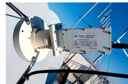
▲ 아시아셋 위성 LNB를 5G 신호 간섭제거용으로 교체하여 시공
