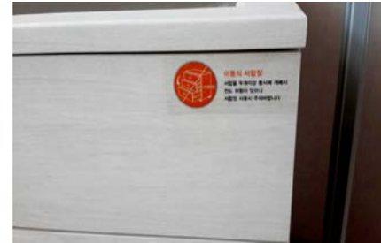
▲ 서랍장에 안내문 부착 및 입주자 안내 책자에 내용 삽입 (하부 전도방지 받침대 시공 권장)
