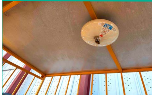
▲ 위험물저장소 내부에 확산 소화기 설치
