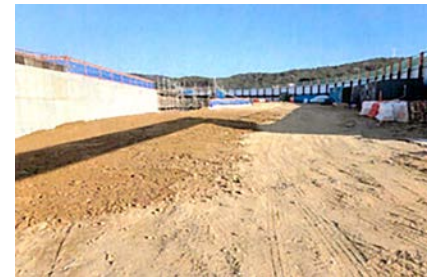
▲ 지반 취약부 치환 및 정리 작업
