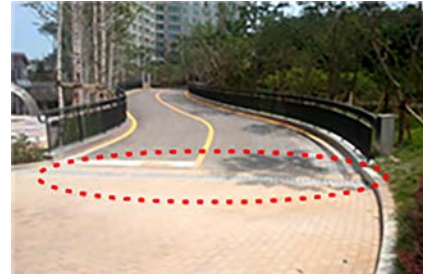
▲ 도로 우수 처리를 위한 트렌치 시공
