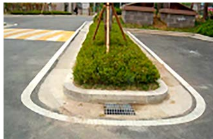
▲ 집수정 설치 및 구배 조정하여 배수 유도
