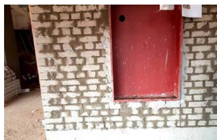
▲ 조적 벽체 내 배관 매입 부분 밀실 사춤
