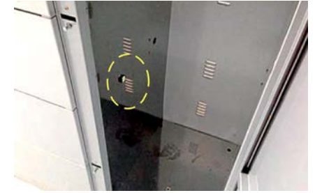
▲ 대형보관함에 비상탈출 버튼 설치
