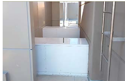
▲ 배기덕트 보호 커버 시공
