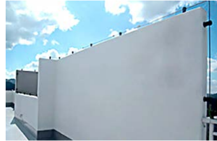
▲ 옥상 피뢰설비 접지 시공
