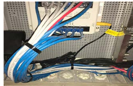
▲ 외부 인입 관로 결로방지용 코킹 시공
