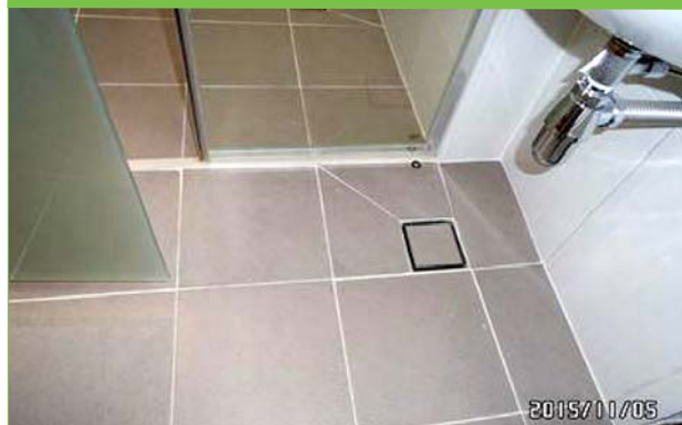
▲ 욕실 바닥 드레인(바닥마감과 조화) 시공
