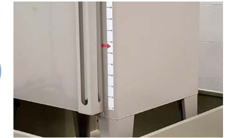
▲ 유류탱크와 방유턱을 철판 일체형으로 시공하여 마감 양호
