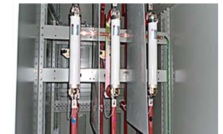
▲ 파워퓨즈 사이 격벽 설치
