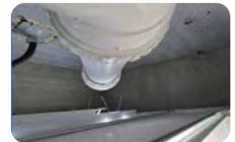
●사춤, 미장, 코킹 마감 양호
