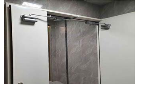
▲ 지하층 승강기홀·기계실·전기실 등에 도어클로저 및 순위조절기 설치
