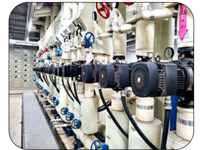
▲ 기계실 유지관리 공간 배치 (배관/덕트 및 장비간 유지관리 공간)
