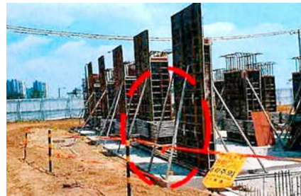
▲ 버팀대 설치 완료
