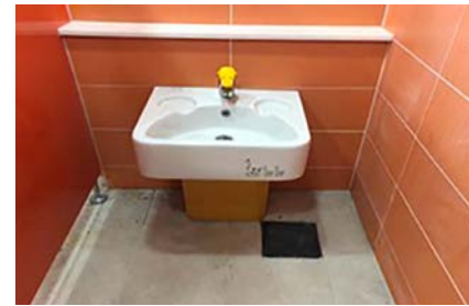
▲ 세면기 및 욕조 등의 수전을 화상방지용 온도조절 고정형으로 설치하여 안전성 향상
