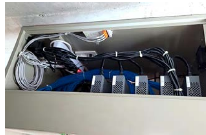
▲ TPS실 내 L2 스위치를 공간 확보하여 장비 운용성과 유지관리 용이하게 시공
