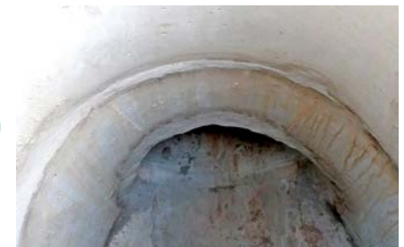
▲ 접속 관로 돌출부 제거 및 배관 주변 사춤 철거
