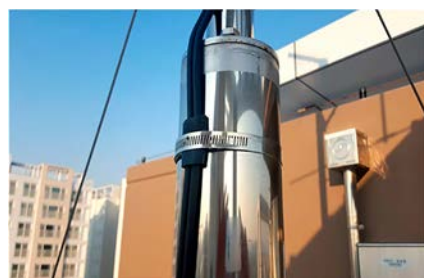
▲ 케이블보호용 고무보호대 설치
