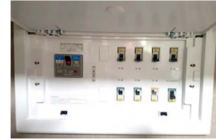
▲ 전기분전반 내부에 유지관리를 위한 스위치별 실명칭 및 회로도 또는 회로 설명서 미부착
