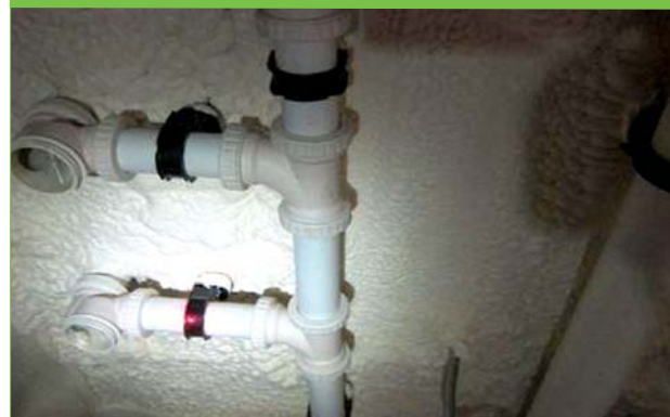
▲ 욕실 천장 단열재 뽐칠시공으로 층간소음, 누수 등 보완 시공
