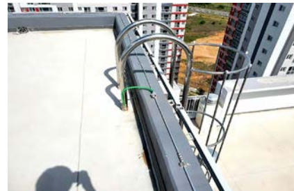
▲ 옥탑 점검용 사다리 피뢰도선 접지 완료
