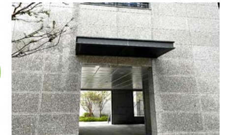
▲ 주 보행동선 필로티 상부에 캐노피 설치
