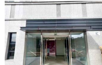
▲ 부대복리시설 출입구 상부 캐노피 설치
