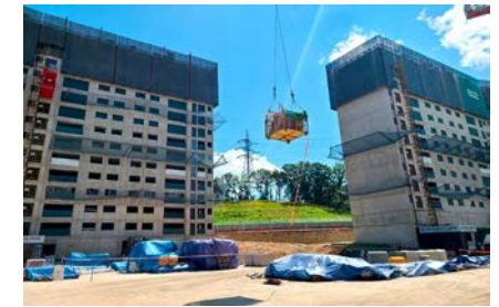
▲ 인양함 양중 시 유도로프 체결 사용
