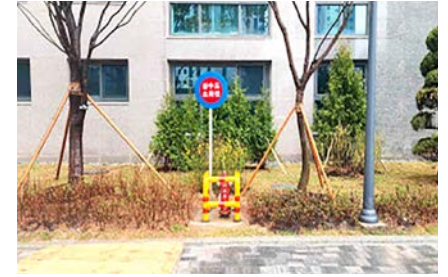
▲ 안전 보호대 및 소화용수 표지 설치
