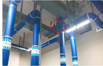
▲ 수격방지기 교체 등 유지관리를 위한 차단밸브 설치
