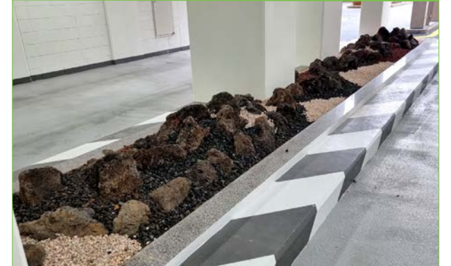
지하주차장 연석 장식물 설치
