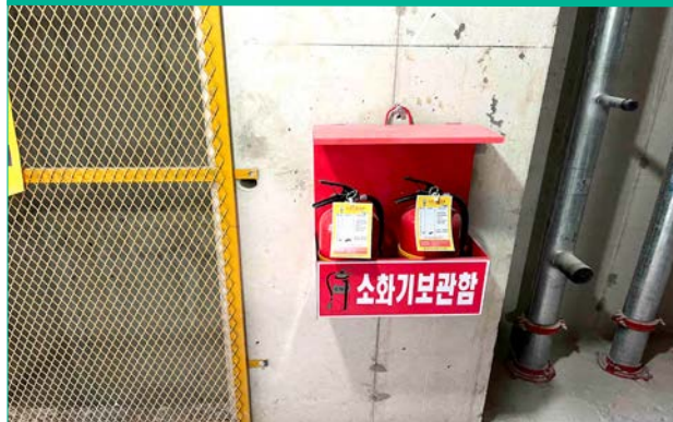
▲ 소화기 보관함 벽부 설치
