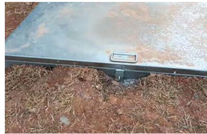
▲ 녹지대 수직 우수드레인 및 각종 점검구 잠금(시건) 장치 설치
