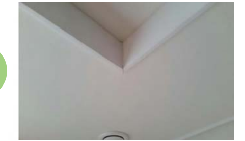
▲ 우물천장 연귀부분 조인트 마감·보완 시공
