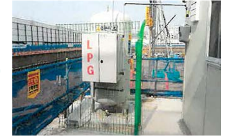
▲ LPG 저장소 주변 펜스 설치
