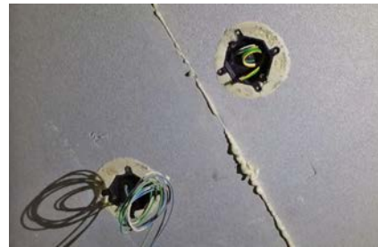
▲ 단열재 결손부위 및 이음매 우레탄폼 밀실 충전
