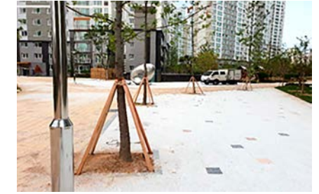
▲ 보도 가로수 보호용 삼각 지주대는 통행에 방해되지 않도록 지주를 뿌리분 보호를 내에 매입 설치
