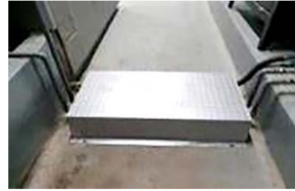
▲ 발전기실 급유배관 보호 발판 설치
