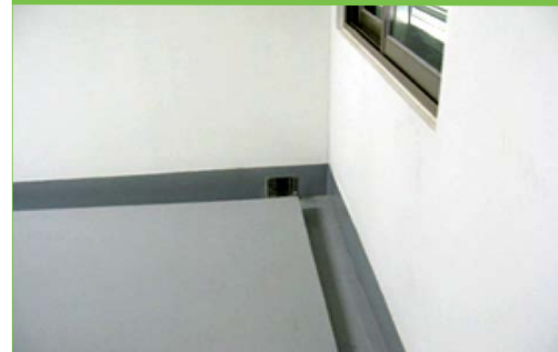
승강기 기계실 바닥
