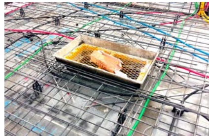
▲ 사인장 균열 방지를 위해 자재인양구 보강근 설치
