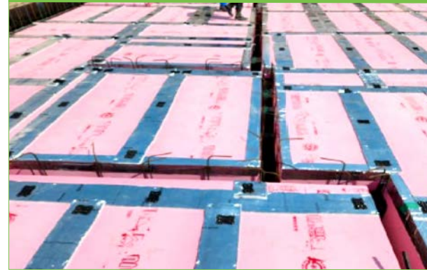
▲ 옥상 바닥 시공 시 슬래브 단열재 조인트 열반사 테이프 부착하여 결로 예방
