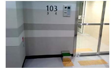
▲ 지하 로비폰에 어린이용 발판 추가 설치
