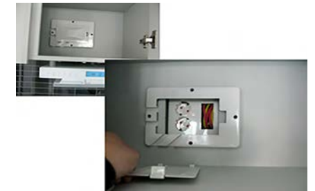
▲ 안전사고 예방을 위해 점검구 커버 시공
