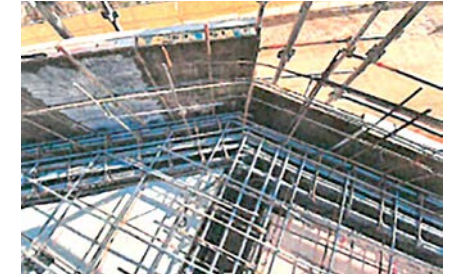
▲ 두 보의 상부 철근을 이음 철근으로 시공
