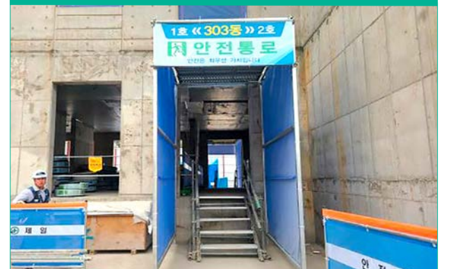
▲ 각 동 출입구 안전 통로 설치
