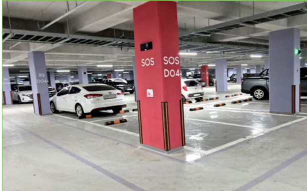
지하주차장 비상벨 기둥
