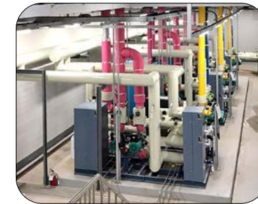
▲ 기계실 유지관리 공간 배치 (배관/덕트 및 장비간 유지관리 공간)
