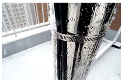
▲ 옥상 TV안테나 동축케이블 고정부위 케이블 보호조치 필요
