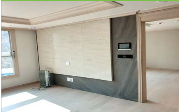
거실 아트월 요철 시공
