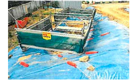
▲ 침사지 및 주변 안전난간대 설치 완료
