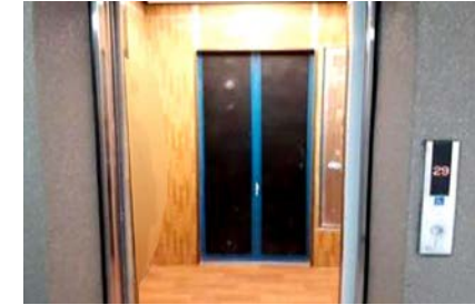
▲ 양방향 출입구조 승강기의 경우, 승강기문 전후면에 주의 표지판 부착 및 안내방송 등으로 출입 방향 고지 필요
