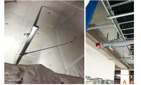
▲ 배관 말단부에 버팀대 설치
