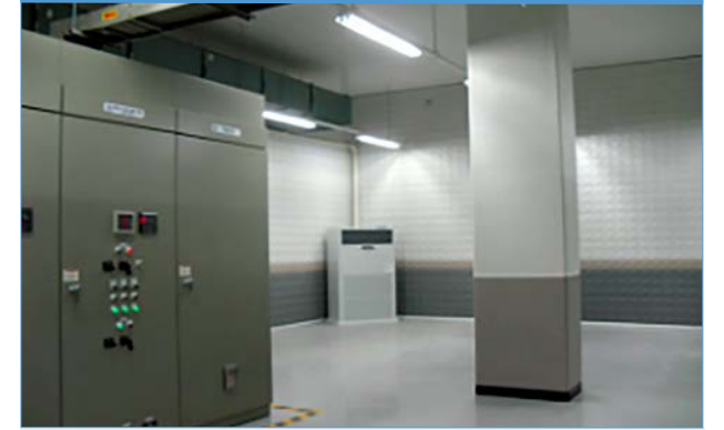
전기실 내 에어컨 설치
