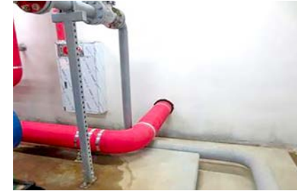
▲ 기계실 배관관통 부위내화채움(성능인정) 구조에 적합하게 설치 필요
