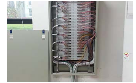
▲ 랙 부위 접지 및 케이블 정리
