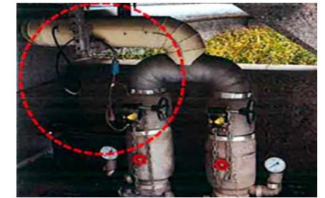
▲ 선큰 등 옥외에 설치된 집수정 배관 동파방지 열선 시공
