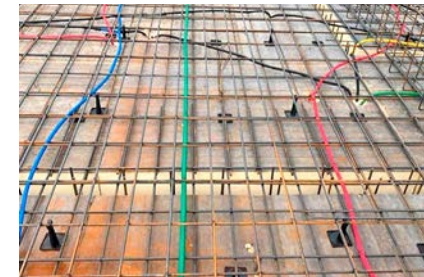
▲ 최상층 벽체 수직철근 정착길이 미확보 (90° 갈고리 시공 필요)
