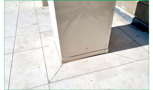
▲ 옥상 구조물 기둥 모서리 등에 신축 줄눈 시공하여 균열 방지
