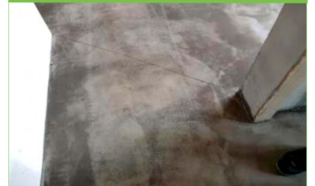
▲ 세대 거실 방바닥 미장의 사인장 균열 방지를 위한 유도줄눈 시공 적용
