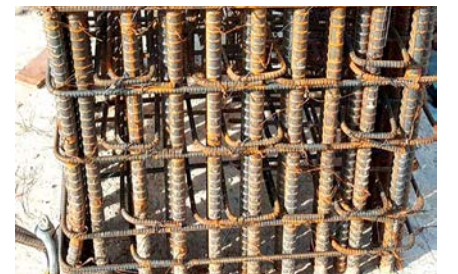
▲ 주철근 이음을 앞뒤로 배치하여 시공
