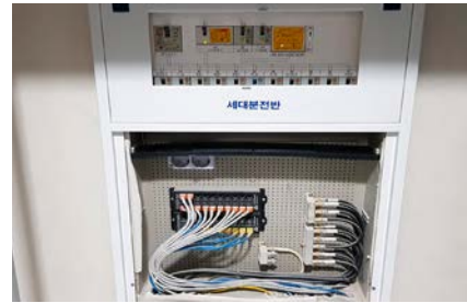
▲ 각 배선과 맞도록 세대배치도 비치 및 각 케이블 여장정리 완료
