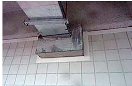
▲ 지하주차장 전력인입폴박스 부분 배수판 설치 검토
