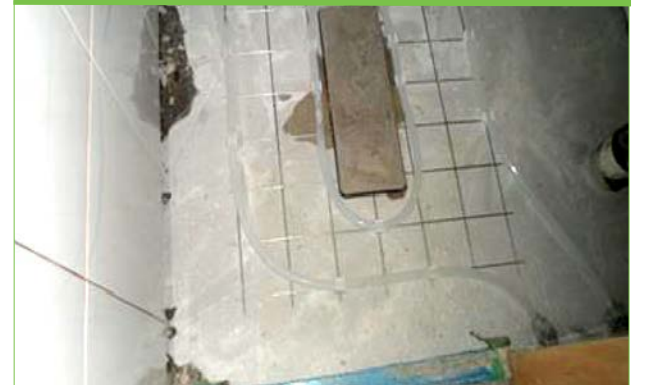
▲ 욕실 바닥난방 시공
