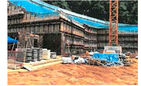
▲ 배수로 정비 및 자재 정리 완료
