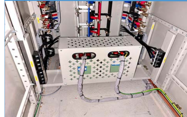
콘덴서 금속 커버 설치
