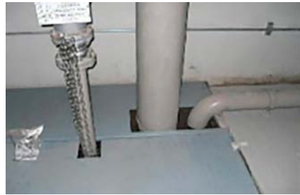
▲ 저수조 넘침관 말단부에 해충유입 방지시설 설치 검토
