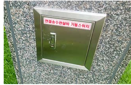
▲ 옥외 연결송수구 펌프용 수동스위치함 방수형으로 교체
