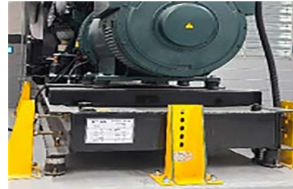
▲ 비상 발전기의 내진 스토퍼 추가 설치
