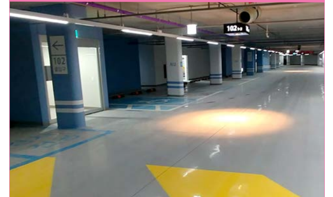
▲ 지하주차장 출입구 조명 설치로 보행자 시인성 향상
