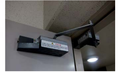
▲ 갑종(1종) 방화문 도어체크 설치
