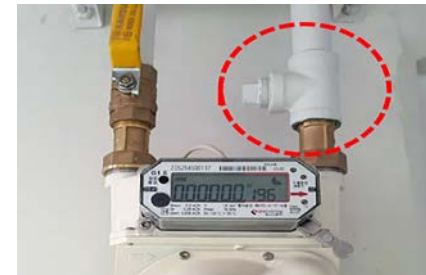
▲ 가스배관 T분기 시공으로 가스렌지, 가스건조기 사용 가능
