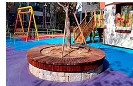
▲ 플랜터는 토사 흘러내림 방지를 위해 관목 및 초화류를 식재하였으나, 앉는 기능에 문제가 없는 관목 및 초화류를 식재 필요
