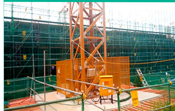
▲ 타워크레인 용접 부위 자체 비파괴 검사 실시
