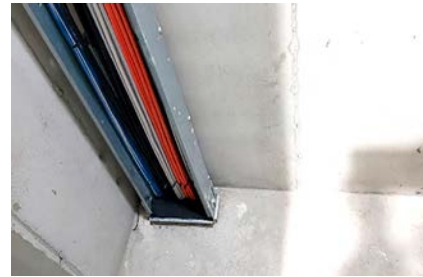
▲ TPS실의 트레이 마감 후 개구부 및 케이블에 방화처리제 시공으로 마감
