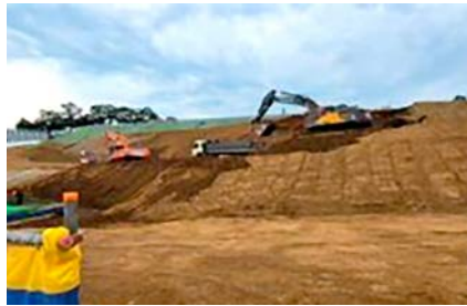
▲ 토사 유실 방지를 위해 사면 천막 설치 필요
