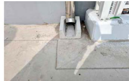
▲ 선홍통 하부 곡관처리 후 빗물받이돌 설치
