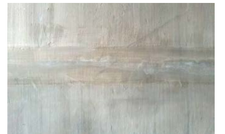
▲ 조인트 부분 방수시공 및 백화 제거
