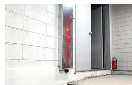
▲ 트레이 커버 설치 완료
