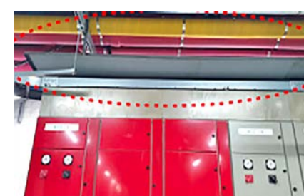
▲ 기계실 동력제어반 상부에 레인판(PAN) 설치하여 트런치까지 유도배수
