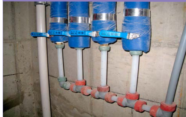
지하 입상 배관 말단 배수관 처리
