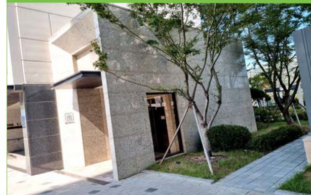
옥외 승강기 골조시공
