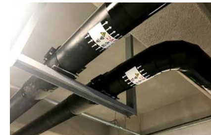
▲ 지하주차장, 기계실 지역난방 고온수 1차 측 배관 위험 표지 부착
