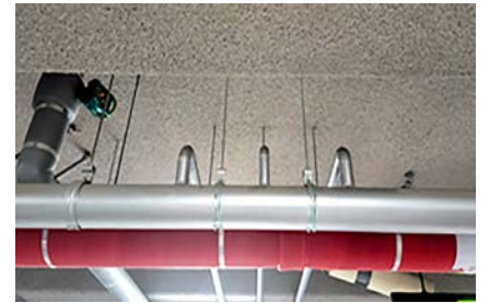
▲ S/P 교차배관에 가지배관과 가지배관 사이마다 1개 이상의 행거 설치
