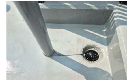
▲ 옥상 우수드레인 고정용 고리 설치 및 내부 거름망 설치, 방청도장
