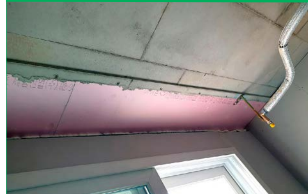
▲ 거푸집 해체 시 세대 천장 결로방지 단열재 파손 방지를 위해 턱 설치
