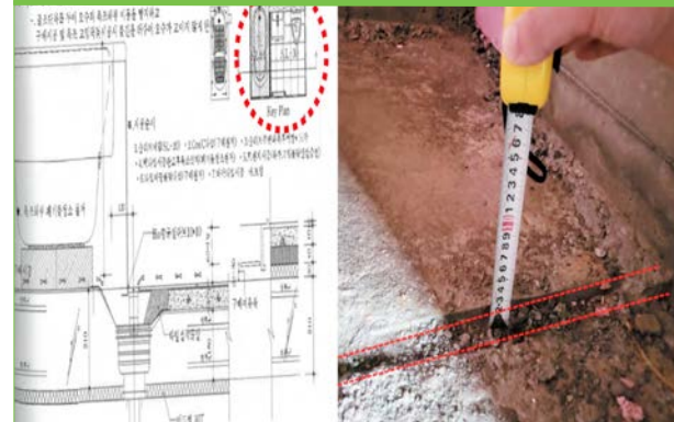
▲ 욕조 하부 물고임에 의한 악취·타일변색 예방을 위해 기존 바닥보다 30mm 높게 시공
