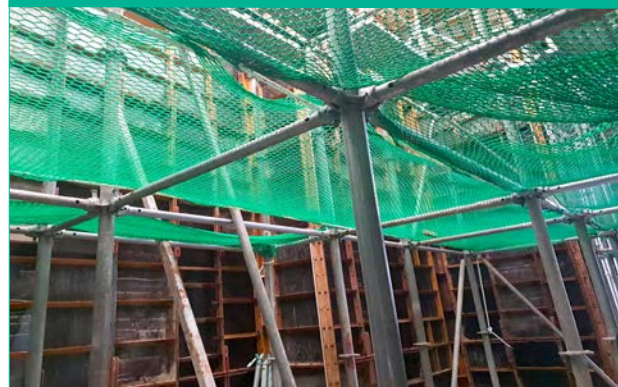
▲ 가설 안전망 설치하여 낙하 및 추락사고 예방
