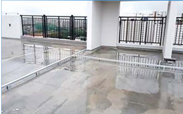
옥외 케이블덕트 시공
