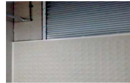
▲ 발전기실 장비 반입구 배수판 시공
