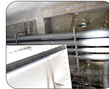
< 저수조 상부 오배수관 시공 >
