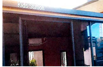
▲ 키즈 스테이션 냉난방기 설치
