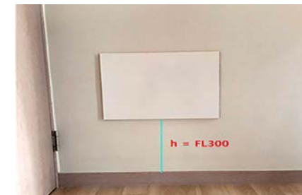
▲ 세대 통신단자함 설치 높이가 낮아 어린이 안전사고 위험
