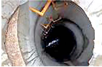
▲ 우·오수 맨홀 덮개 및 내부 사다리 시공 보완
