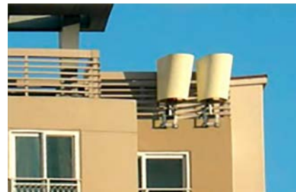
▲ 안테나가 인지되지 않도록 건물 벽체와 유사한 형태의 조형적 요소로 건물 일부 처럼 위장 시공
