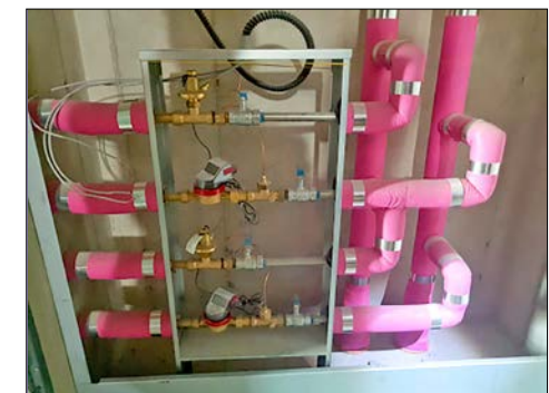
▲ 급수(공급)측에 적산열량계 환수측에 정유량 밸브 설치
