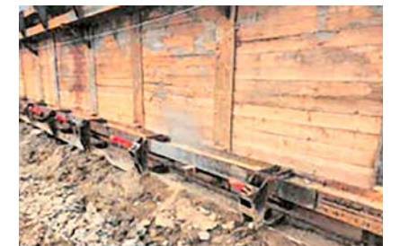
▲ 토류판 변형 부위 뒷채움 및 보수
