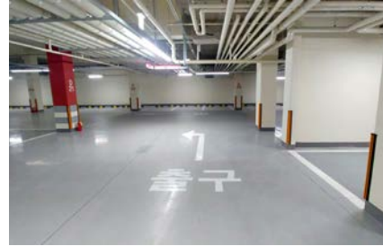
▲ 출구, 동, 지하 등 안내 노면표시 설치
