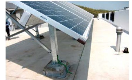
▲ 모서리 부분 보호덮개(완충재) 조치
