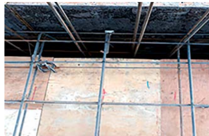
▲ 슬래브 상부근을 외벽 피복두께 위치까지 연장하여 정착 완료
