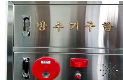
▲ 방수기구함 표지 축광식으로 설치 필요
