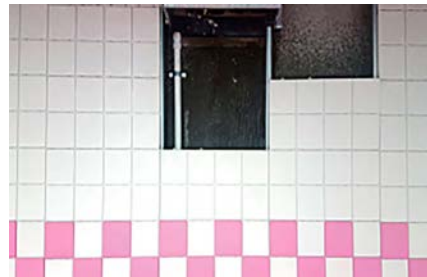
▲ ■ 배수판 및 누수방지용 드레인 설치
