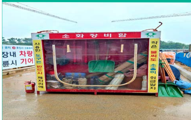
▲ 소화 장비 별도 보관함 설치
