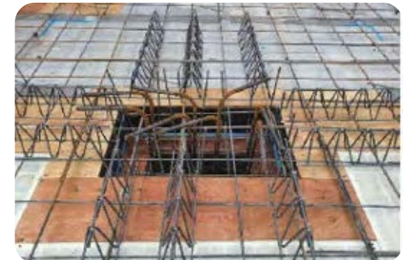
현장 시공 적정여부 확인
