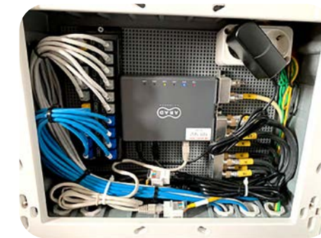
<망 분리를 위한 세대단자함 내 망분리 단말장치 설치>
