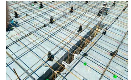
▲ 최상층 벽체 수직철근 정착길이를 준수하여 시공 (90° 갈고리 시공)
