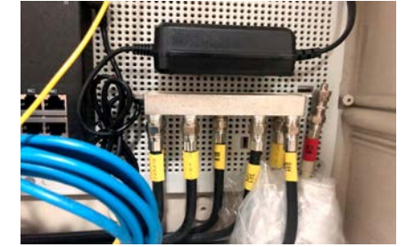
▲ TV분배기 종단기(Dummy) 설치
