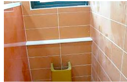
▲ 어린이집 세면기, 욕조 등의 수전은 안전을 위하여 화상 방지용으로 설치 필요
