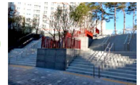
▲ 옥외 계단 중앙부 난간 및 조경시설물 주변 난간대 추가 설치를 통한 보행자 안전성 확보
