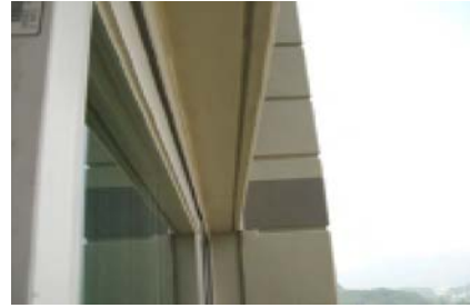
▲ 창 외부 물끊기홈 이물질 제거 등 수정 시공
