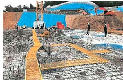
▲ 실족 방지망 설치 등 안전 통로 확보
