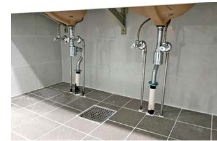
▲ 세면대 트랩을 바닥형으로 시공하여 누수 및 유지관리 불리
