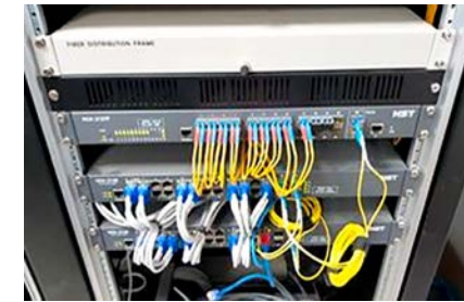
▲ 홈네트워크 단지 서버시스템 관리 불량 및 Ethernet 장비에 먼지 제거 필요
