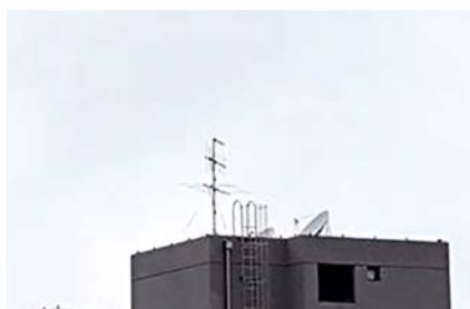
▲ 옥상 TV안테나 주위에 피뢰설비 시공 필요
