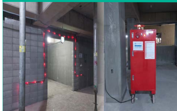
▲ 간이 피난 유도선, 확성기, 수동 소화장치 등 임시 소방시설 설치
