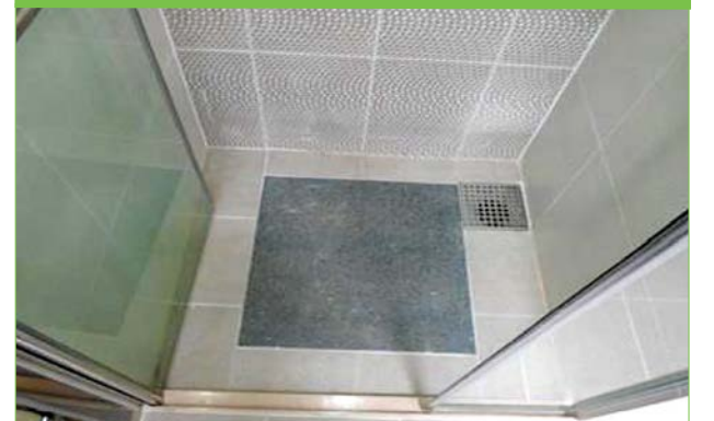
▲ 샤워부스 바닥에 미끄럼방지 판석 시공
