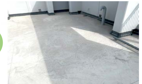
▲ 옥상 바닥 일부 무근콘크리트 동해 및 들뜸 구간 그라인딩 후 면처리
