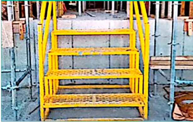
▲ 주동 출입구 철재 계단 제작 설치
