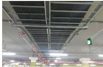
▲ 전기트레이 하부 S/P 헤드 추가 설치
