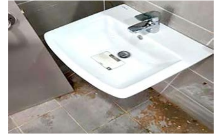
▲ 세면기 타입 변경 설치
