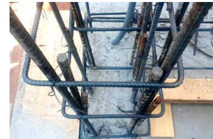
▲ 수직근과 U-bar의 밀착 시공 필요
