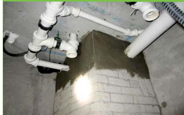
▲ 욕실 상부 배관주위 모르타르 충전
