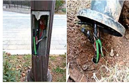
▲ 안전을 위해 개별 및 연결 접지 시공
