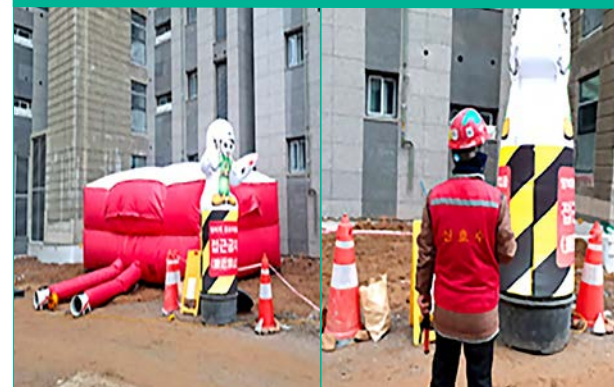
▲ 외부 로프 작업 시 작업구간 하부에 대형 에어매트 설치 및 전담 신호수 배치
