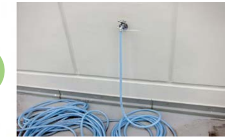
▲ 옥상에 수전 설치로 입주자 편의성 확보(동절기 동파 방지관리 필요)
