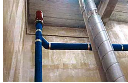
▲ 소화수조 급수배관에 수격방지기 설치
