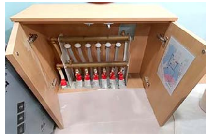
▲ 온수분배기 보호함 설치
