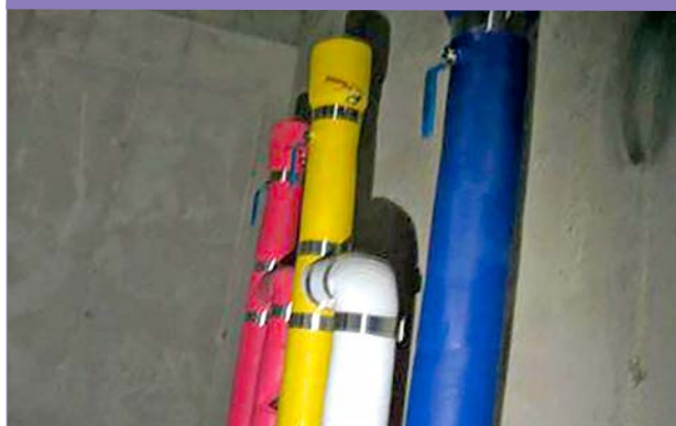
PD 내부 공기변 설치
