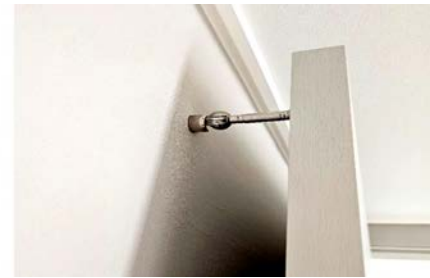
▲ 출입문 손잡이 위치 완충장치(스토퍼) 설치(부착기능 추가)
