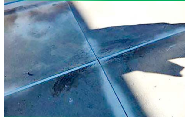
▲ 옥상 신축줄눈 코킹 상태 양호
