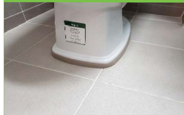
▲ 양변기 하부의 틈새재료를 백시멘트가 아닌 고무재질로 마감하여 유지관리의 편의성 도모
