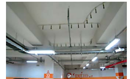
▲ 슬래브 균열 부위 보수
