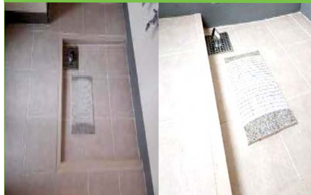
바닥형 빨래판 설치
