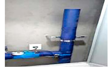
▲ 최상층 공용 PD내부에 설치된 급수 입상배관 고정
