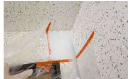
▲ 사인장 균열 보수
