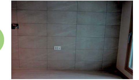
▲ 아트월 시공 시 타일 무늬 고려하여 시공
