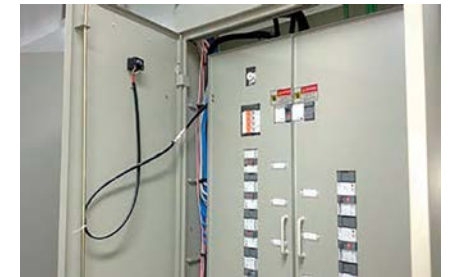
▲ 각동 PM패널 SPD(서지보호장치) 설치
