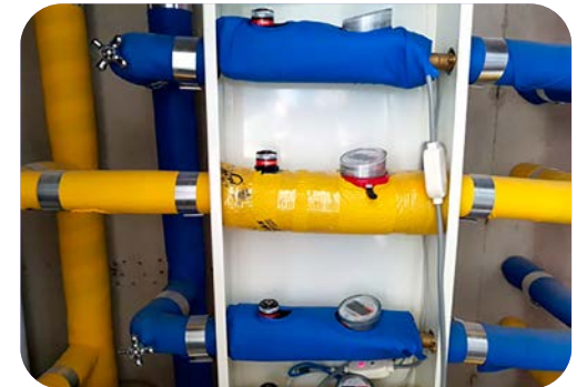
▲ 시공후 보온 상태
