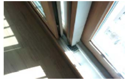
▲ 풍지판(기밀유지) 적정 위치(상·하부) 설치
