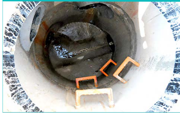
▲ 우·오수 관로 내부 청소 및 마감 구배, 점검발판 설치 양호
