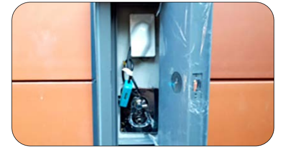
< 동파방지 및 열선 시공 >
