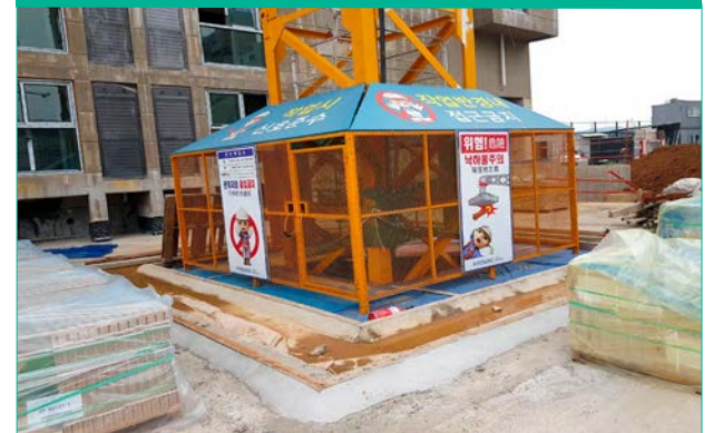
▲ 타워크레인 방호울타리 및 안전 표지판 설치
