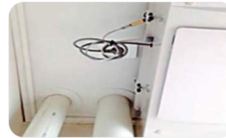
▲ 천장에 콘센트 설치
