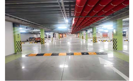
▲ 과속방지턱 설치 완료
