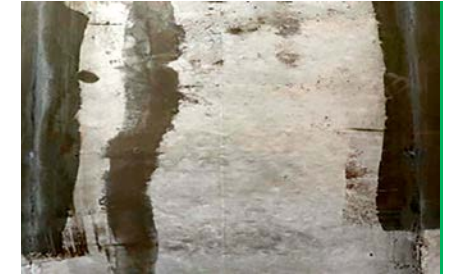
▲ 적정 공법 선정하여 균열 보수
