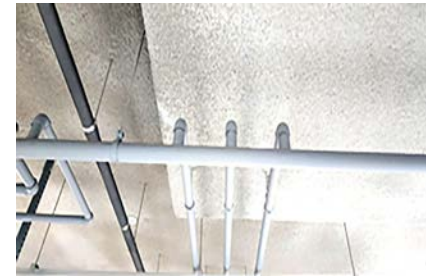
▲ S/P 교차배관에 가지배관 사이마다 행거 미설치
