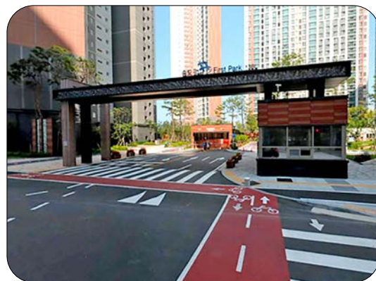
< 고원식 횡단보도 설치 >
