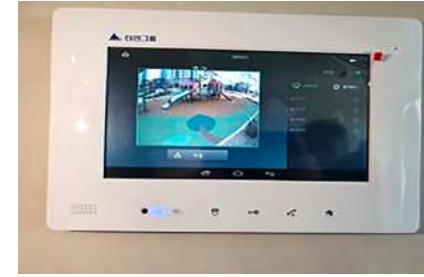
▲ 월패드에 연계된 기능의 작동 성능 점검 및 사용가이드 배포 필요
