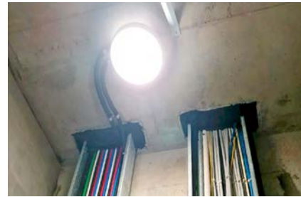
▲ EPS실 내 전등, 콘센트 시공
