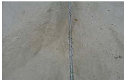
▲ 옥상 무근 콘크리트 커팅 부분 코킹 처리
