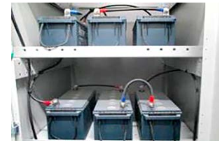
▲ 배터리반 배터리 고정 미흡
