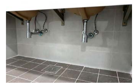
▲ 세면대 트랩을 CAP형 트랜치 설치, 벽체형으로 시공하여 누수방지 및 유지관리 용이
