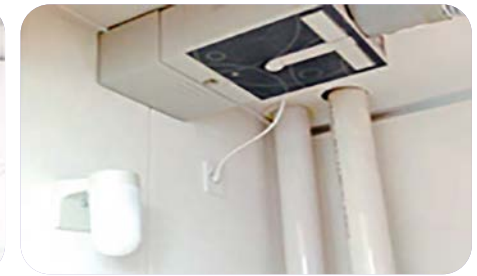
▲ 벽체(외측벽 지양)에 콘센트 설치
