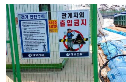
▲ 우기 대비 임시전력 수전설비 주변 배수로 확보
