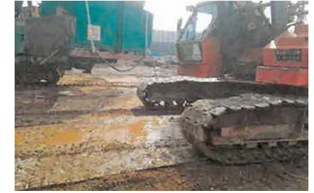
▲ 보조 크레인 주변 철판(Steel plate) 설치
