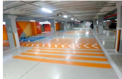
▲ 동 진출입로 횡단보도 등 노면표시 설치
