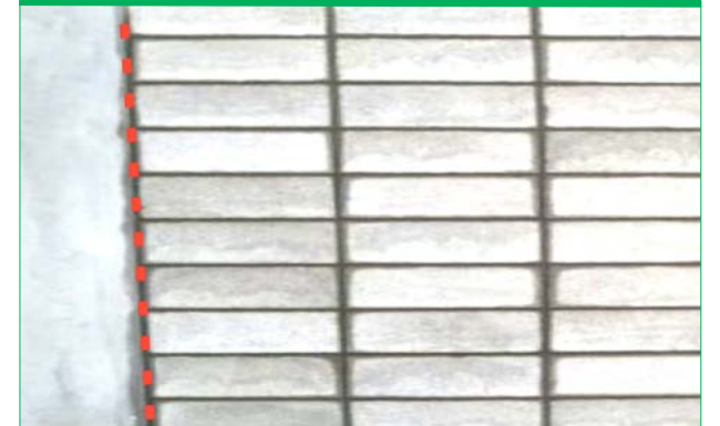
▲ 벽체 이질재(블록+콘크리트기둥) 연결부분에 신축줄눈 및 실리콘 시공
