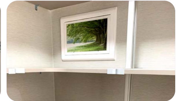
▲ 펜트리 내 분전반 설치
