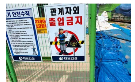
▲ 천막 보양 및 배수로 정비 완료
