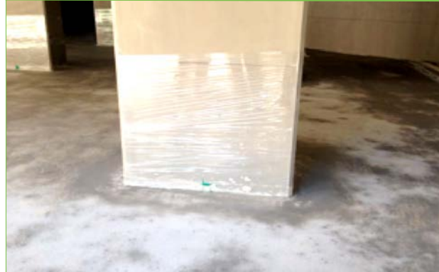
지하주차장 기둥 보양
