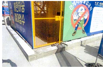
▲ 방호울타리 하부 방수턱 시공하여 우수 침입 예방
