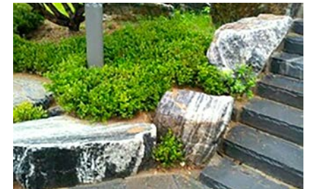
▲ 조경석쌓기 부분 돌틈식생 보식 및 유도수로 설치 (단차, 기울기고려)
