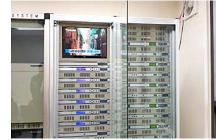
▲ 세대 내 방송이 지상파 HDTV, 다른 방송은 Analog TV 전송으로 구축됨
