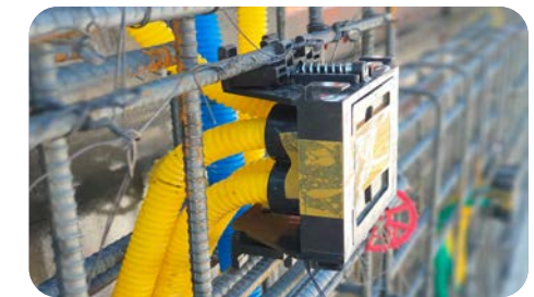
▲ 결로 방지용 박스 설치 예시
