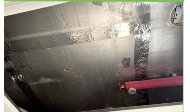
▲ 욕실 천장 단열재 틈새 단열 테이프 시공
