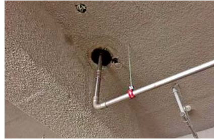
▲ 지하주차장 배관 주변 방수 및 보완시공
