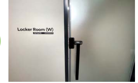
▲ 샤워실 출입 통제를 위한 전자식 잠금장치 설치
