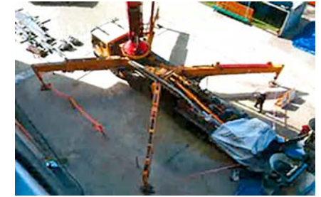
▲ 펌프카 아웃트리거 최대 확장상태 장비 세팅 후 타설 진행
