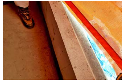
▲ 물 침투 방지를 위해 창호 하부 콘크리트 내부터(반턱) 시공
