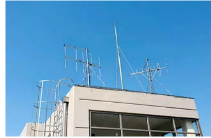
▲ SMATV안테나 중 DMB 안테나 방향을 수직으로 이동하여 재시공
