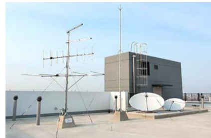
▲ 안테나와 고정 지지선(안테나 및 피뢰침)이 혼촉되지 않게 이격 시공
