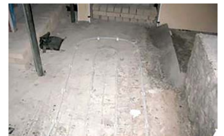
▲ 욕실 이용자 편의 고려하여 바닥 난방 시공
