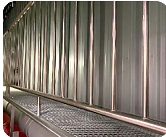
< 실내에 이동발판 설치 >
