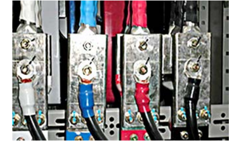
▲ 연결 볼트/너트 마킹 처리 - 전선의 색상 L1 : 갈색, L2 : 흑색, L3 : 회색, N : 청색, 보호도체 : 녹색-노란색
