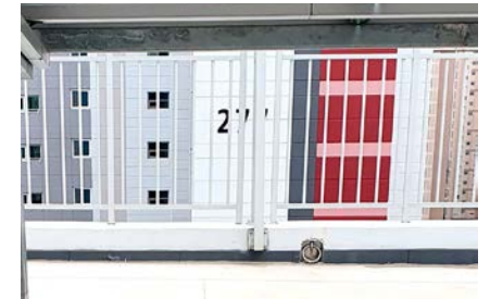
▲ 태양광 배관에 덕트 커버 설치
