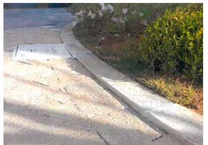
▲ 경계석 수평 시공
