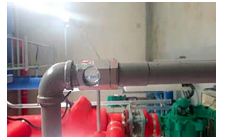
▲ 릴리프배관 사이트글라스 시공
