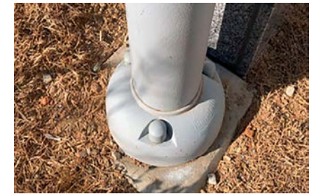
▲ 하부 안전 커버 및 볼트 캡 설치(관목이나 잔디로 커버)
