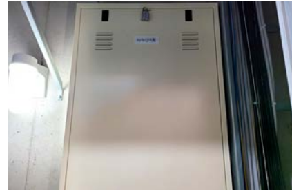
▲ TPS실 내 깊이를 충분히 확보하여 유지관리 용이성 확보하게 시공
