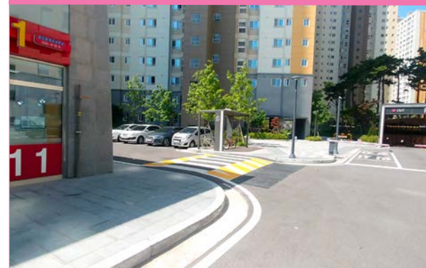
▲ 단지 내 횡단보도를 고원식 횡단보도로 설치하여 속도저감
