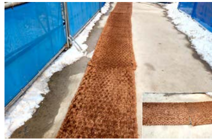
▲ 결빙 구간에 야자 매트 설치하여 근로자 미끄럼 방지 조치
