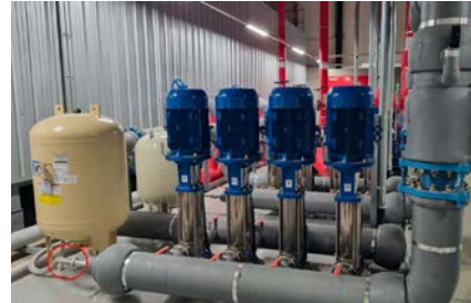
▲ 급수펌프용 압력탱크 드레인 배관 설치
