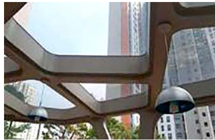
▲ 외부 공용 퍼걸러(파고라)공간 내 조명등용 전선을 햇빛 노출 시, 경화되는 재질로 설치
