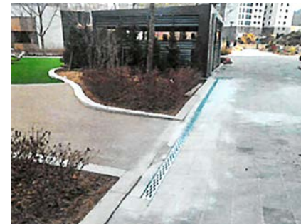
▲ 경계부에 트렌치 설치
