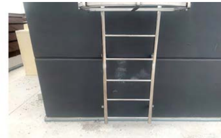
▲ 옥탑 점검사다리 길이 연장 및 시건장치 설치
