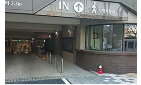
▲ 보도와 차도 사이 방호울타리 설치
