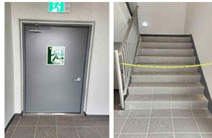
▲ 피난 안내시설 설치 및 승강기 기계실 진입제한 시설 설치
