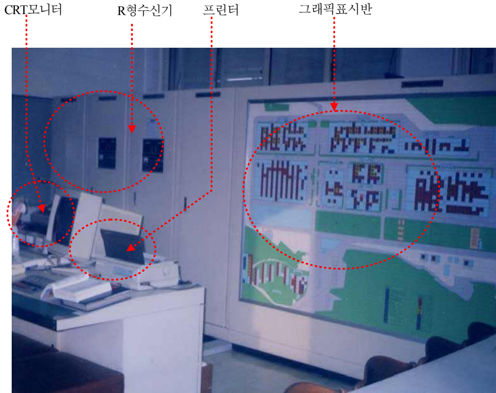
[그림 2-60] R형 시스템으로 구성된 방재센터
