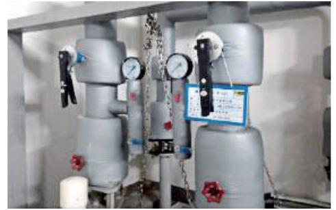
● 기계실 집수정 배수펌프 인양용 체인 스테인리스 재질로 변경
