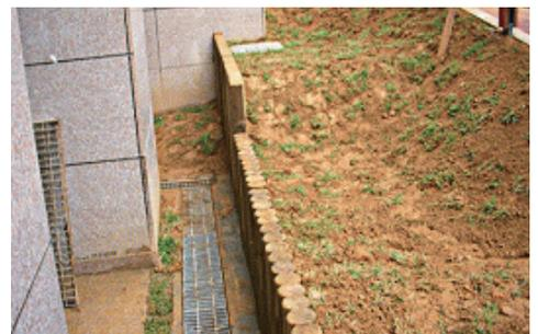
● 조경토 유실 방지를 위한 흙막이 (목재 경계재) 설치
