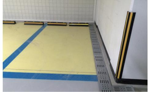
● 보행동선에 설치된 트렌치에 폐쇄형 커버 설치
