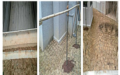
● PC트렌치 설치 및 경계석흠따기, 구배조정 실시
