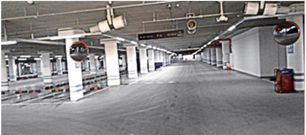
〈교차지점 도로반사경 설치 예시〉
