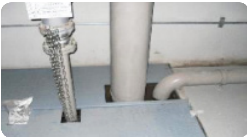
- 저수조 넘침관 말단부에 해충 유입 방지시설 설치 검토
