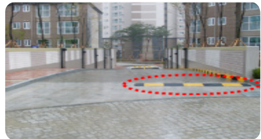
- 과속방지턱(험프) 설치로 내리막길 과속 방지
