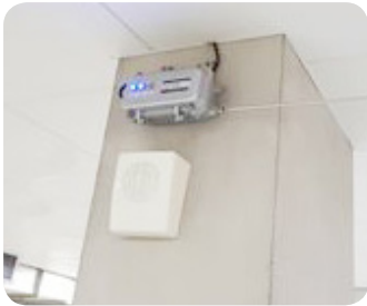
- FM/DMB 재전송 설비의 커버리지를 측정하여 음영지역 보완 시공
