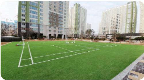
- 옥외 주민운동시설에 보안을 위한 CCTV 설치 누락
