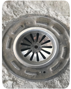
- 옥상 우수 드레인 고정용 고리 설치 및 내부 거름망 설치, 방청 도장
