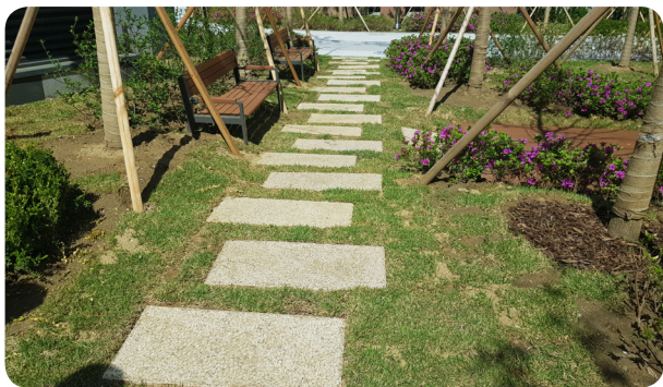
- 디딤돌 설치와 식재, 벤치 배치 등 조경시설물의 시공 품질 상태
