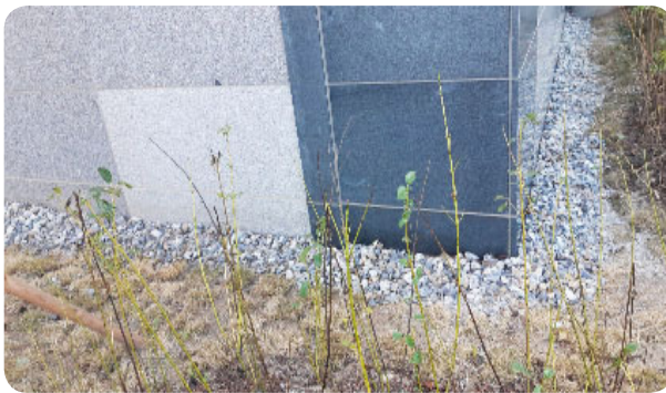
- 건물 주변 배수용 자갈 포설 시공으로 원활한 우배수 처리, 흙탕물 튀김 현상 방지
