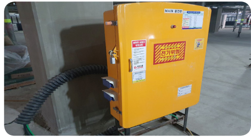
- 분전반 시건장치 설치 완료
