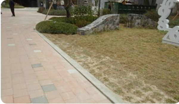
- 곡선구간 경계석 처리 및 배수시설 설치 우수
