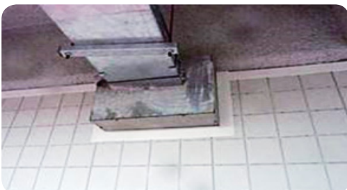
- 지하주차장 전력인입폴박스 부분 배수판 설치 검토
