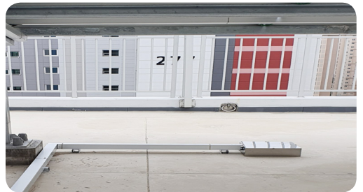
- 태양광 배관에 덕트 커버 설치
