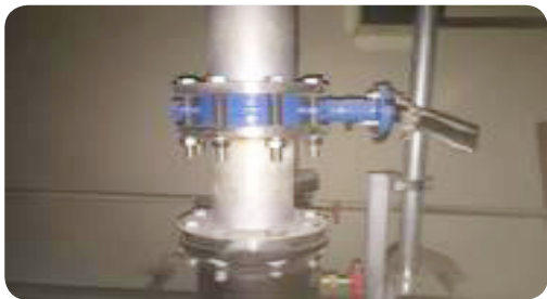
- 빗물저류조 배수 배관 볼트·너트 절연 시공
