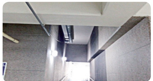
- 보행통로 전등 추가 설치하여 조도 확보
