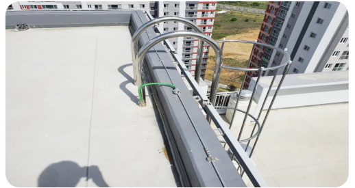
- 옥탑 점검용 사다리 피뢰도선 접지 완료
