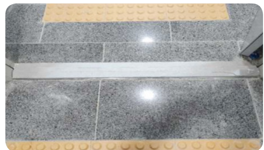
- 하부 문틀 보양 철판 시공 완료
