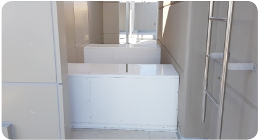
- 배기덕트 보호 커버 시공
