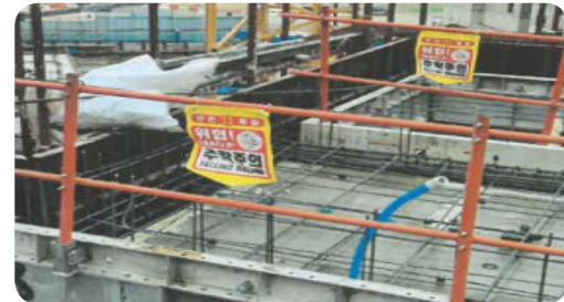
- 추락방지용 안전난간 설치 완료
