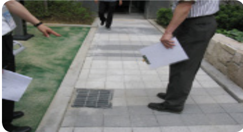
- 보행자 동선 구간의 스틸그레이팅 집수정 덮개 설치
