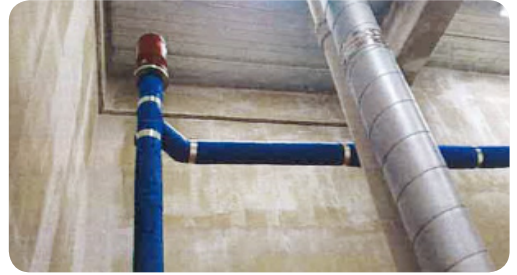
- 소화수조 급수배관에 수격 방지기 설치
