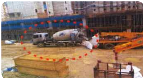
- 공사차량 및 장비 유도자 배치 및 충돌 방지 조치 필요
