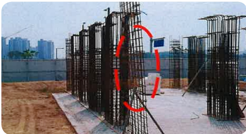
- 필로티 웅벽 철근 조립구간의 철근 전동방지를 위해 버팀대 설치
