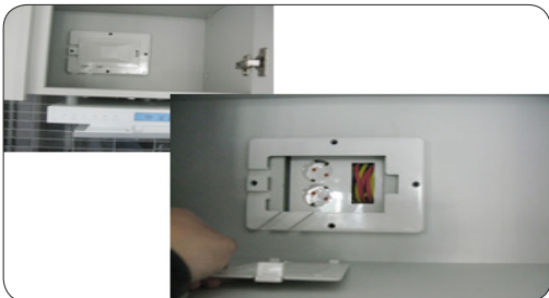
- 안전사고 예방을 위해 점검구 커버 시공
