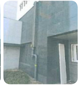
- 외부 도시가스 입상배관 방법 커버 설치
