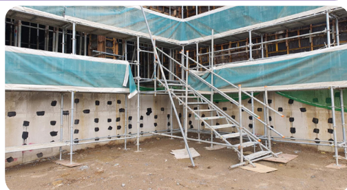
- 손잡이 단부에 보호캡 설치 완료
