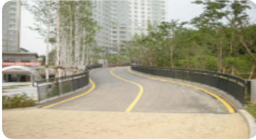
- 단지 내 도로 우수처리 대책 미흡
