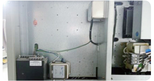
- 서지보호장치(SPD) 설치(제어반 뒷면)
