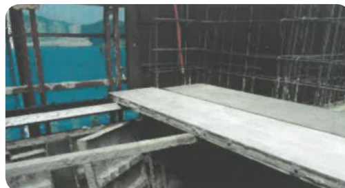
- 알폼과 각 파이프로 만든 임시 작업발판 철거 후 안전 발판 설치 필요
