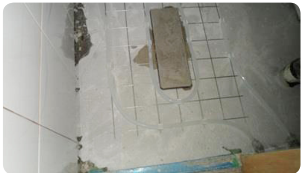
- 욕실 바닥난방 시공
