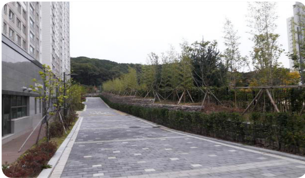
-차폐, 안전보호벽 설치
