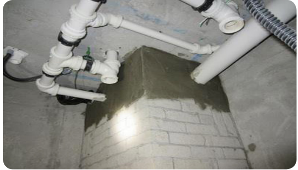
- 욕실 상부 배관 주위 모르타르 충전
