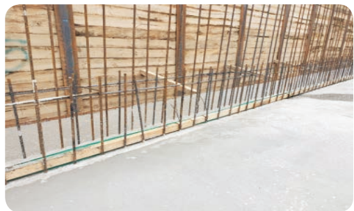
지하 외벽 시공이음부에 지수판 설치 시 목재에 고정하여 정밀시공으로 누수예방
