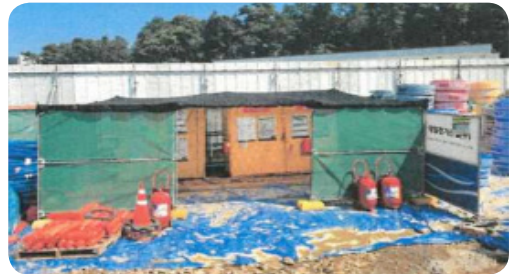
- 유류저장소 상부 차광막 설치
