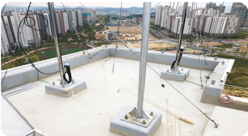
- 안테나 플레이트에 접지 시공 처리 완료
