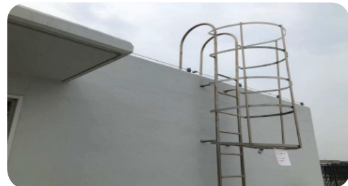
- 사다리 등받이 추가 설치 완료
