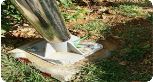
- 옥외 CCTV 카메라 및 폴대에 접지케이블 시공
