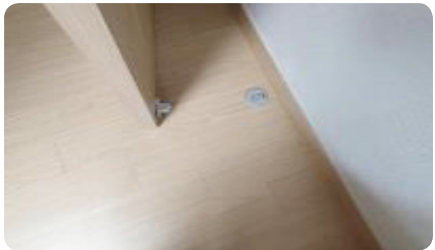
- 바닥 스토퍼 설치
