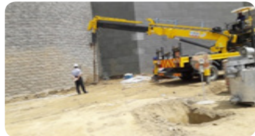
- 옹벽 하부 그라우팅 보강
