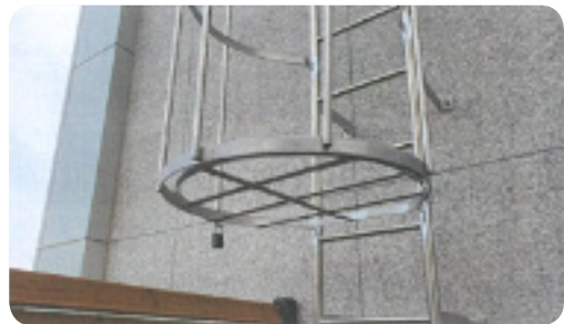
- 옥탑 점검 사다리 시건장치 설치
