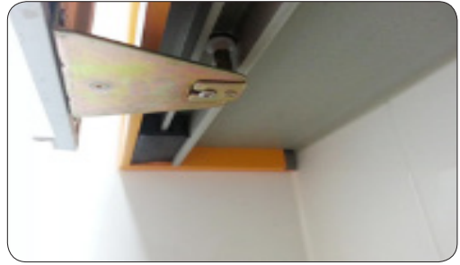
- 욕실 수납장 슬라이딩 도어 스톱퍼 설치
