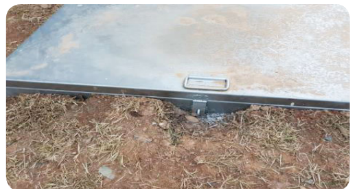
- 녹지대 수직 우수 드레인 및 각종 점검구 잠금 (시건) 장치 설치
