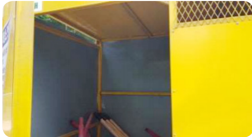
- 위험물 저장소 내 확산식 소화기 설치 필요
