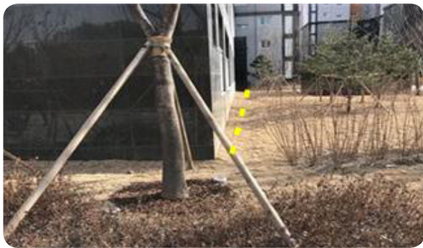
- 석재면과 접하는 조경 부위에 잔디 수로를 설치하여 지반 동결 시 외벽 석재 파손을 방지
