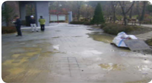
- 단지 내 보도블록 물고임 발생
