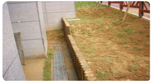
- 조경토 유실 방지를 위한 흙막이(목재 경계재) 설치
