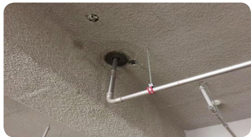
- 지하주차장 배관 주변 방수 및 보완시공
