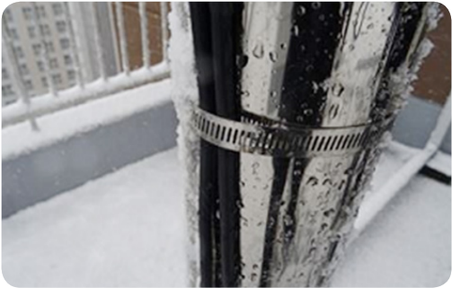
- 옥상 TV 안테나 동축케이블 고정부위 케이블 보호 조치 필요
