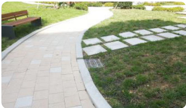
- 집수정 설치 위치를 녹지부에 설치하여 보도부의 빗물 집수와 함께 녹지내 잔디수로의 빗물을 동시에 집수할 수 있도록 시공
