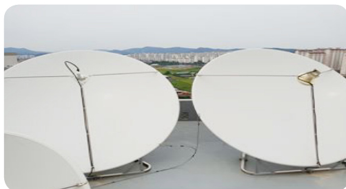
- 안테나용 케이블 배관의 방수처리
