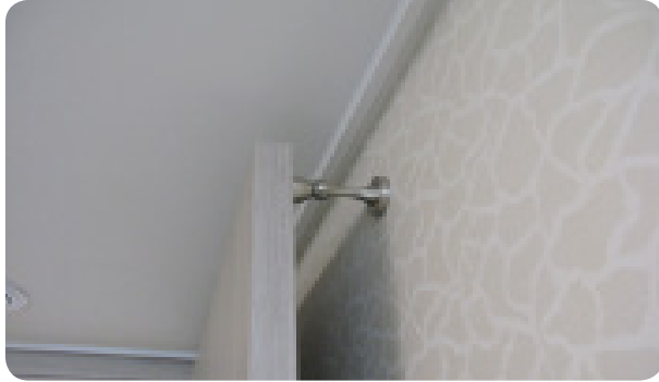
- 침실 출입문 자석형 스토퍼 설치
