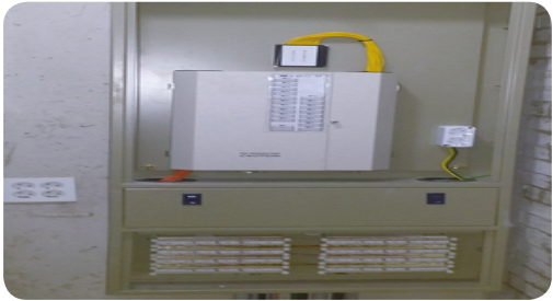
- FDF와 연결된 장비를 추가 시공하여 보완
