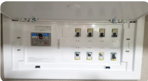
- 전기 분전반 내부에 유지관리 위한 스위치별 설명칭 및 회로도 또는 회로 설명서 미부착
