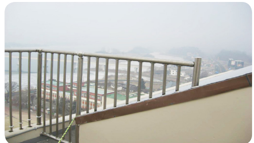
- 옥상 난간 연장 설치로 안전 확보
