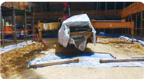
- 콘크리트 펌프카 전도 방지를 위해 아웃 트리거 확장 등을 고려하여 위치 선정
