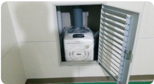
- 지하 승강기홀 제습기 설치
