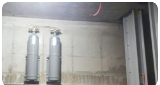
- 소공간 자동소화장치 설치
