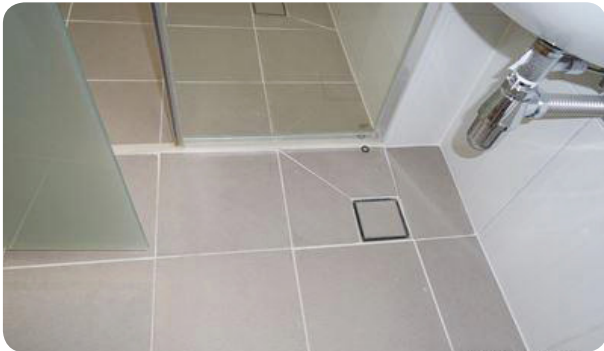
- 욕실 바닥 드레인(바닥 마감과 조화) 시공
