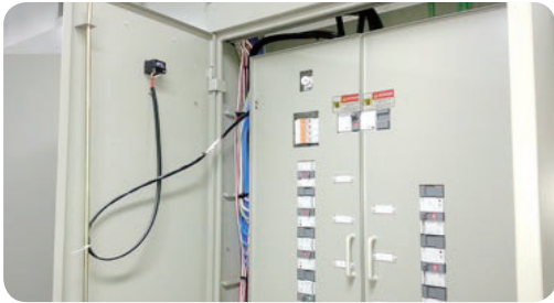
- 각동 PM 패널 SPD(낙뢰보호기) 설치
