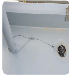
- 옥상 우수 드레인 고정용 고리 설치 및 내부 거름망 설치, 방청 도장
