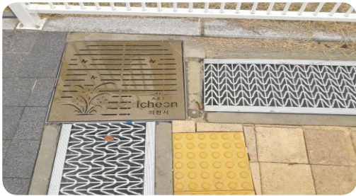
- 집수정, 배수로, 포장 마감을 주변 구조물과 조화 되도록 시공
