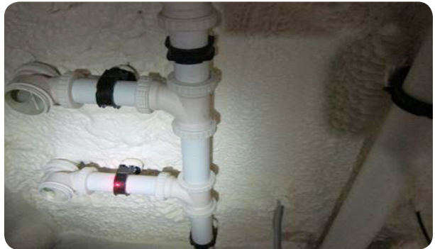
- 욕실 천장 단열재 뽐칠 시공으로 층간 소음, 누수 등 보완 시공
