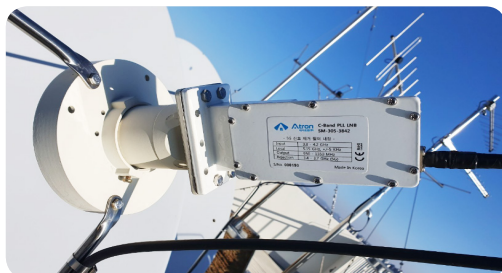
-아시아셋 위성 LNB를 5G 신호 간섭 제거용으로 교체하여 시공
