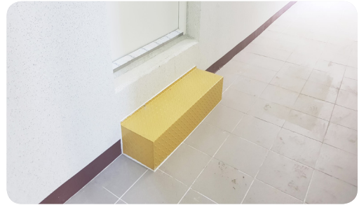
- 계단 설치 완료
