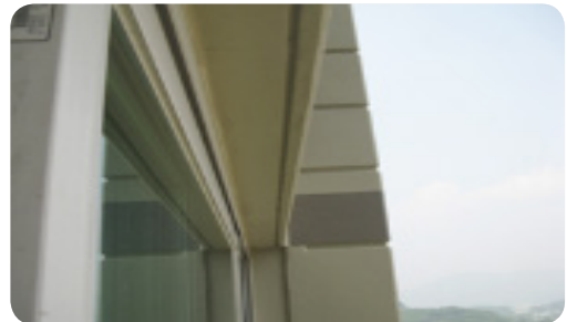
- 창 외부 물 끊기홈 이물질 제거 등 수정 시공
