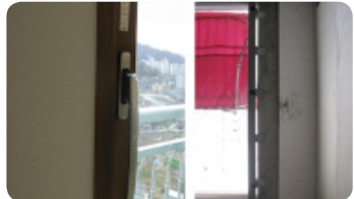
- 창호 지지 브래킷 개수 조정 및 충진재 기밀 시공 - 창호브라켓 결로방지를 위해 단열 폼 시공
