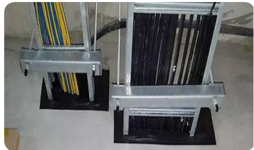
화재 확산(연돌효과) 방지를 위한 방화실 란트로 구멍 밀실 시공
