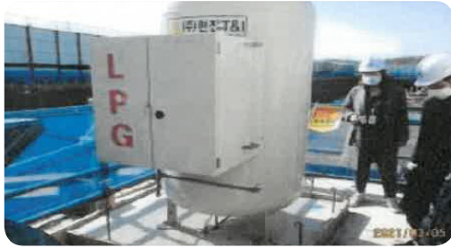
- 가설 식당 옆 LPG 저장소 출입제한 시설 설치
