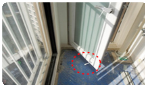
- 출입문 하부 충격 완충 장치 설치
