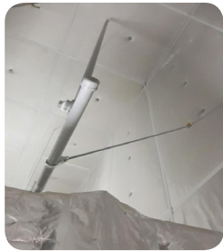
- 배관 말단부에 버팀대 설치
