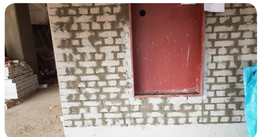
- 조적 벽체 내 배관 매입부분 밀실 사춤
