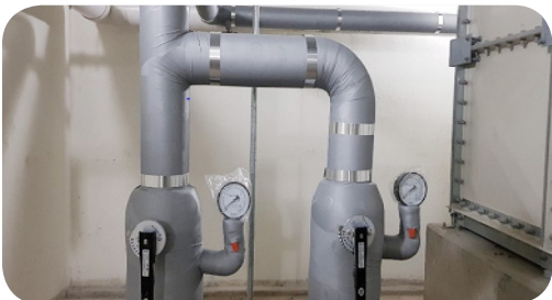
- 배수펌프 결로방지 보온 시공
