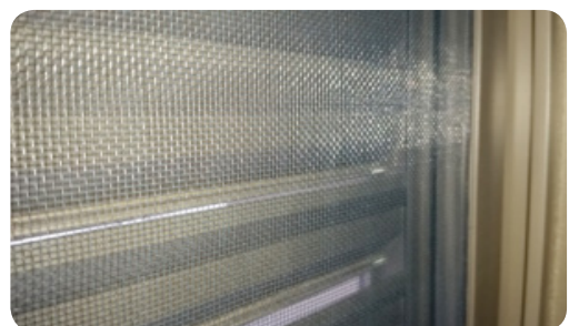
- 승강기 기계실 창문 방충망 설치
