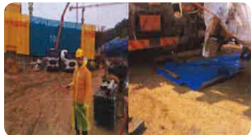
- 차량 유도자 배치 및 충돌 방지 스토퍼 설치
