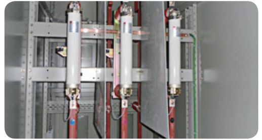
- 파워 퓨즈 사이 격벽 설치
