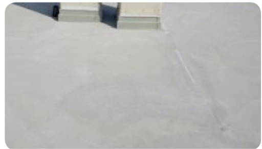
- 옥상 바닥 일부 누름콘크리트 박리 구간 그라인딩 후 면처리
