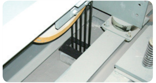
- 승강기 기계실 인양 로프 인출구 소음방지판 설치
