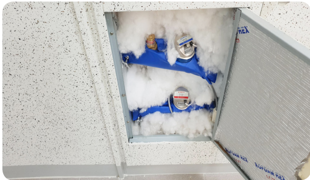
- 수도계량기함 동파방지 설치 상태 양호
