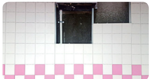
- 배수판 및 누수 방지용 드레인 설치
