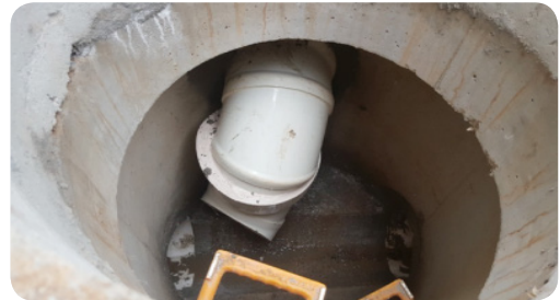
-부관 설치 완료
