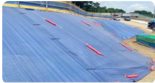
- 사면 천막이 설치 완료
