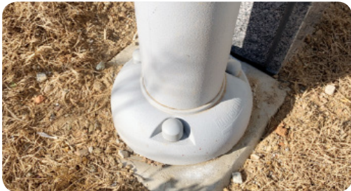
- 하부 안전커버 설치 및 볼트
