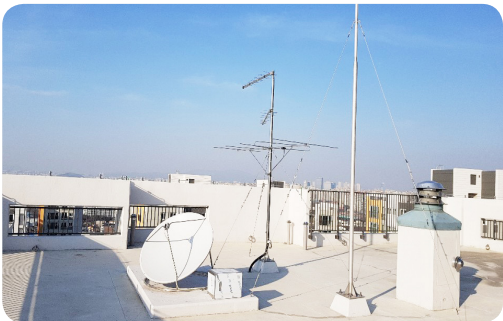
- 안테나용 피뢰설비 추가 설치하여 안전성 확보
