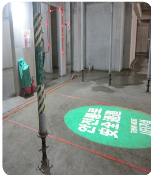
- 안전통로 및 정전대비 비상 전력시설 1.5V 비상등 설치
