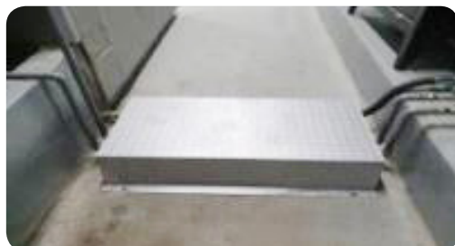
-발전기실 급유배관 보호 발판 설치
