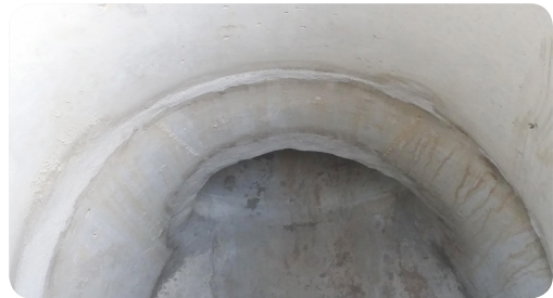
- 접속 관로 돌출부 제거 및 배관 주변 사춤 철거
