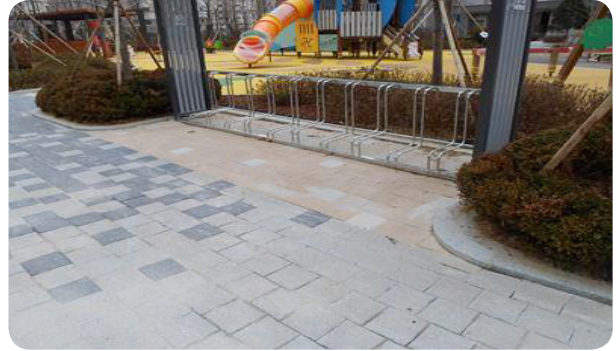
- 자전거 보관소 주변 경계석 낮춤 및 라운딩 처리 우수
