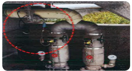
- 선큰 등 옥외에 설치된 집수정 배관 동파방지 열선 시공
