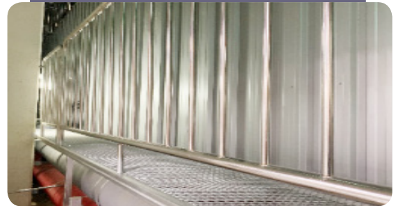
실내에 이동발판 설치
