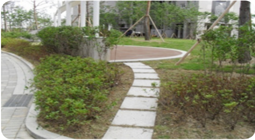
- 임의 동선 발생 우려 부분에 디딤돌(화강석 판석) 설치
