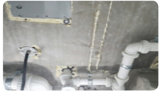
- 천장 단열재 결손 부위 우레탄폼 충전
