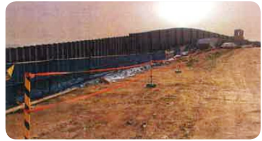
- 작업자 이동 통행로 설치
