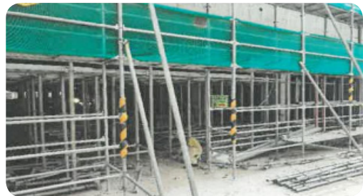
- 보행통로용 표지판 및 표식 설치 완료
