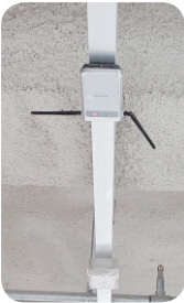
- FM/DMB 재전송 설비의 커버리지를 측정하여 음영지역 보완 시공
