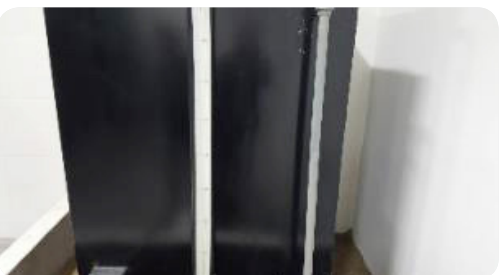
- 발전기용 연료탱크 유량게이지에 2시간 이상 가동 연료 확보를 위한 위치를 표시하고 '비상발전기 운전 요령(2시간 이상 연료 확보 문구 포함)' 부착 필요
