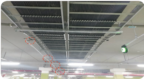
- 전기 트레이 하부 스프링클러 헤드 추가 설치
