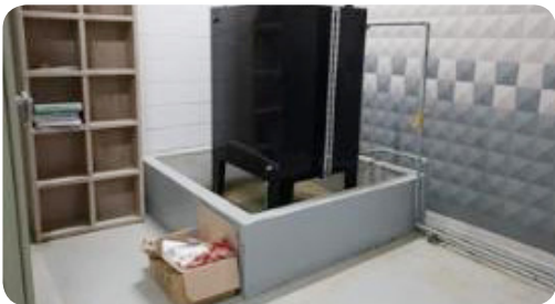
- 비상발전기 경유탱크에 용량 안내 및 한계 수위 표시 필요
