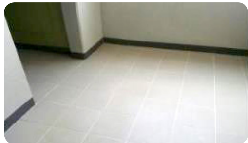
- 승강기홀 및 계단실 바닥 타일 줄눈 처리 및 청소 실시
