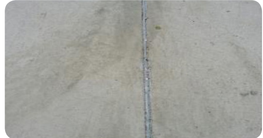
- 옥상 누름콘크리트 커팅 부분 코킹 처리
