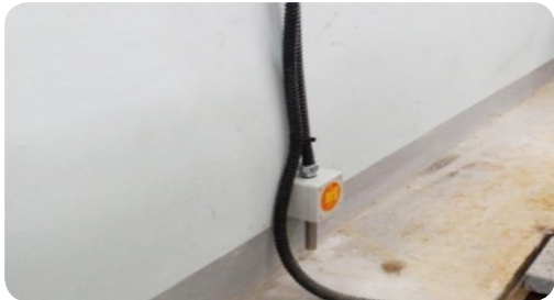
- 기계실 바닥 트렌치에 침수 감지장치 추가 설치
