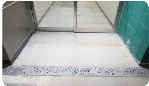
- 동 출입구는 보행자 동선 고려하여 폐쇄형 커버 설치(하이힐 낄 방지)
