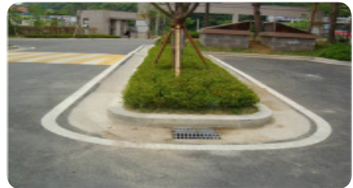
-집수정 설치 및 구배 조정하여 배수 유도
