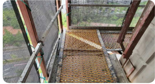
- 안전 덮개 설치 완료
