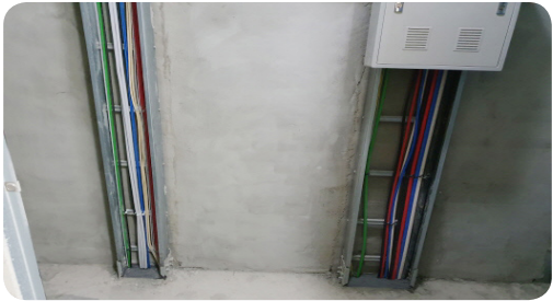
- TPS실의 통신 케이블 마감 상태와 청소 상태 양호
