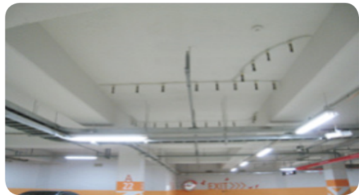
- 슬래브 균열 부위 보수
