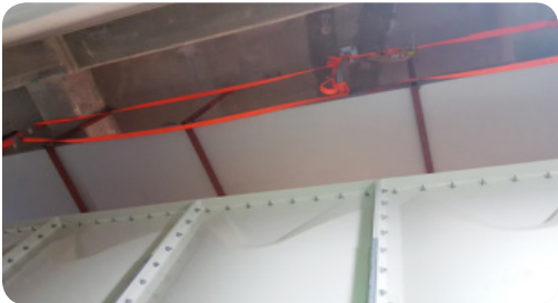
-저수조 상단 배관 하부에 배수판 설치
