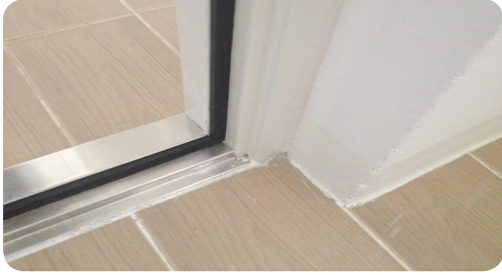
- 방화문 개스킷 밀실하게 고정 설치
