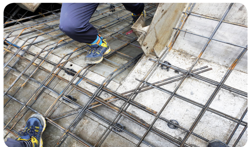
계단실 UP/DOWN 접한 부분 사인잔 방지 보강근 시공
