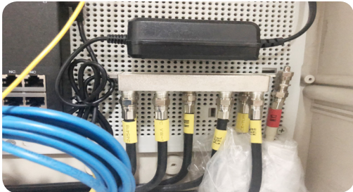
- TV 분배기 종단기(Dummy) 설치
