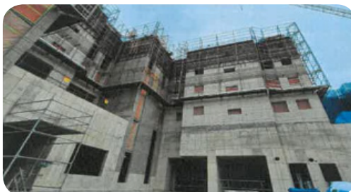
- 갯폼 수직보호망 설치 필요
