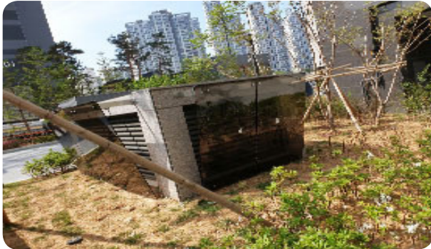
-배기구 전면에 강화유리를 설치하여 미관 및 주거환경 개선
