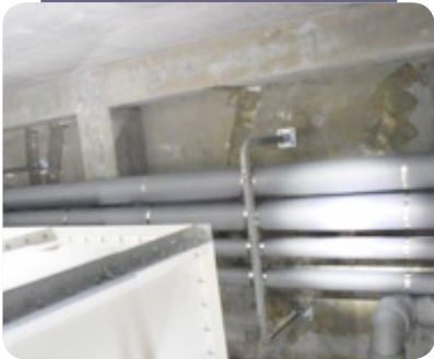
저수조 상부 오배수관 시공
