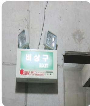
- 안전통로 및 정전대비 비상 전력시설 1.5V 비상등 설치
