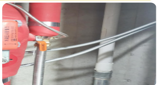
- 신정통기관 설치 완료
