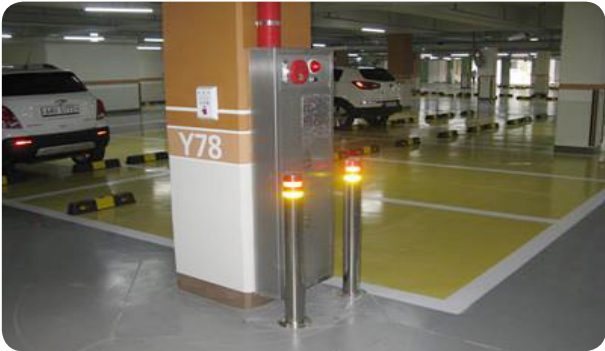
- 지하주차장 소화전 시인성 및 파손 방지시설 시공 우수
