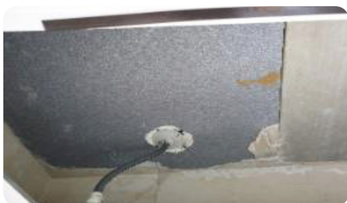
- 단열재 조인트 충전 및 시멘트 페이스트 제거
