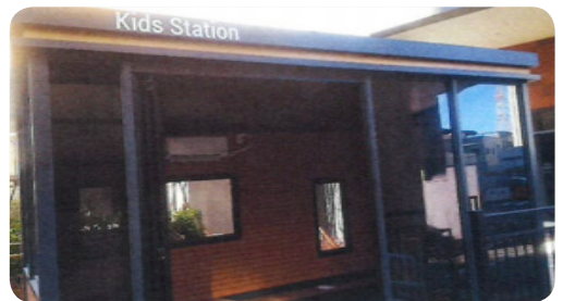
- 키즈스테이션 냉·난방기 설치
