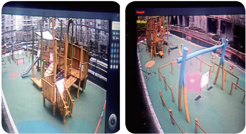
- 사각지대가 없도록 CCTV 위치 조정하여 보완
