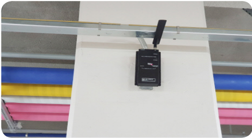
- 지하주차장 FM/DMB 안테나와 Tray와 간섭으로 음영지역 발생
