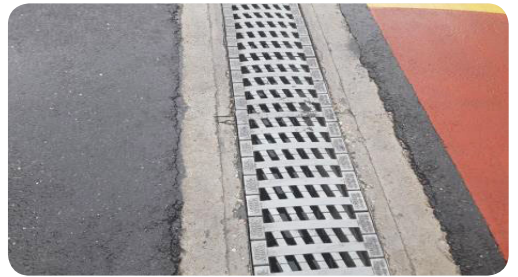
- 포장 패턴, 재료별, 디자인 고려하여 시공
