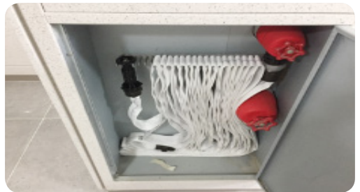
- 옥내 소화전함 내 호스 및 관창 방수구 연결
