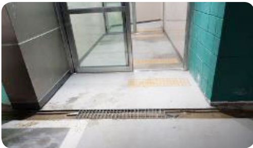
- 지하주차장에서 각 동 출입구 오픈형 트렌치 커버 설치
