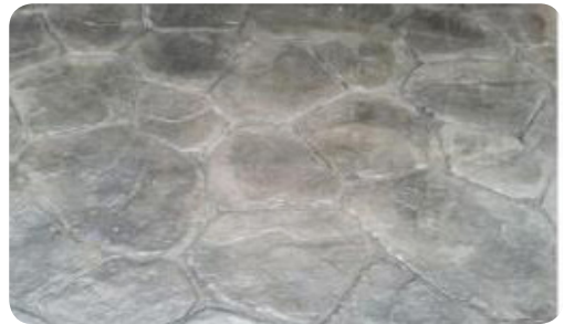
- 지하주차장 바닥 조면 처리 및 표면 강화 코팅 조치
