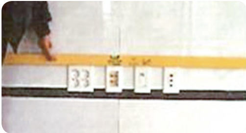
- 수평 측량하여 전기 콘센트 시공
