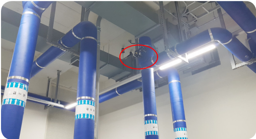
- 수격 방지기 교체 등 유지관리를 위한 차단밸브 설치
