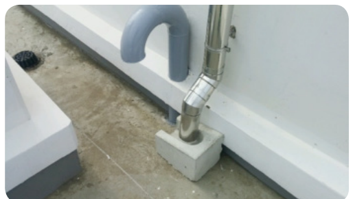
- 선홍통 하부 빗물받이 설치
