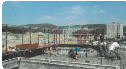
- 갯폼 최상단 발판에서 계단실 내측으로 추락 위험 방지를 위해 안전난간 설치
