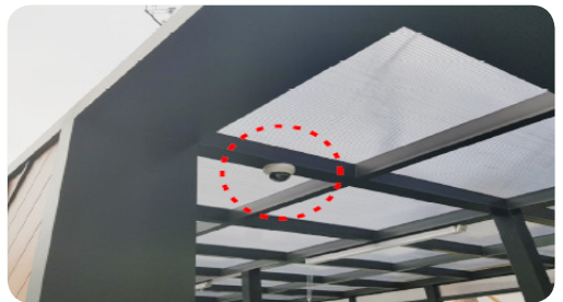
- CCTV와 센서등을 시공하여 주민들 민원을 사전에 예방
