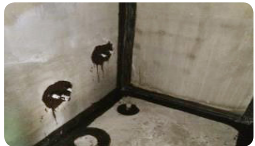
- 욕실 코너 부위·배수구 주변 우레탄 보강 방수 시공
