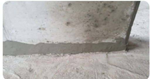
- 벽체 하부 재료분리 부위 폴리머몰탈(보수 승인 제품)을 사용하여 보수 완료
