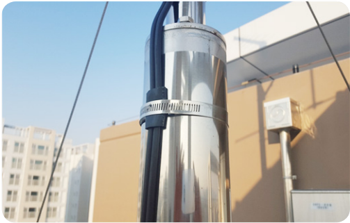
- 케이블 보호용 고무 보호대 설치
