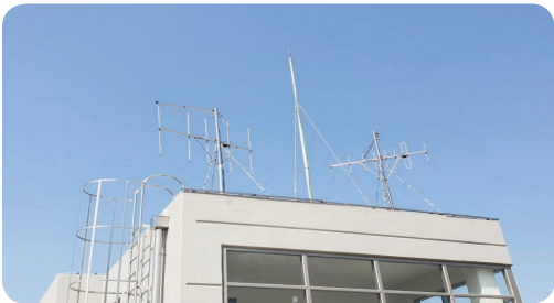
- SMATV 안테나 중 DMB 안테나 방향을 수직으로 이동하여 재시공
