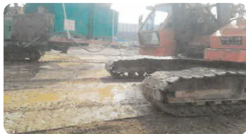
- 보조크레인 주변 복공판 설치 완료
