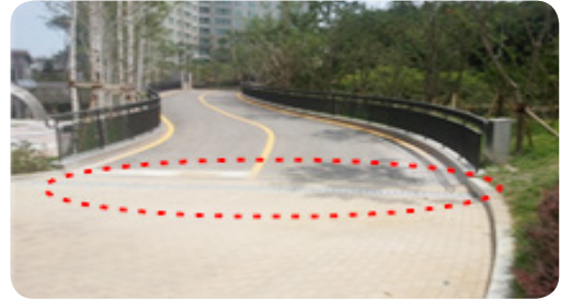
- 도로 우수처리를 위한 트렌치 시공
