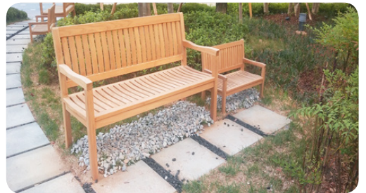
- 음영지 벤치 하부 자갈 포설로 마감 처리 (유실 방지 조치)
