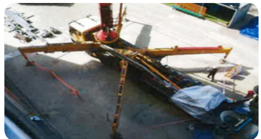
- 펌프카 아웃 트리거 최대 확장 상태 장비 세팅 후 타설 진행
