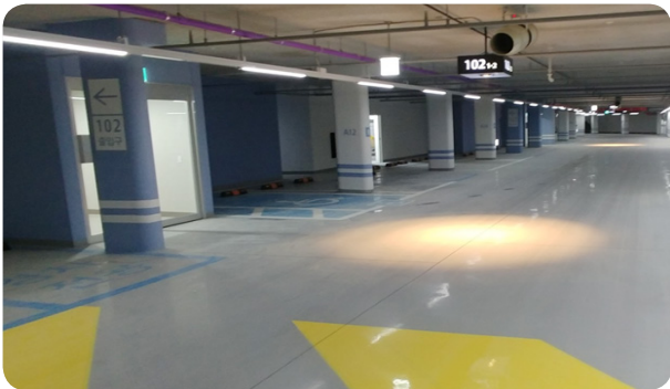
지하주차장 출입구 조명
