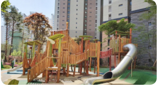
- CCTV를 조경수와 이격하여 설치함으로 간섭 제거하여 화각 확보
