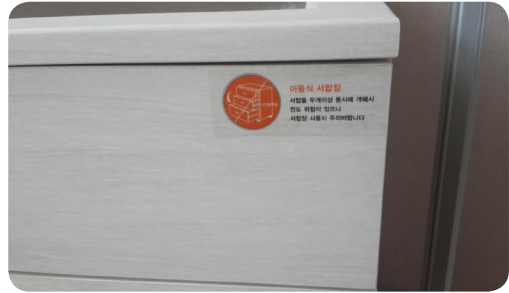
- 서랍장에 안내문 부착 및 입주자 안내 책자에 내용 삽입(하부 전도 방지 받침대 시공 권장)
