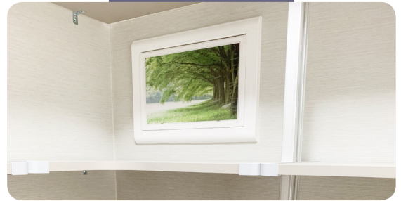
펜트리 내 분전반 설치
