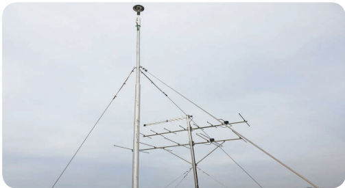
- SMATV 안테나 중 DMB 안테나 방향이 다르게 시공
