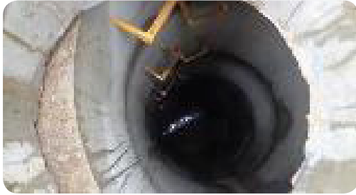
-우·오수 맨홀 덮개 및 내부 사다리 시공 보완
