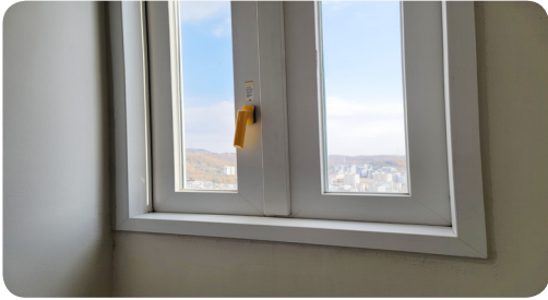
- 대피공간 창문은 개폐방법이 일반창문과 다르므로 사용안내가 필요하나 개폐방법 스티커 미부착
