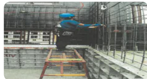
- 안전발판 설치 완료
