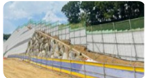
- 사면 천막이 설치 완료
