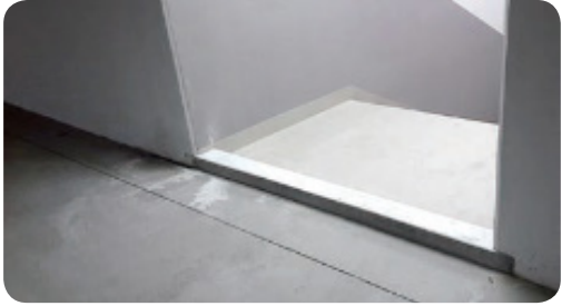
- 전기실 입구 물막이턱 설치
