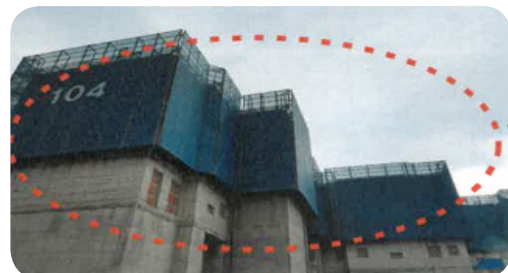
- 수직보호망 설치 완료
