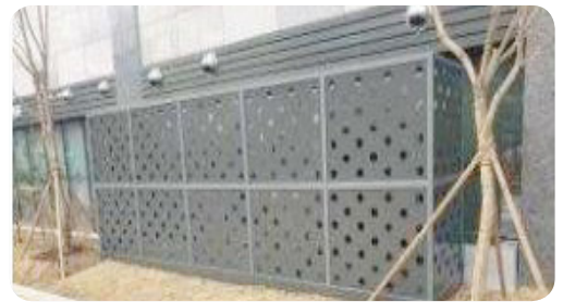
- 에어컨 실외기 차폐커버 설치
