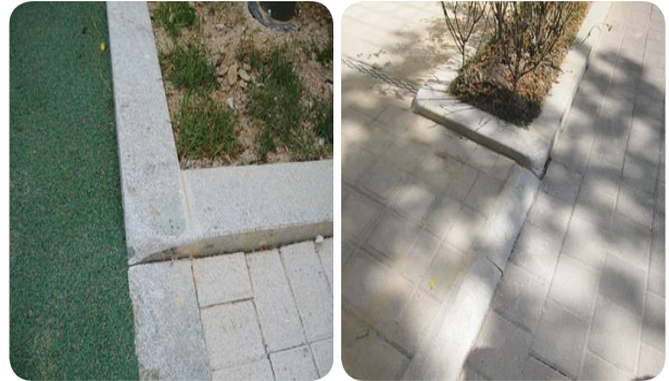
- 경계석 모서리 부위 곡면 시공 우수(특히 보행동선 고려)
