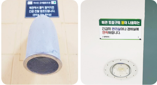
- (좌)넘침관에 해충 침입방지망 설치 및 (우) 주차 공간과 접한 넘침관의 배기가스 유입 방지를 위한 역류 방지 조치
