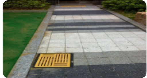
- 보행구간 집수정 커버는 폐쇄형(힐 끼임 방지)으로 설치
