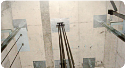
- 승강기 기계실 바닥 하부 플레이트 마감 처리하여 소음 전달 방지
