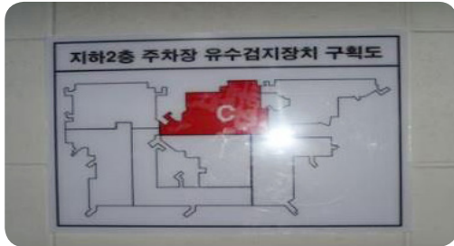
- 지하주차장 스프링클러 프리 액션밸브 방호구역 표지 설치
