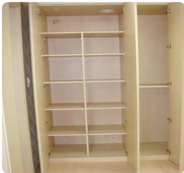
- 불박이장 상·하부 환기구 설치 및 배기팬 시공
