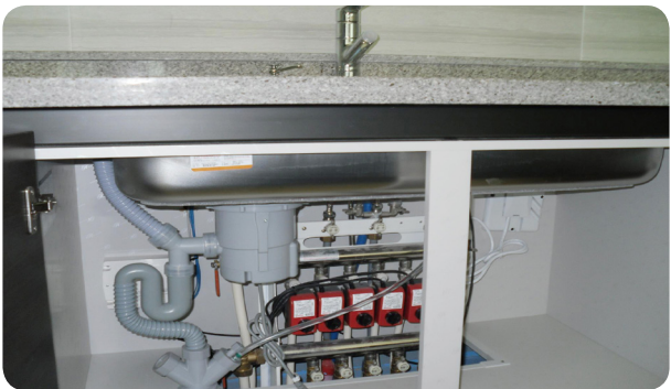
- 싱크대 하부 멀티배수구 반영 시공
