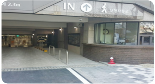
- 보도와 차도 사이 방호울타리 설치
