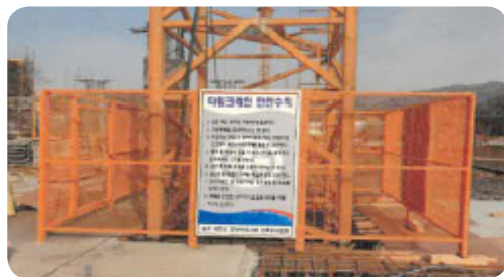
- 방호선반 설치 완료
