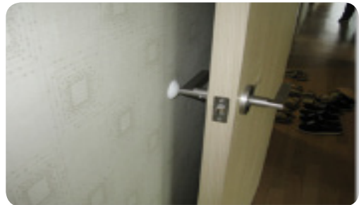
- 출입문 손잡이 위치 완충장치(스토퍼) 설치
