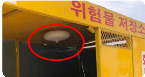
- 확산식 소화기 설치 완료
