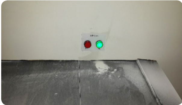
- 1층에 동파방지 열선 작동 상태를 외부에서 확인할 수 있는 표시등 설치
