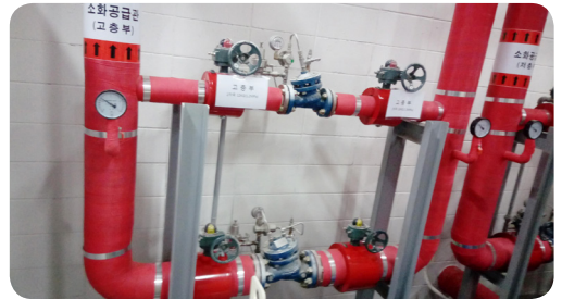
- 기계실 감압밸브 1,2차 측 설정 압력 표지 부착 완료
