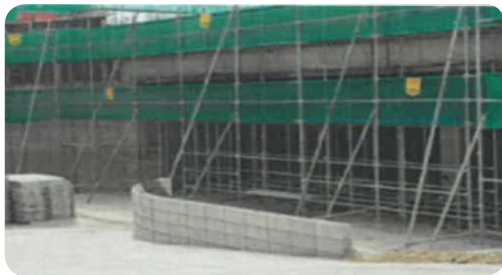
- 주차장 주출입구 작업자 보행통로용 표지판 설치
