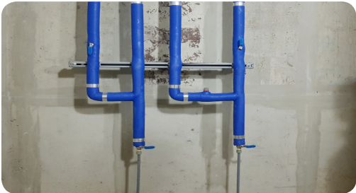
- 바닥 위 1.5m 높이에 조경용 배관 및 퇴수밸브 설치
