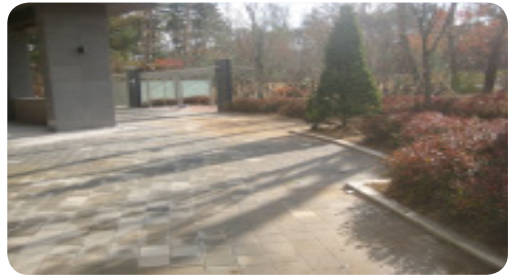
- 보도블록 구배 조정 및 집수정 신설로 물고임 제거
