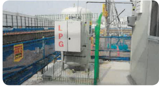
- LPG 저장소 주변 펜스 설치 완료
