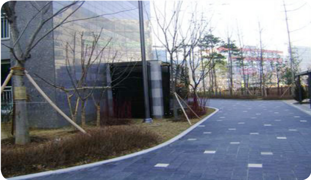
-보행로에 접한 드라이 에어리어(D/A) 배기 부분 공기 유도 패널 설치
