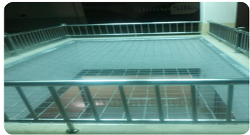
- 지하주차장 자연채광 도입 부분 하부 안전 시설 (추락 방지 그물망) 설치
