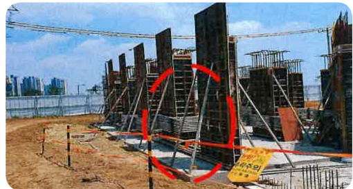
- 버팀대 설치 완료
