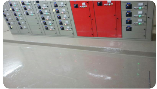
- 전기실·기계실 바닥 에폭시(우레탄) 도장 마감 처리
