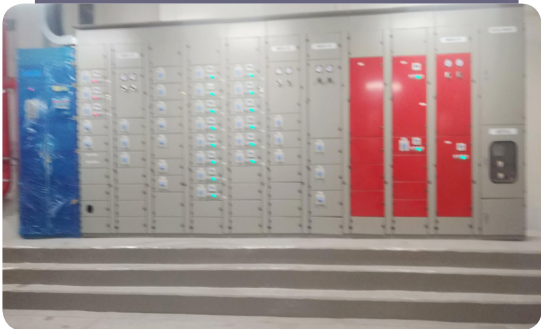
MCC반 침수 피해 최소화 위하여 높은 위치에 시공
