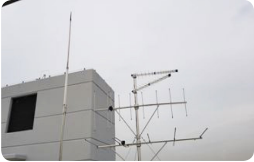
- 안테나 간 이격거리 유지 및 피뢰설비 높이 조정 시공
