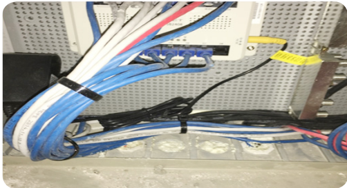
- 외부 인입 관로 결로방지용 코킹 시공
