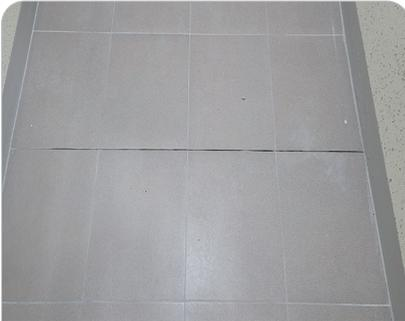
▲ E/V홀 및 복도 등 장스판 타일 시공 부위 E/J 설치 후 실란트 시공으로 타일 신축에 따른 파손 방지
