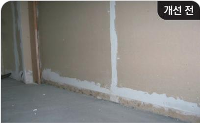
▲ 기포 콘크리트 타설, 방바닥 미장 시 석고보드 흡습에 따른 곰팡이 발생
