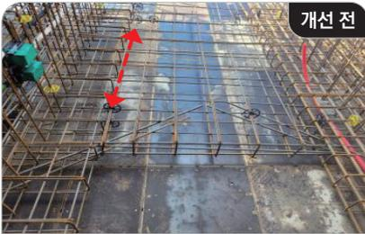
▲ 스페이스 규격 및 설치 간격 미준수로 피복두께 불량
