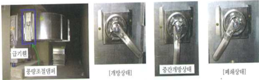
풍량조절댐퍼 설치외형 및 댐퍼조작 전.중.후 모습
