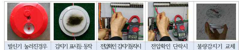
발신기 눌러진경우 감지기 표시등 동작 전압확인 감지기동작시 전압확인 단락시 불량감지기 교체
